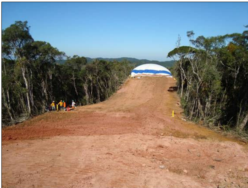
FOTO 2.6.11-124: Recomposição Mecânica da faixa de servidão após a execução da desmobilização da cobertura insuflável no km 09+500 (Fonte: Petrobras, jun/10).
