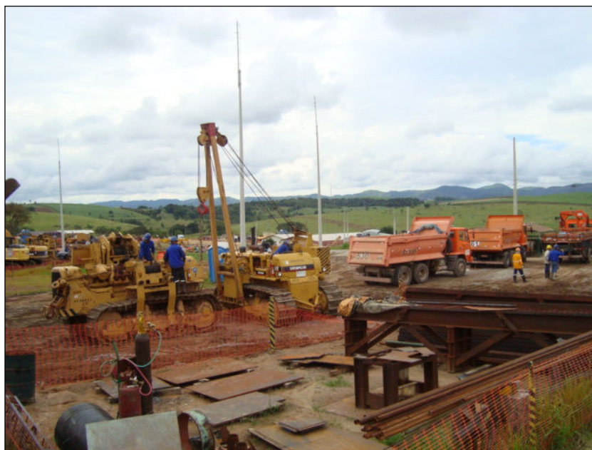
FOTO 2.6.11-50: Área de execução de curvamento de tubos no canteiro central do Consórcio Gastau (Fonte: Lenc, mar/10).
