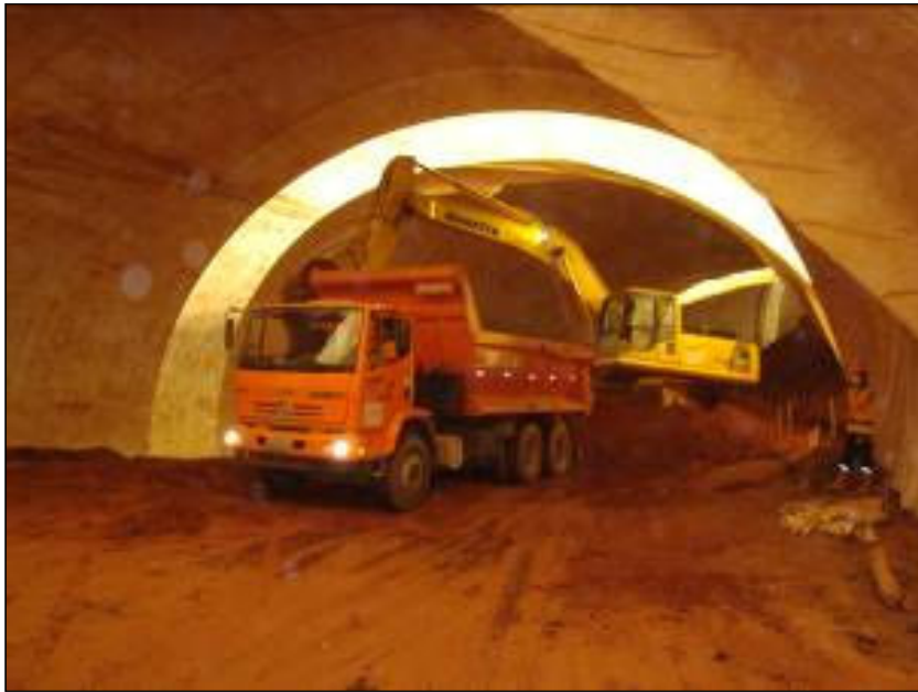
FOTO 2.6.11-113: Movimentação de máquinas dentro da cobertura insuflável, no trecho entre o km 08+300 e km 11+600 (Fonte: Remma Consórcio Gastau, mar/10).
