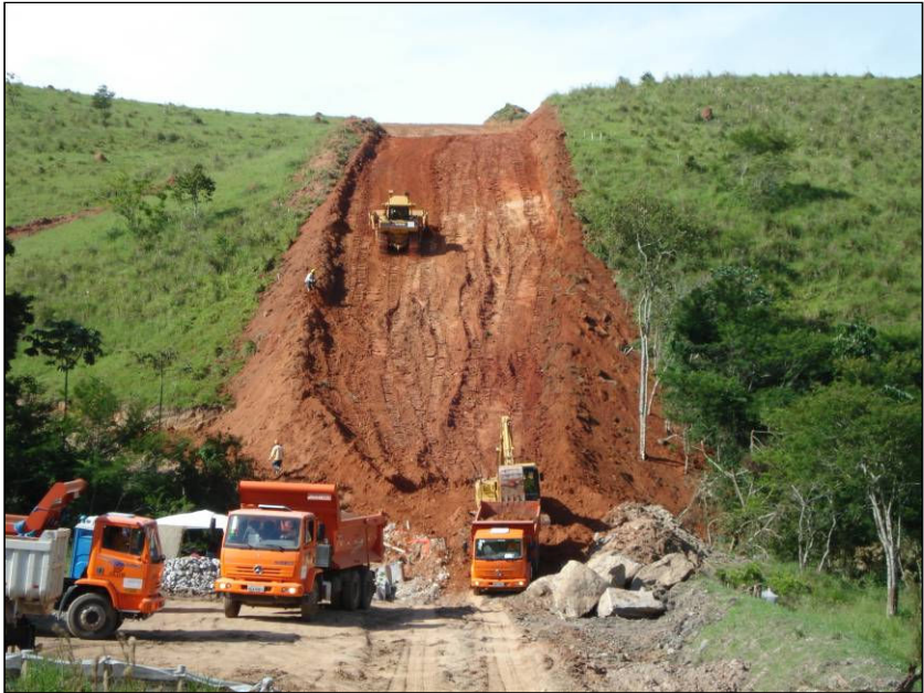
FOTO 2.6.11-43: Atividade de terraplenagem no km 50+000 (Fonte: Remma Consórcio Gastau, jan/10).
