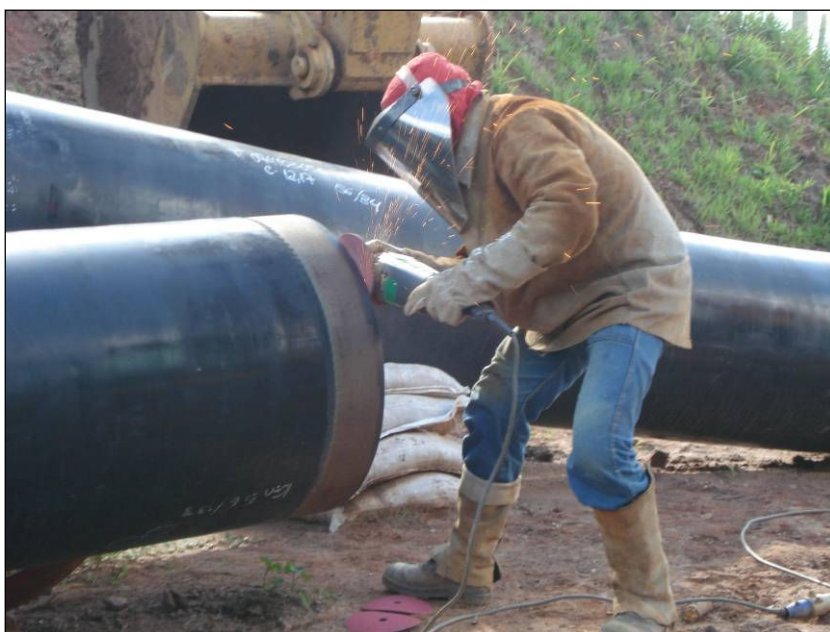
FOTO 2.6.11-52: Biselamento do tubo, km 56+300 da faixa (Fonte: Remma Consórcio Gastau, jan/10).
