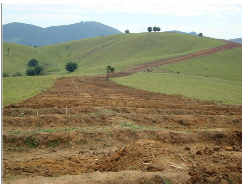
FOTO 2.6.11-63: Reconposição mecânica no km 31+500 da faixa (Fonte: Remma Consórcio Gastau, mai/10).
