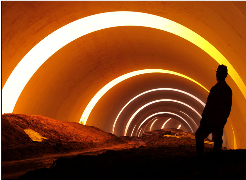
FOTO 2.6.11-112: Vista interna da cobertura no trecho entre o km 08+300 e km 11+600 da faixa (Fonte: Petrobras, fev/10).
