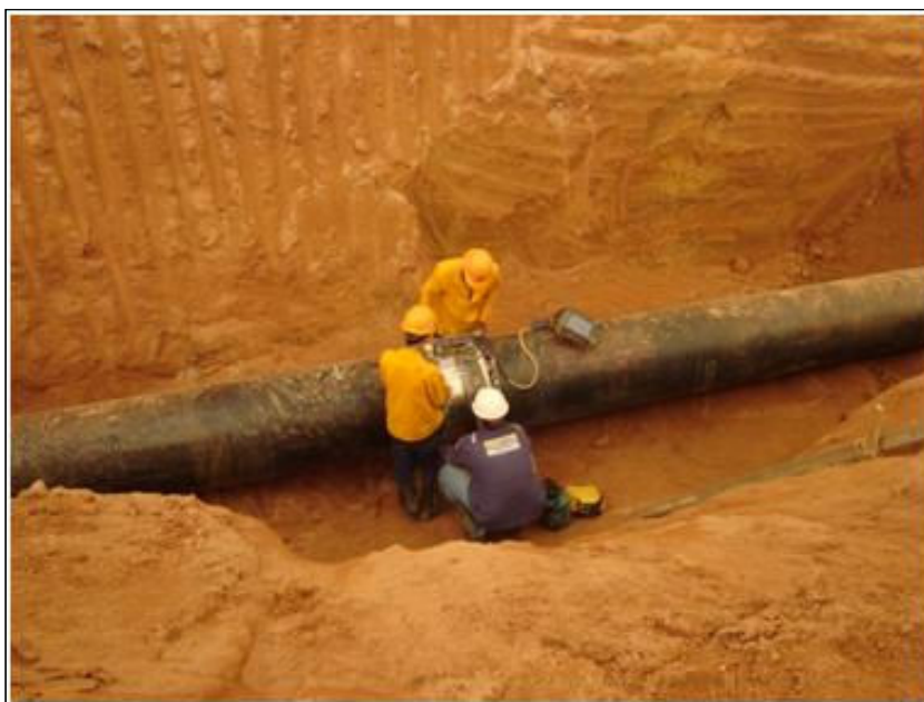
FOTO 2.6.11-53: Atividade de ultra-som realizada no km 8+400 (Fonte: Remma Consórcio Gastau, abr/10).
