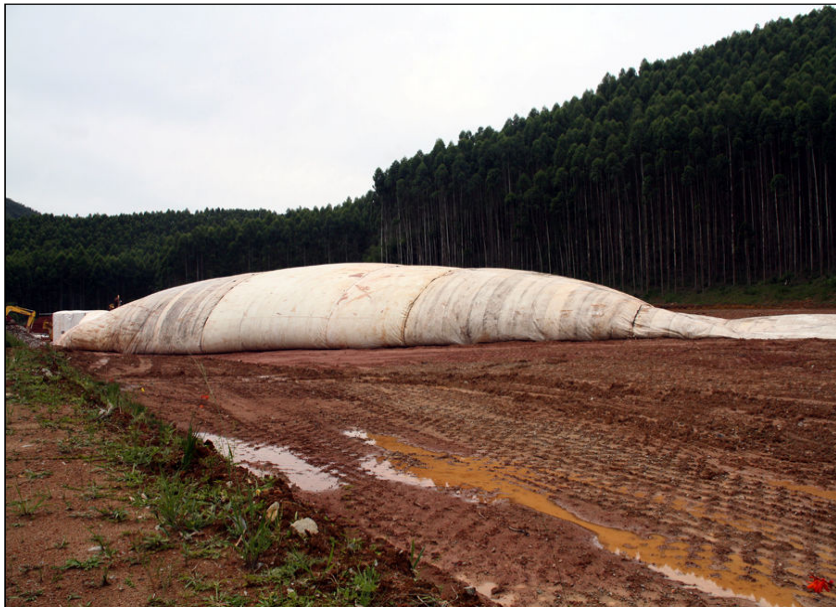
FOTO 2.6.11-109: Insuflamento da cobertura no bota-fora 03B (Fonte: Petrobras, jan/10).
