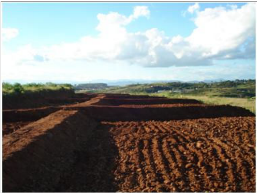
FOTO 2.6.11-65: Leiras instaladas no km 65+000 da faixa (Fonte: Remma Consórcio Gastau, abr/10).
