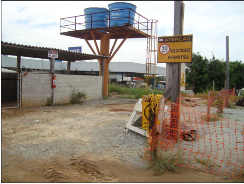
FOTO 2.6.11-20: Sinalização de limite de velocidade no canteiro central da GDK (Fonte: Lenc, mar/10).
