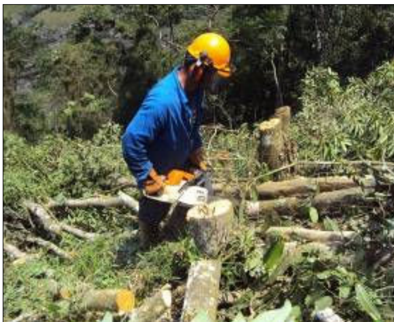
FOTO 2.6.11-40: Atividade de supressão vegetal no km 22+050 da faixa (Fonte: Remma Consórcio Gastau, fev/10).
