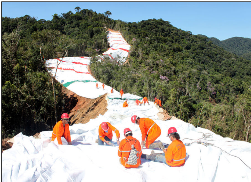
FOTO 2.6.11-107: Desfile e montagem das lonas no trecho entre o km 08+300 e km 11+600 da faixa (Fonte: Petrobras, fev/10).
