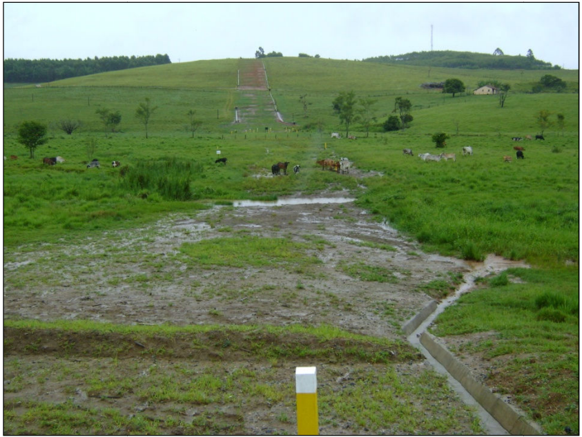
FOTO 2.6.11-71: Vista da faixa recomposta, km 86+660 da faixa (Fonte: Remma GDK, mar/10).
