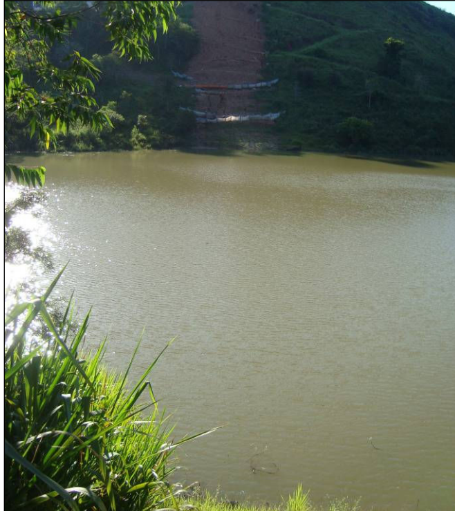
FOTO 2.6.11-86: Travessia da represa Santa Branca, coordenadas em UTM: N=7.415.640/E=425.621 (Fonte: Lenc, mar/10).
