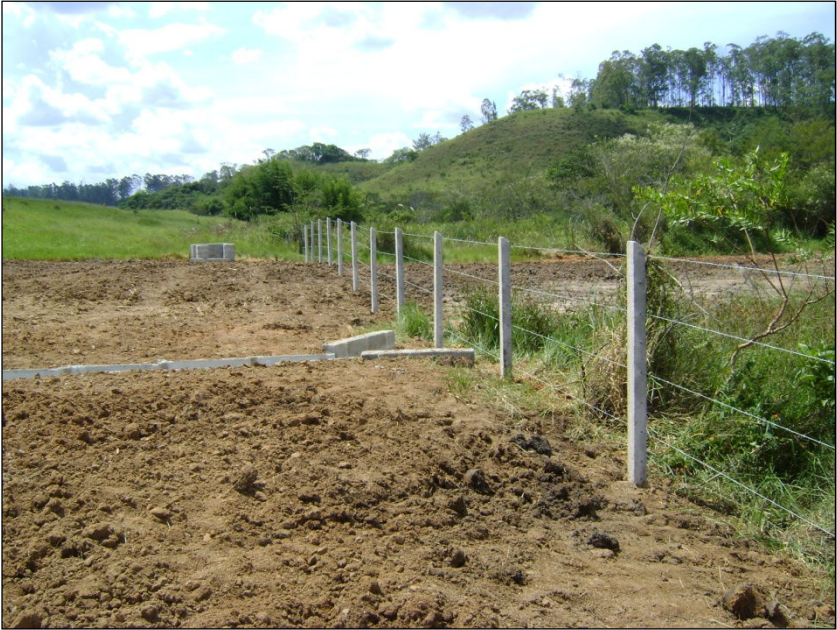
FOTO 2.6.11-67: Restauração de cercas e implantação de sistema de drenagem no km 67+160 da faixa (Fonte: Remma GDK, fev/10).
