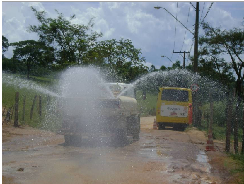
FOTO 2.6.11-37: Aspersão de água por meio de caminhão pipa na Estrada Joel de Paula (Fonte: Remma GDK, fev/10).
