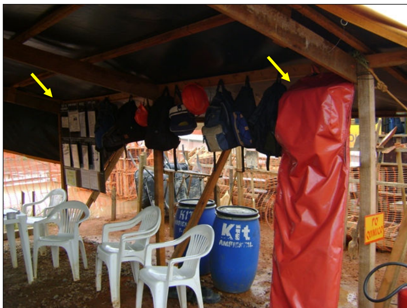
FOTO 2.6.11-30: Maca e informativo de SMS na área de vivência, km 67+500 da faixa (Fonte: Remma GDK, jan/10).
