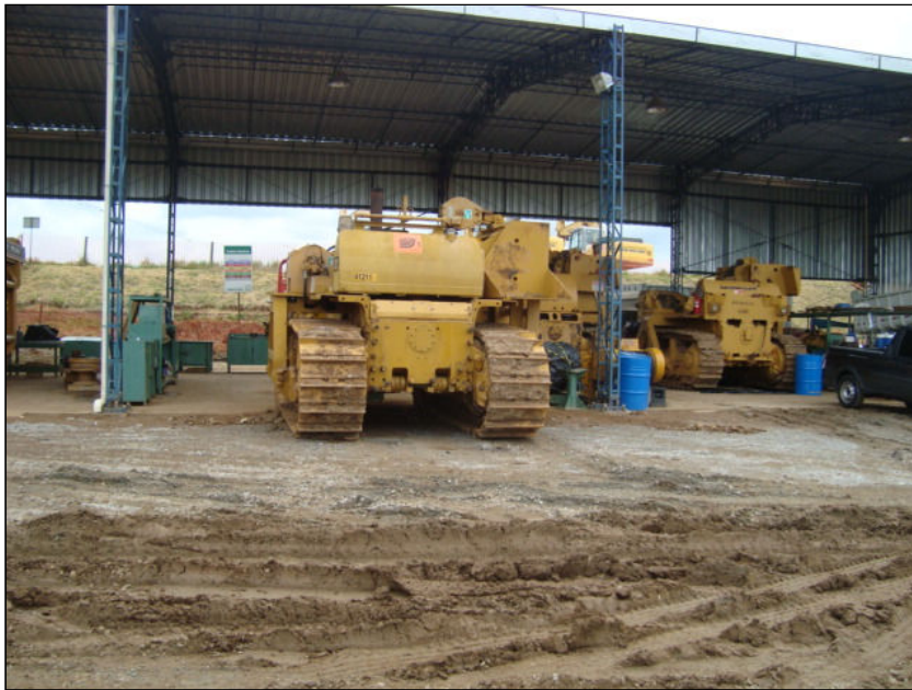
FOTO 2.6.11-10: Área de manutenção de máquinas e veículos no canteiro central do Consórcio Gastau (Fonte: Lenc, mar/10).
