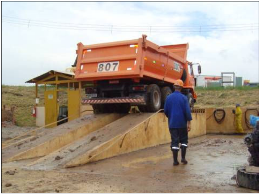
FOTO 2.6.11-11: Área de lavagem de veículos no canteiro central do Consórcio Gastau (Fonte: Lenc, mar/10).
