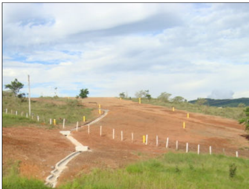
FOTO 2.6.11-73: Marcos de sinalização e sistema de drenagem definitivo instalados no km 61+700 da faixa (Fonte: Lenc, mar/10).
