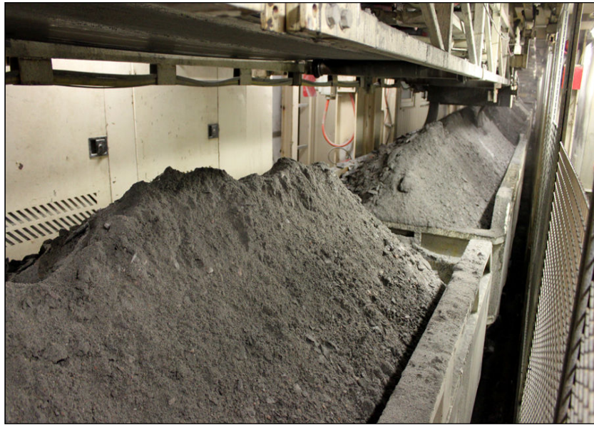
FOTO 2.6.11-95: Lançamento do material escavado pela tuneladora nos vagões para posterior deposição em área adjacente ao emboque do túnel (Fonte: Petrobras, mar/10).
