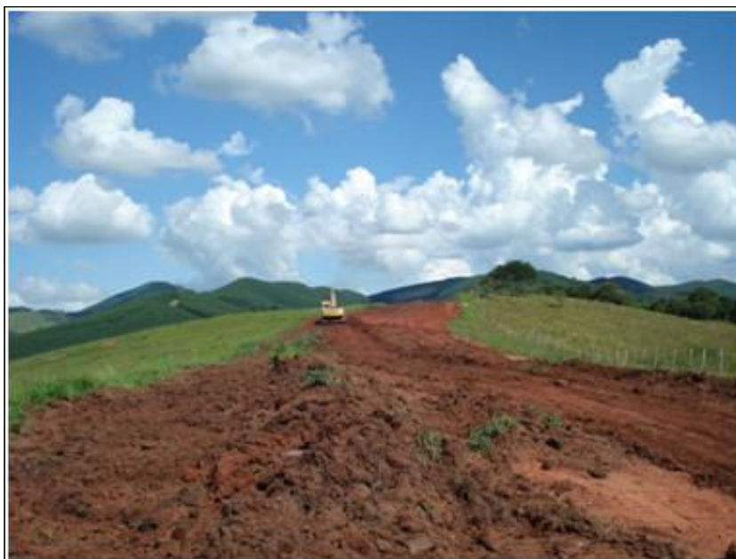
FOTO 2.6.11-61: Reincorporação do top-soil na faixa, km 41 (Fonte: Remma Consórcio Gastau, mar/10).
