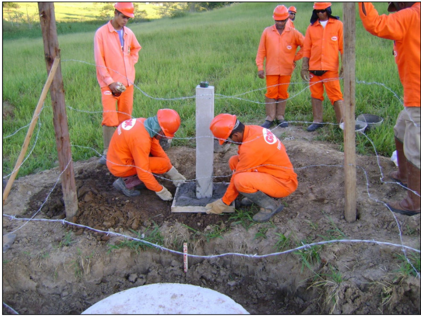
FOTO 2.6.11-77: Instalação de marco de sinalização de fibra ótica no km 72+160 da faixa (Fonte: Remma GDK, mar/10).
