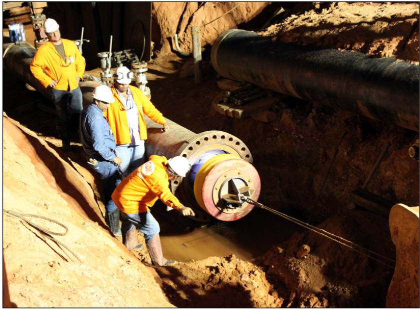
FOTO 2.6.11-57: Retirada do pig no interior do duto (Fonte: Petrobras, fev/10).
