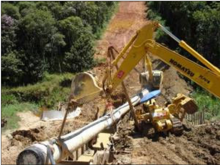
FOTO 2.6.11-79: Utilização de tubulação revestida de concreto para travessia no km 17+980 (Fonte: Remma Consórcio Gastau, fev/10).
