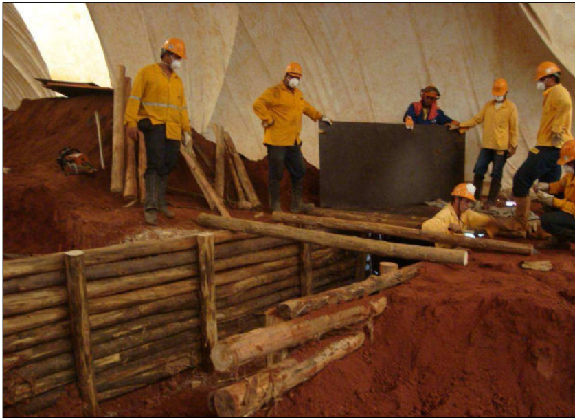
FOTO 2.6.11-118: Colocação de toras de madeira para sustentação da passagem (Fonte: Petrobras, abr/10).
