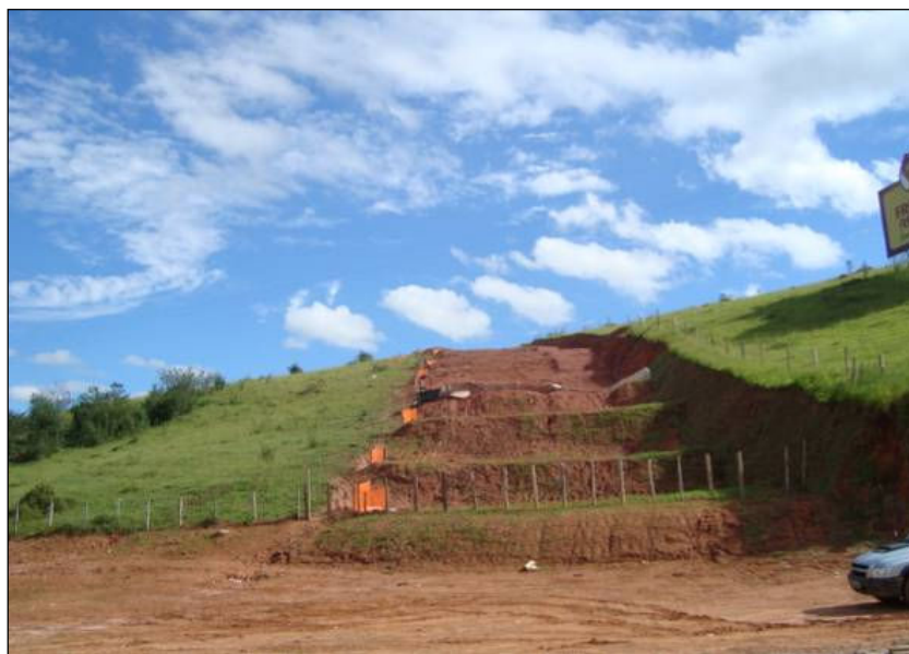
FOTO 2.6.11-39: Cerca mantida fechada na faixa de duto, km 55+500 (Fonte: Lenc, mar/10).
