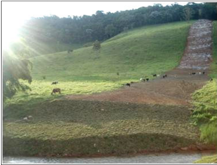
FOTO 2.6.11-81: Recuperação das margens de curso d'água, km 41+900 da faixa (Fonte: Remma Consórcio Gastau, abr/10).
