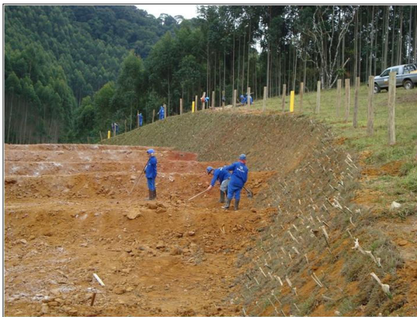
FOTO 2.6.11-62: Reconposição vegetal e restauração de cerca no km 21+600 da faixa (Fonte: Remma Consórcio Gastau, mai/10).
