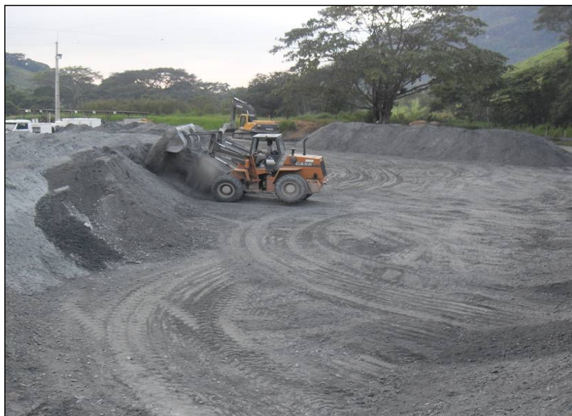
FOTO 2.6.11-96: Área de armazenamento temporário do material escavado (bota-espera), coordenadas em UTM: N=7.385.541 / E=446.415 (Fonte: Remma Schahin, abr/10).
