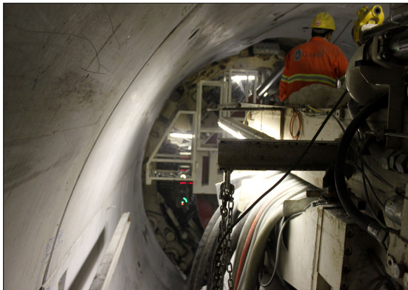
FOTO 2.6.11-92: Atividade de escavação do túnel, parte frontal da tuneladora (Fonte: Petrobras, mar/10).
