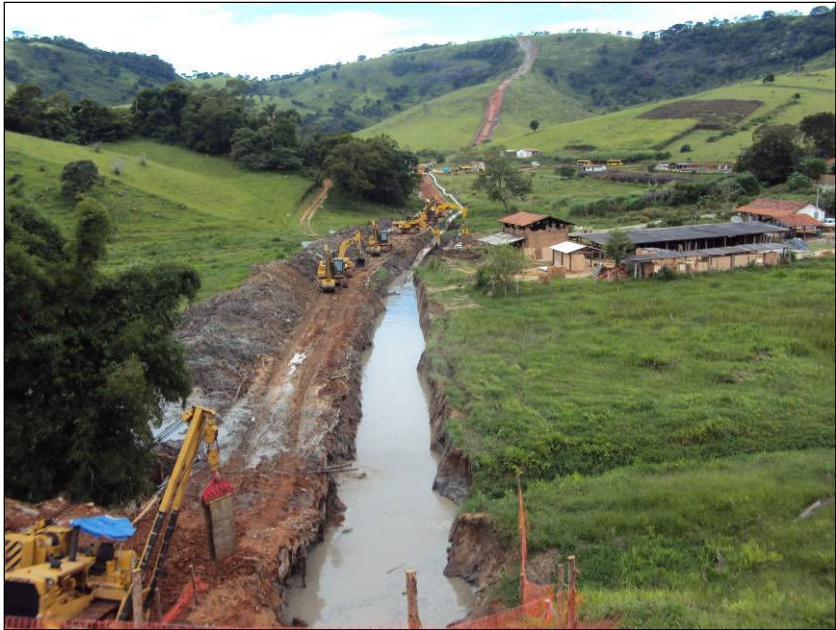
FOTO 2.6.11-80: Execução de travessia no afluente do Ribeirão do Lajeado, Km 26+000 (Fonte: Consórcio Gastau, jan/10).
