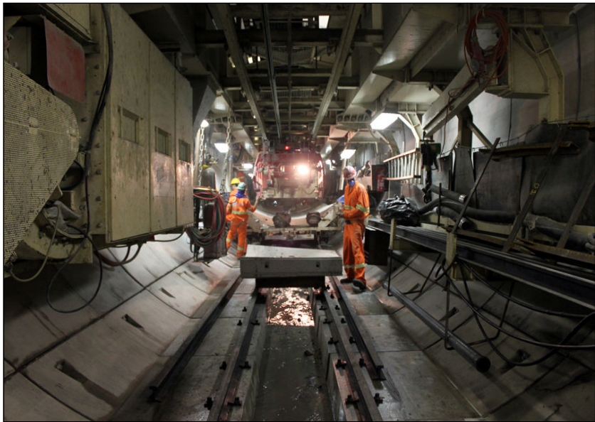
FOTO 2.6.11-94: Vista interna da tuneladora em operação (Fonte: Petrobras, mar/10).
