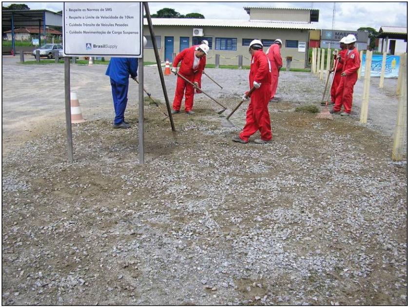
FOTO 2.6.11-2: Canteiro da Brasil Supply, localizado no Município de Pindamonhangaba (Fonte: Remma Brasil Supply, jan/10).
