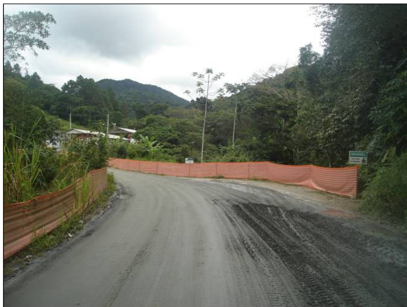
FOTO 2.6.11-18: Sinalização e contenções implantadas no acesso ao canteiro central da Schahin, coordenadas em UTM: N=7.385.760/E=446.477 (Fonte: Remma Schahin, abr/10).
