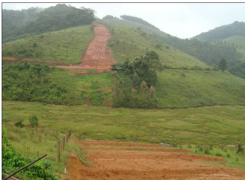
FOTO 2.6.11-90: Travessia do Rio Lourenço Velho II apresentando desenvolvimento de vegetação, km 15+800 (Fonte: Lenc, mar/10).
