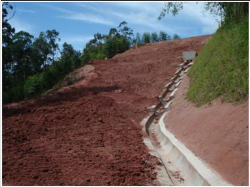
FOTO 2.6.11-64: Instalação de sistema de drenagem definitivo no km 46 da faixa (Fonte: Remma Consórcio Gastau, mar/10).
