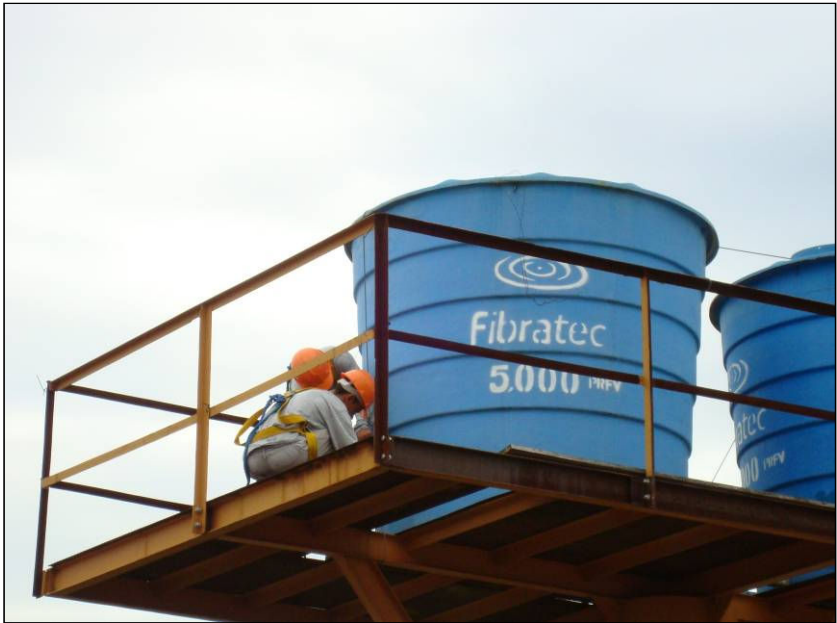
FOTO 2.6.11-24: Limpeza de caixa d'água no canteiro da GDK (Fonte: Remma GDK, jan/10).
