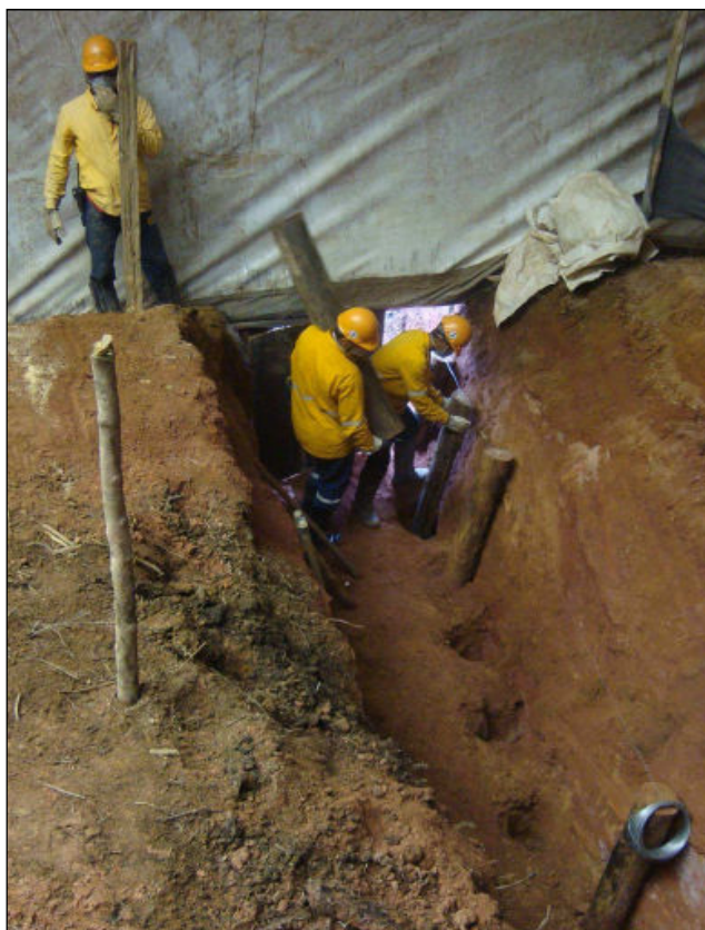
FOTO 2.6.11-117: Fase inicial da construção de passagem de fauna (Fonte: Petrobras, abr/10).
