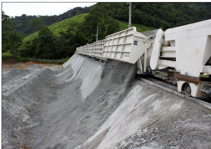
FOTO 2.6.11-97: Detalhe da deposição do material escavado do túnel no bota-espera, por meio de sistema tombador de vagões (Fonte: Remma Schahin, fev/10).
