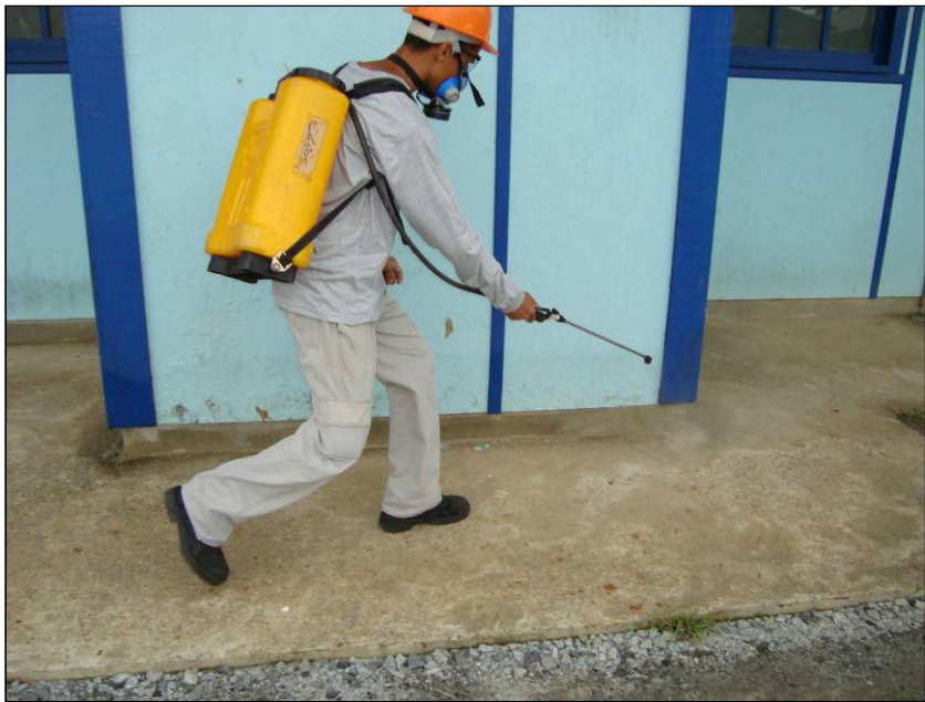
FOTO 2.6.11-22: Desinsetização realizada no canteiro da GDK (Fonte: Remma GDK, jan/10).
