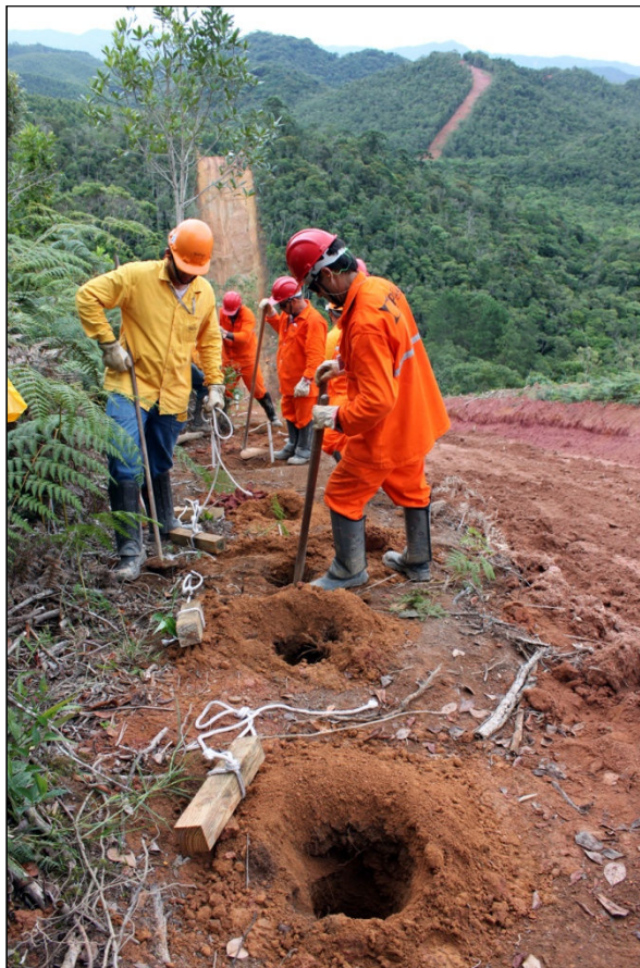
FOTO 2.6.11-104: Estaqueamento da cobertura insuflável no trecho entre o km 08+300 e km 11+600 da faixa (Fonte: Petrobras, jan/10).
