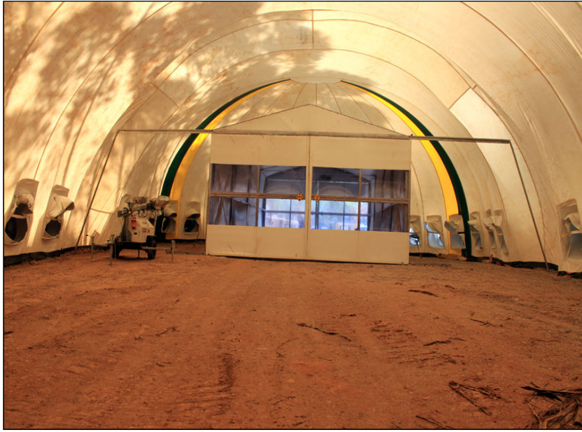
FOTO 2.6.11-111: Vista interna da entrada da cobertura no trecho entre o km 08+300 e km 11+600, após a insuflação (Fonte: Petrobras, fev/10).
