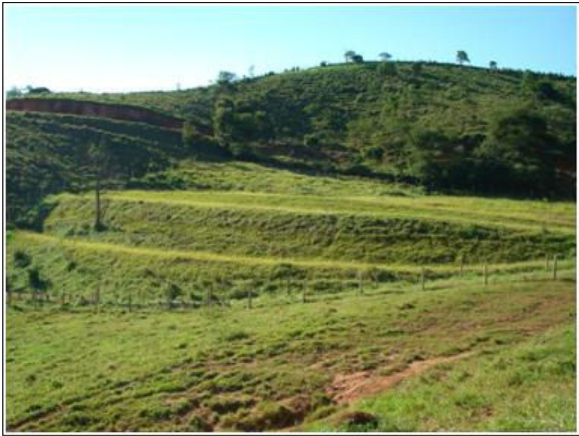
FOTO 2.6.11-47: Vista geral do bota-fora 18B finalizado, coordenadas em UTM: N=7.422.277/E=423.446 (Fonte: Remma Consórcio Gastau, abr/10).
