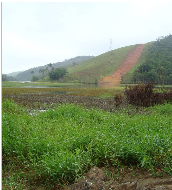
FOTO 2.6.11-88: Travessia do Rio Lourenço Velho I, km 13+820 (Fonte: Lenc, mar/10).
