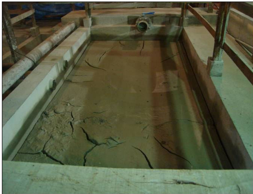
FOTO 2.6.11-101: Vista do leito de secagem, coordenadas em UTM: N=7.385.818/E= 446.254 (Fonte: Remma Schahin, abr/10).
