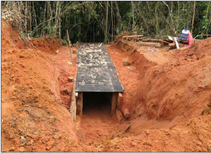
FOTO 2.6.11-120: Cobertura da cabeceira de passagem de fauna (Fonte: Petrobras, abr/10).
