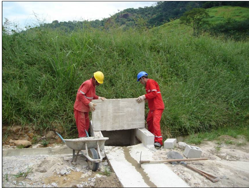
FOTO 2.6.11-25: Manutenção do sistema de drenagem superficial no canteiro operacional da Schahin (Fonte: Remma Schahin, jan/10).
