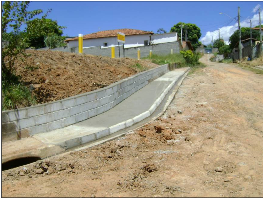
FOTO 2.6.11-68: Restauração de calçada no km 73+160 (Fonte: Remma GDK, fev/10).
