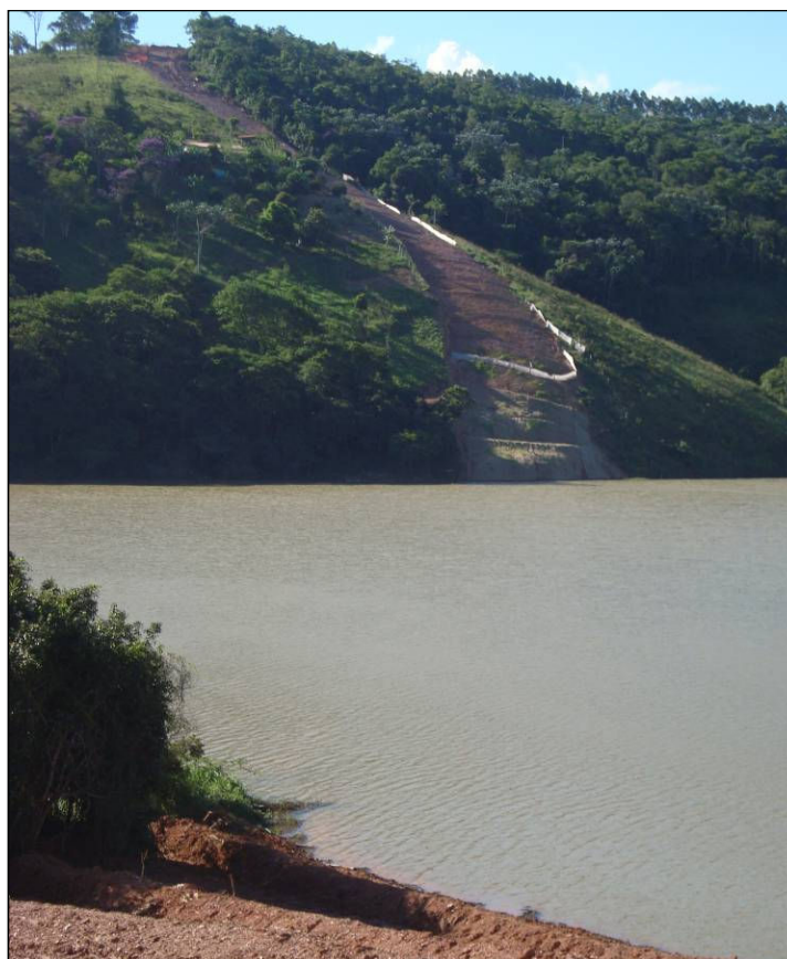
FOTO 2.6.11-83: Travessia do rio Paraíba do Sul, coordenadas em UTM: N=7.417.333/E=424.460 (Fonte: Lenc, mar/10).
