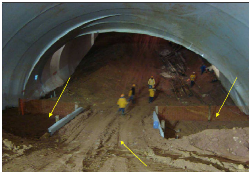
FOTO 2.6.11-122: Vista geral de passagem de fauna construída sob a cobertura insuflável (Fonte: Petrobras, abr/10).
