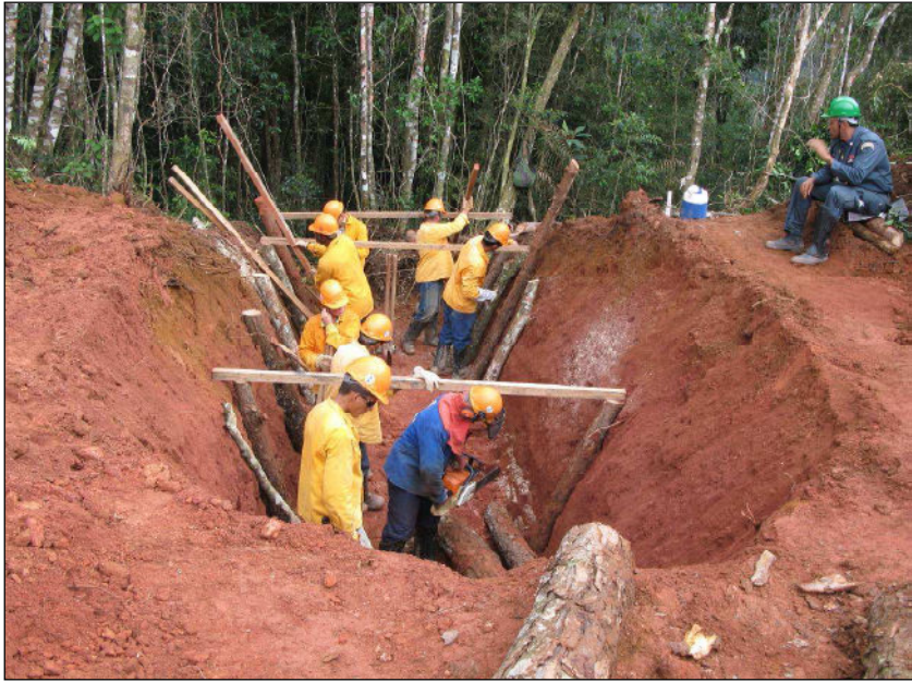
FOTO 2.6.11-119: Construção da cabeceira de passagem de fauna (Fonte: Petrobras, abr/10).
