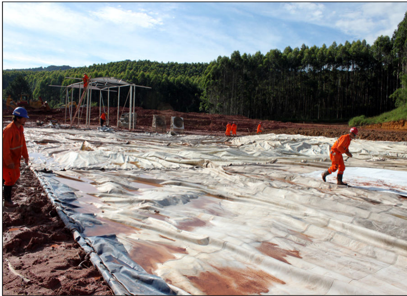
FOTO 2.6.11-106: Ancoragem das lonas no bota-fora 03B (Fonte: Petrobras, jan/10).
