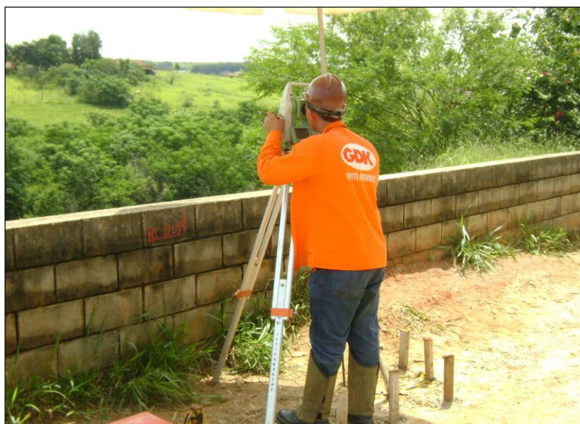
FOTO 2.6.11-38: Atividade de topografia no km 72+160 (Fonte: Remma GDK, jan/10).
