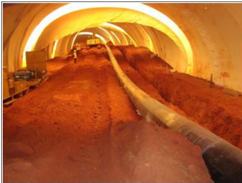
FOTO 2.6.11-114: Atividade de abertura de vala e abaixamento de duto dentro da cobertura insuflável, no trecho entre o km 08+300 e km 11+600 (Fonte: Remma Consórcio Gastau, mar/10).
