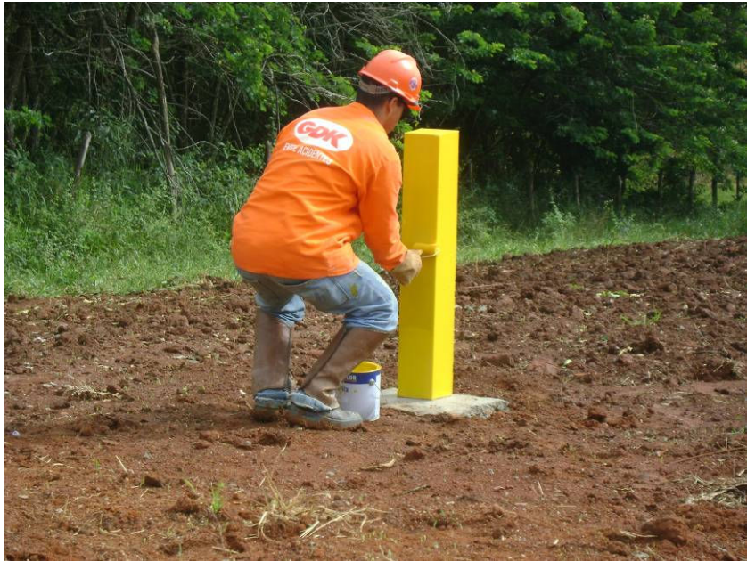
FOTO 2.6.11-76: Instalação de marco de sinalização no km 72+160 da faixa (Fonte: Remma GDK, fev/10).
