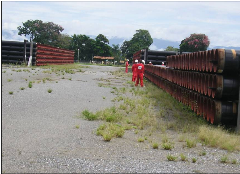
FOTO 2.6.11-21: Manutenção da área de armazenamento de tubos, no canteiro da Brasil Supply (Fonte: Remma Brasil Supply, jan/10).
