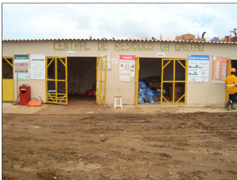
FOTO 2.6.11-17: Armazenamento de resíduos no canteiro central do Consórcio Gastau (Fonte: Lenc, mar/10).
