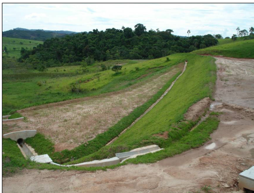
FOTO 2.6.11-46: Dispositivo de drenagem definitivo no bota-fora 12A, coordenadas em UTM: N=7.415.647 E=429.249 (Fonte: Remma Consórcio Gastau, jan/10).
