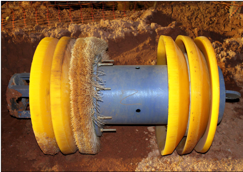
FOTO 2.6.11-58: Detalhe do pig utilizado na limpeza interna do duto (Fonte: Petrobras, fev/10).
