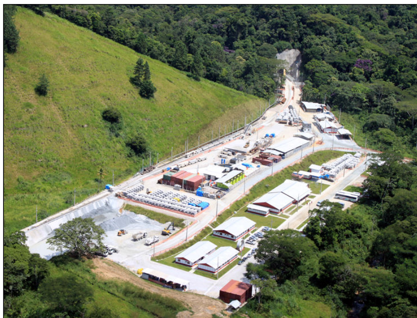
FOTO 2.6.11-4: Canteiro da Schahin Engenharia, localizado no Município de Caraguatatuba (Fonte: Petrobras, fev/10).
