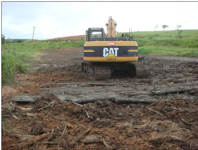
FOTO 2.6.11-82: Retirada de estiva no km 79+160 da faixa (Fonte: Remma GDK, jan/10).
