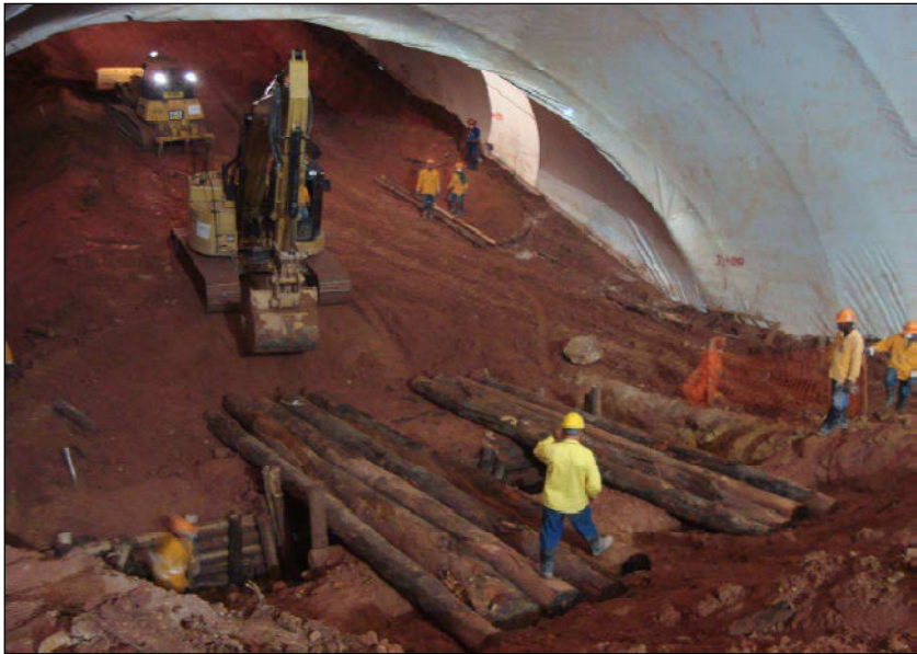
FOTO 2.6.11-121: Construção de ponte para locomoção de máquinas e veículos sobre a passagem de fauna (Fonte: Petrobras, abr/10).
