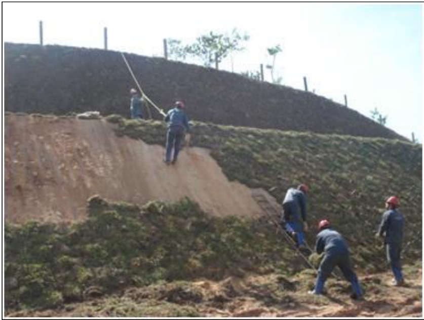
FOTO 2.6.11-66: Plantio de grama em placa em talude de corte, km 65 da faixa (Fonte: Remma Consórcio Gastau, abr/10).
