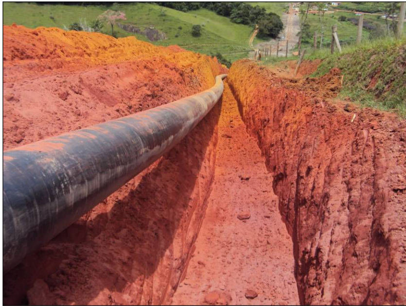
FOTO 2.6.11-54: Abaixamento da tubulação, km 27+100 (Fonte: Remma Consórcio Gastau, jan/10).
