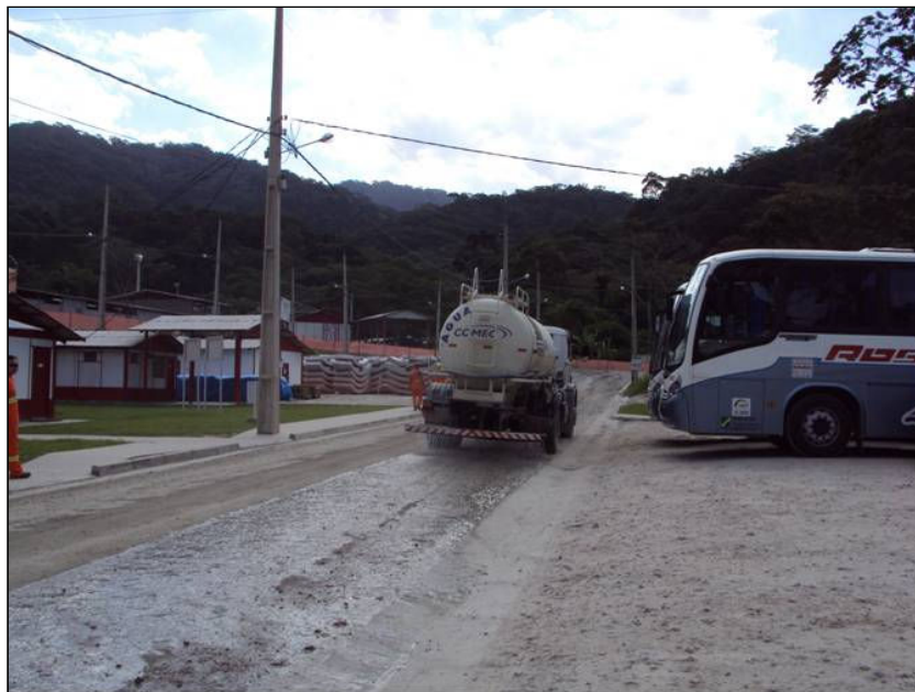
FOTO 2.6.11-26: Controle de poeira por meio de caminhão-pipa no canteiro operacional da Schahin (Fonte: Remma Schahin, abr/10).
