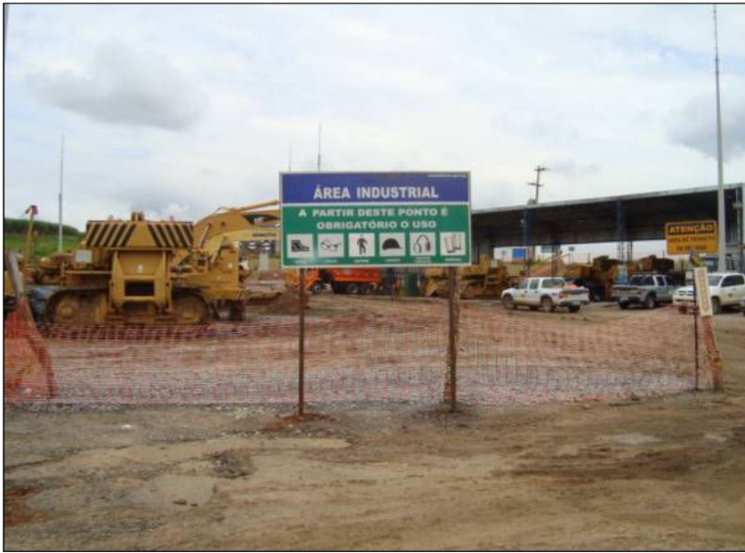
FOTO 2.6.11-19: Sinalização de SMS implantada no canteiro central do Consórcio Gastau (Fonte: Lenc, mar/10).
