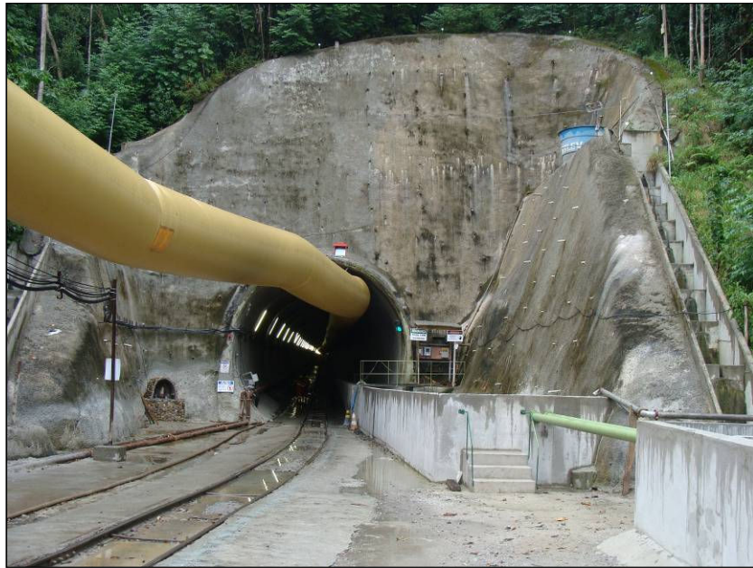
FOTO 2.6.11-91: Vista geral do emboque do túnel, coordenadas em UTM: N=7.385.819/E=446.242 (Fonte: Lenc, mar/10).
