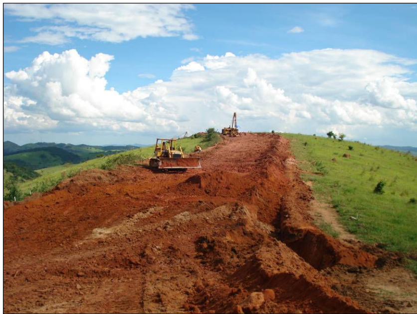
FOTO 2.6.11-55: Cobertura da vala, km 55+000 (Fonte: Remma Consórcio Gastau, jan/10).
