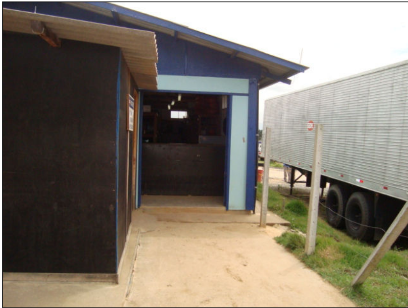
FOTO 2.6.11-9: Almojarifado do canteiro central da GDK (Fonte: Lenc, mar/10).
