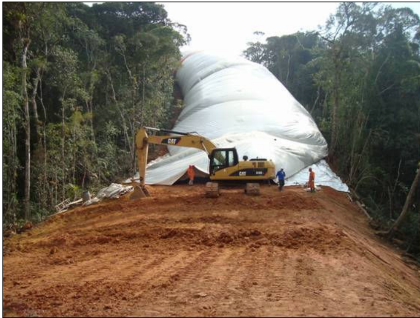
FOTO 2.6.11-123: Início da desmobilização da cobertura insuflável no km 09+500, após a passagem do duto (Fonte: Petrobras, jun/10).
