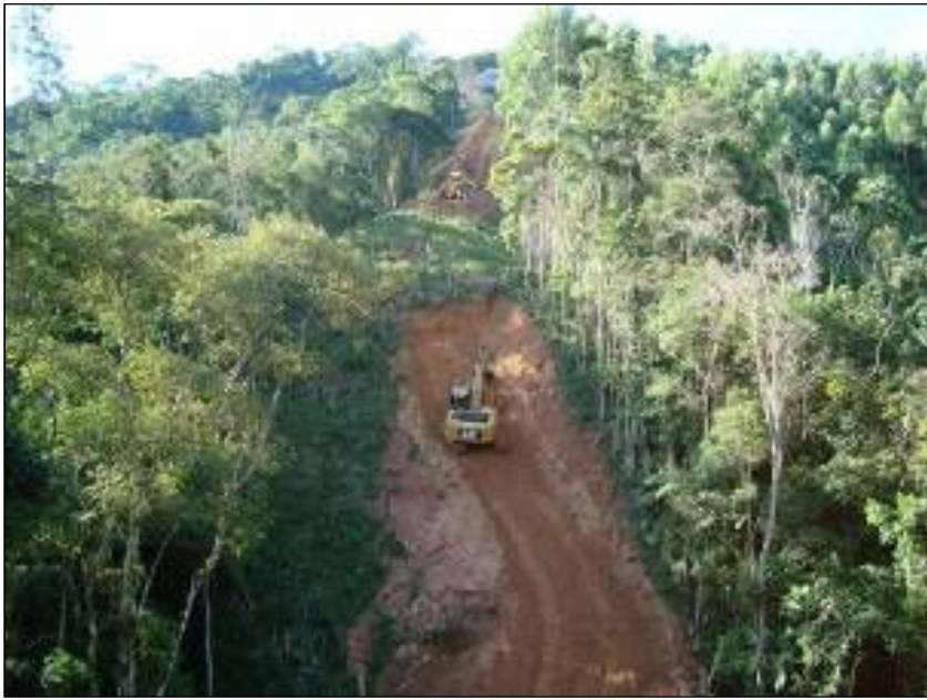
FOTO 2.6.11-42: Abertura de pista no km 22+000 da faixa (Fonte: Remma Consórcio Gastau, fev/10).
