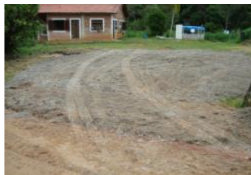
Melhoria realizada na entrada da residência do Sr. Adail.
