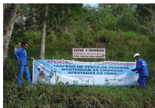
Funcionários do Consórcio Gastau instalam faixa de Comunicação na Estrada do Pavoeiro
