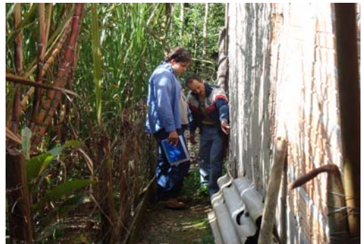
Sr. Tico mostra o local que deseja colocar as canaletas
