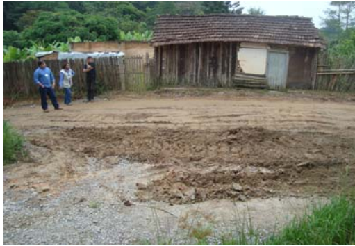
Acesso logo após a passagem do maquinário
