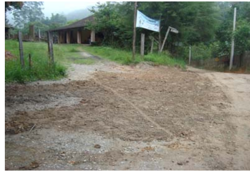
Acesso depois da manutenção realizada pela equipe do Encarregado Poerinha
