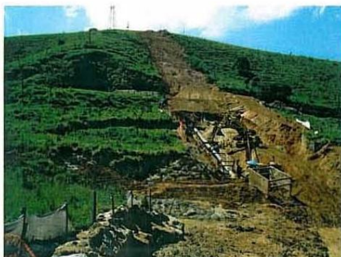
Área adicional 01, fora da faixa, utilizada para armazenamento de solo da vala durante a atividade de abertura de vala e abaixamento da coluna
