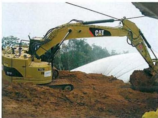
Foto 03 – Mitigação da área afetada
