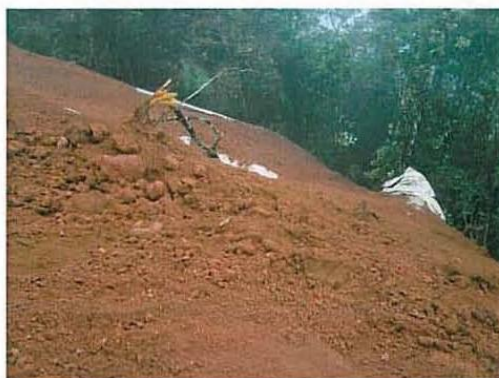
Foto 02 – Lateral da faixa - área impactada
