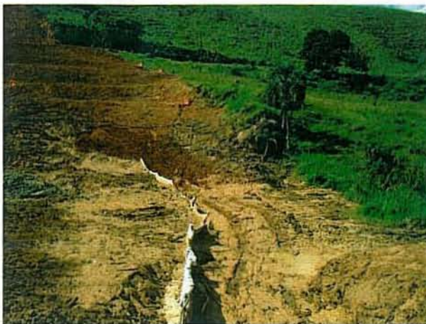
Vista da faixa com instalações de contenções
