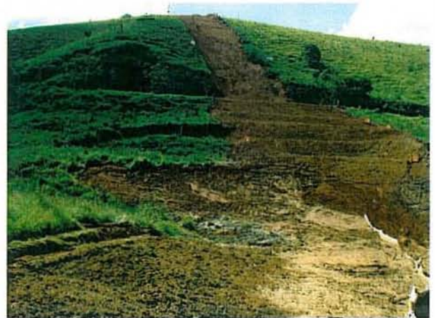
Área adicional 01, fora da faixa, após o término das atividades
