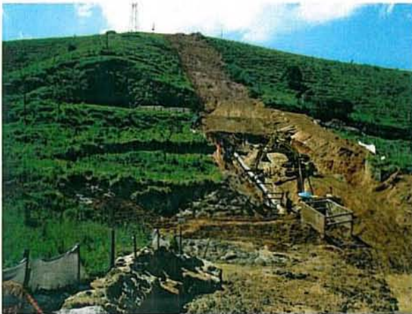
Área adicional 01, fora da faixa, utilizada para armazenamento de solo da vala durante a atividade de abertura de vala e abaixamento da coluna
