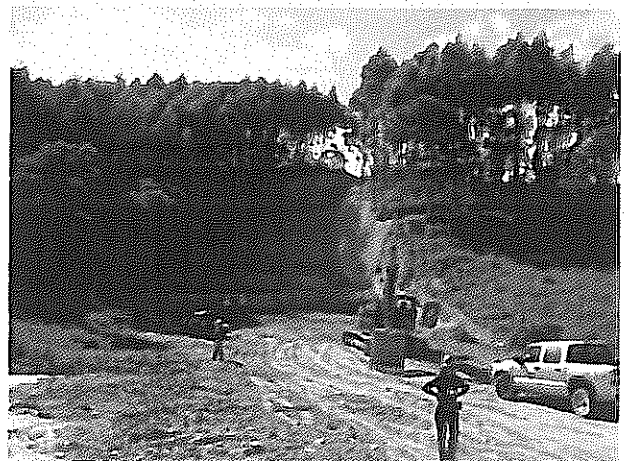
Obras no local
