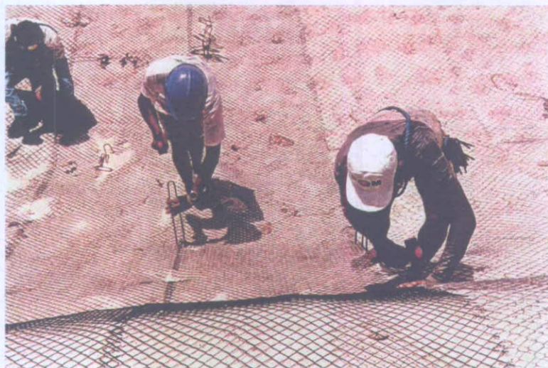
Figura 2 - Fixação da geogrelha no talude
