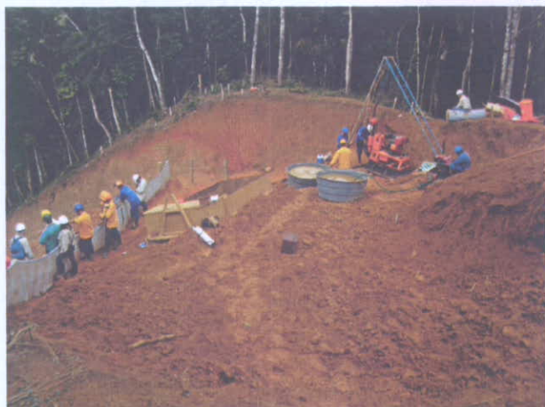
Sondagem mista para levantamento das condições do terreno
