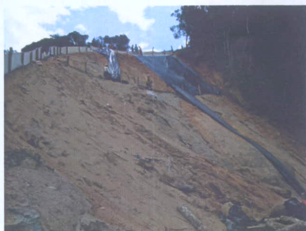
Instalação de lona plástica para proteção do talude colapsado
