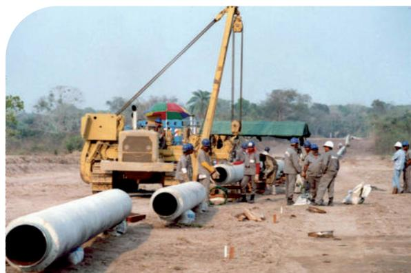
Jaquetas de concreto para sua proteção mecânica dos dutos nas áreas alagadas.
