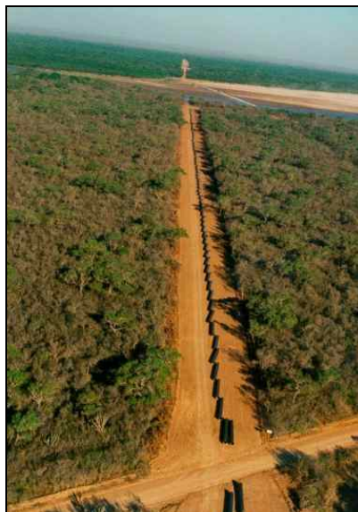
Figura II.7.4-6 - Desfile da Tubulação
