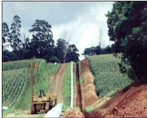
Figura II.7.4-4 - Abertura de Nivelamento de Faixa
