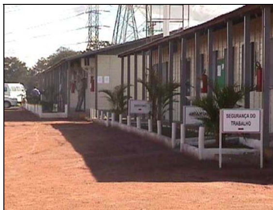
Figura II.7.4-1 - Tipo de canteiro fixo
