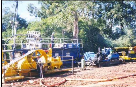
Figura II.7.4-13 - Perfuração em Área de Travessia
