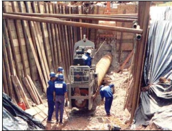
Figura II.7.4-12 - Obras em Travessia de Rodovia
