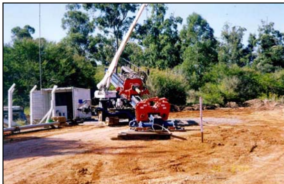
Figura II.7.4-14 - Equipamento para Furo Direcional
