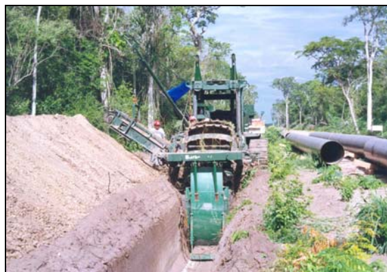
Figura II.7.4-5 - Abertura de Vala
