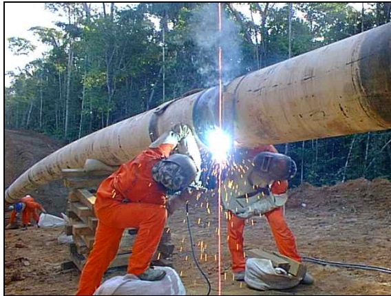
Figura II.7.4-7 - Soldagem da Tubulação
