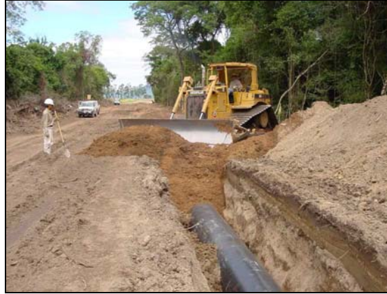
Figura II.7.4-8 - Cobertura da Vala
