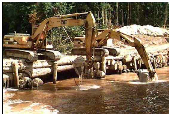
Figura II.7.4-15 - Método Destrutivo em Travessia de Rio
