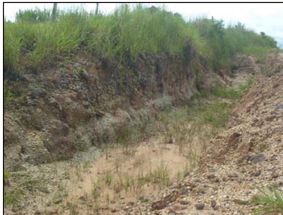
Foto 8 - Estrada apresentando erosão em sulco muito avançada. Coordenadas 5,0893S 48,7156W
