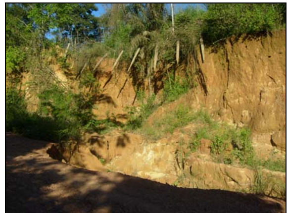
Foto 28 - Erosão por desbarrancamento em estrada no terço médio/superior de encosta em relevo ondulado com Latossolo Amarelo Distrófico textura argilosa (LAd3). Coordenadas 4,4087S 47,5024W
