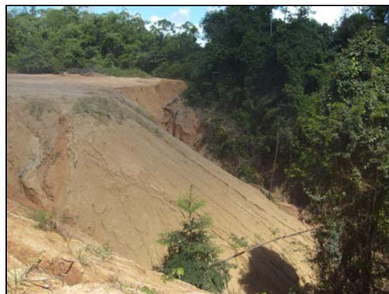
Foto 34 - Vista da estrada que esta em obra para asfaltamento. Grande movimento de terra. Os barrancos são cortados para alargar a estrada e a terra empurrada para a drenagem para elevar a estrada. Coordenadas 2,9738S 47,5767W
