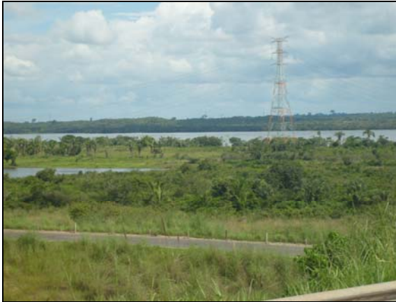
Foto 1 - Vista geral da área baixa (sujeita a inundação) na margem do Rio Tocantins, próximo a cidade de Marabá (PA). Margem Direita. Coordenadas 5,3007S 49,0721W
