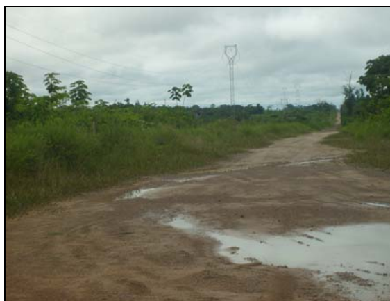
Foto 38 - Trecho do gasoduto que acompanha a faixa da Linha de Transmissão em área de Latossolo Amarelo Distrófico textura argilosa relevo plano (LAd12). Coordenadas 2,8566S 47,9348W
