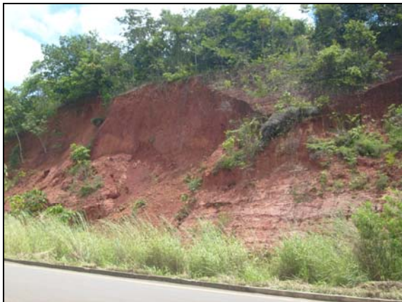
Foto 21 - Aspecto de erosão em barranco da estrada Belém- Brasília. Coordenadas 5,0471S 47,5522W
