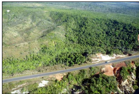
Figura II.5.1-35 - Voçorocas, a jusante da rodovia
