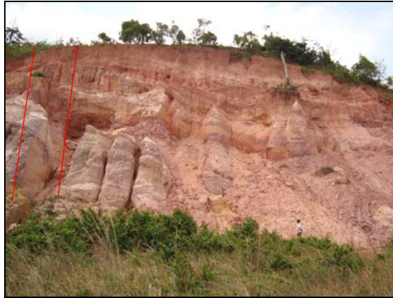
Figura II.5.1-45 - Corte de estrada, às margens da BR-010, com presença de movimentos de massa e queda de blocos. Há no afloramento a presença de fraturas sub-verticais (linhas em vermelho), perpendiculares ao acamamento sedimentar, que facilitam o avanço da frente de intemperismo e, conseqüentemente, a queda de blocos
