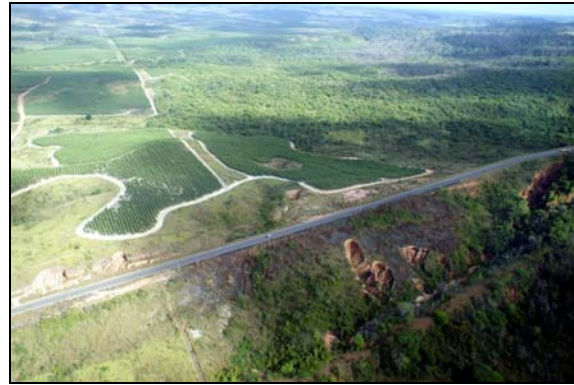
Figura II.5.1-33 - Voçorocas a jusante da rodovia
