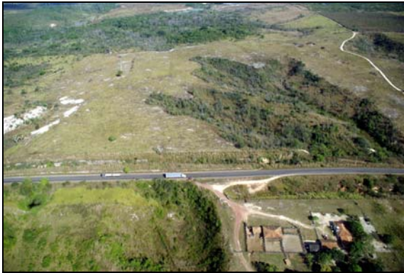
Figura II.5.1-32 - Cicatriz erosiva, a montante da estrada, recoberta por vegetação
