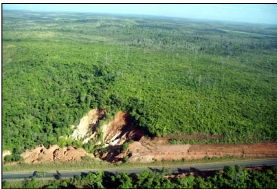
Figura II.5.1-34 - Voçorocas, a montante da rodovia
