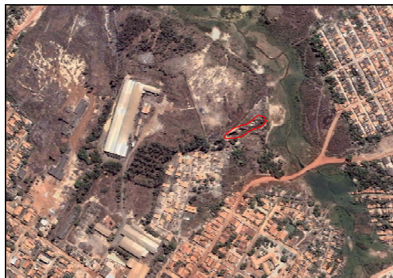
Figura II.5.1-36 - Imagem de satélite (31/07/2005 Digital Globe - Google Earth) da cidade de Açailândia com destaque para voçoroca (em vermelho) evoluindo em direção à área urbana da cidade
