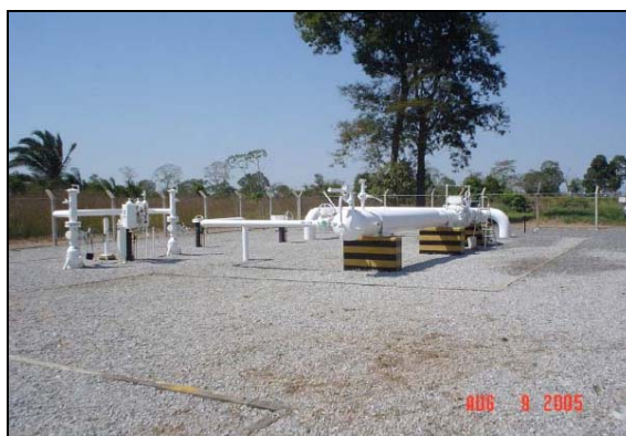
Figura II.2-3 - Exemplo de estação de limpeza
