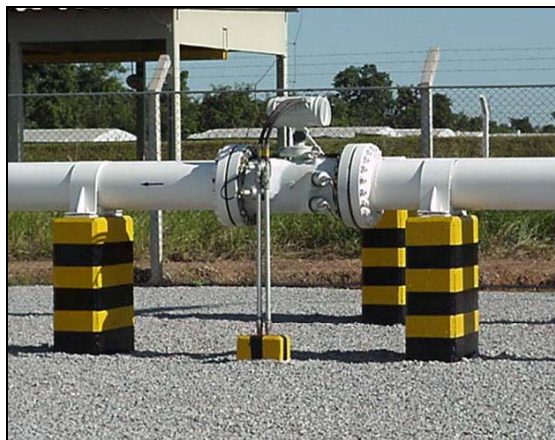
Figura II.2-2 - Vista de um medidor ultra-sônico
