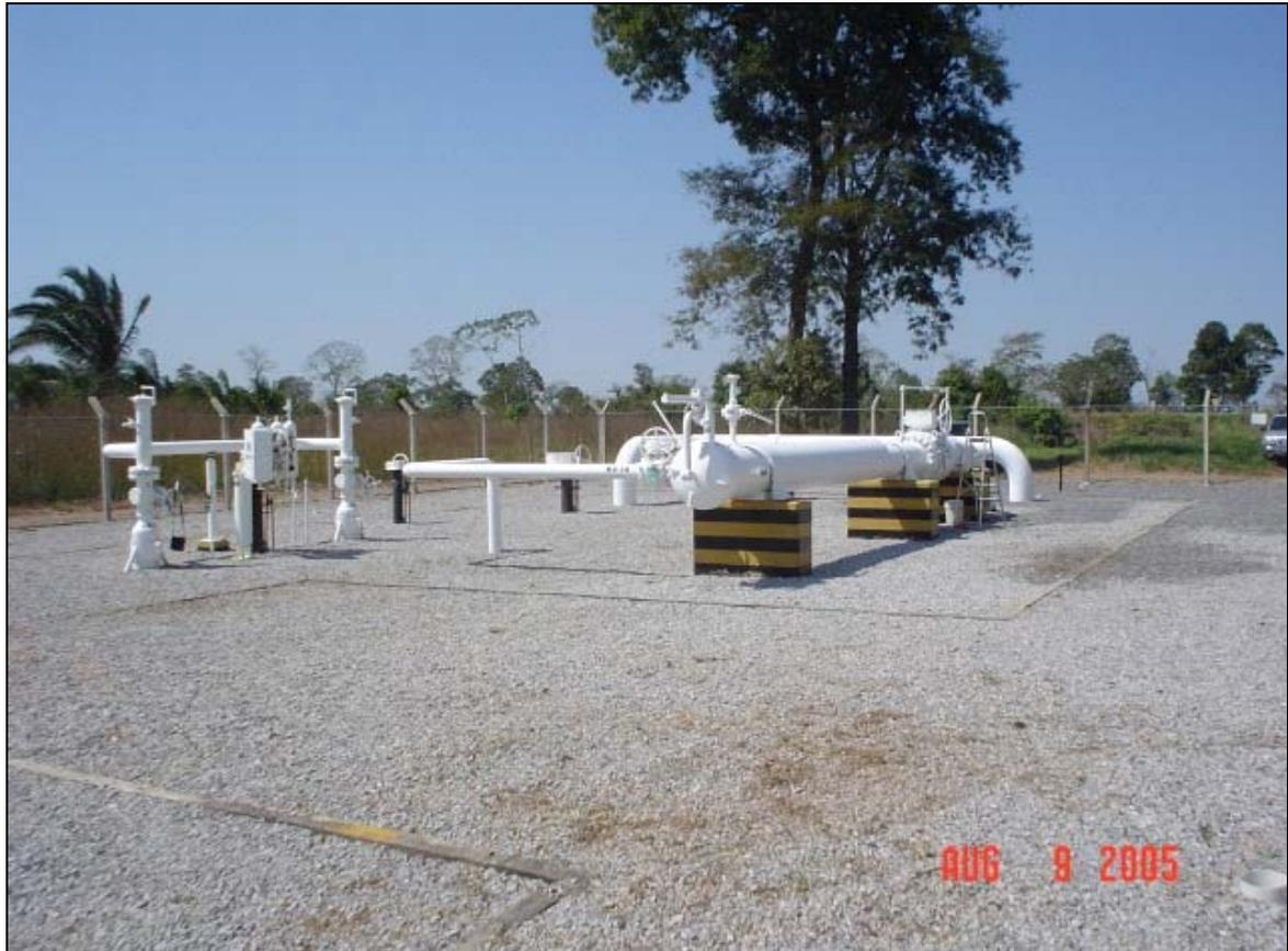
Figura IX-2 - Configuração típica de um Lançador de "Pigs"
