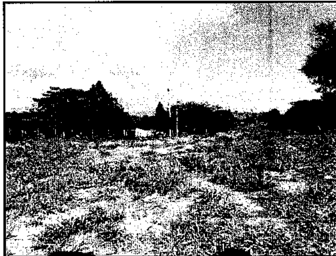
Foto 13. Local onde será instalado o canteiro de obras, km 196+900.
