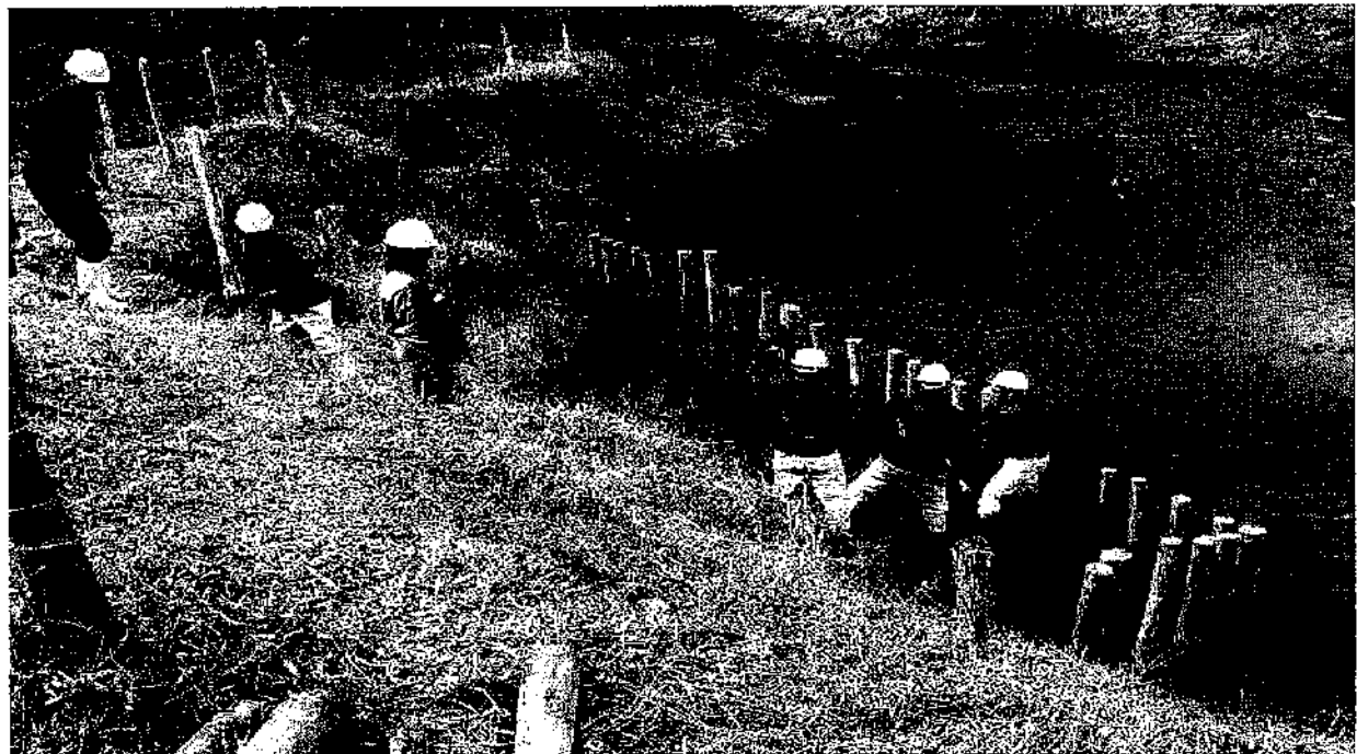
Foto 4: Serviço no Km 115+700 durante a execução – cravação manual de toras de eucalipto para contenção da sacaria de solo cimento.
