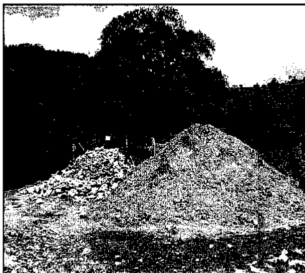
Foto 16 : Material proveniente da escavação, armazenado dentro dos limites da faixa de dutos.
