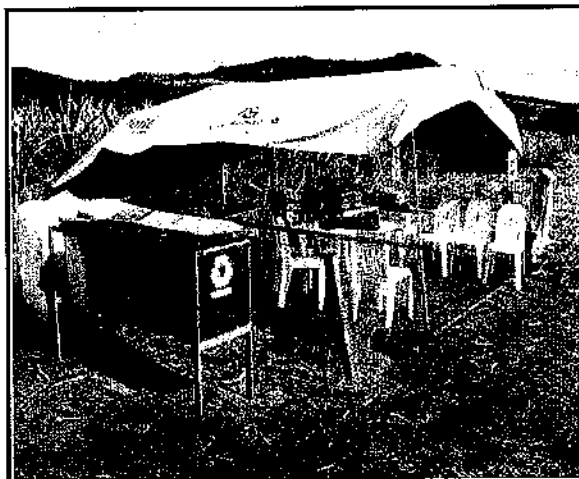
Foto 15. Área de vivência com coletores de resíduos.
