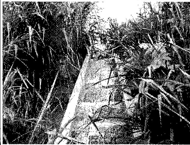
Foto 13: PE Bragança Paulista; sistema de escoamento pluvial em degraus.
