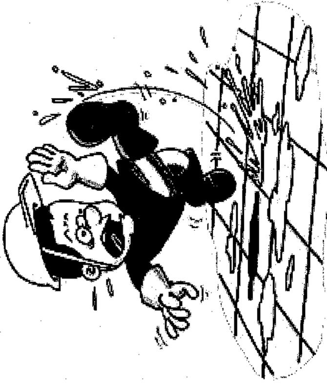
Ao escavar em áreas residenciais ou próximo a estradas de rodagem, certifique-se da existência de redes de água e esgoto.
