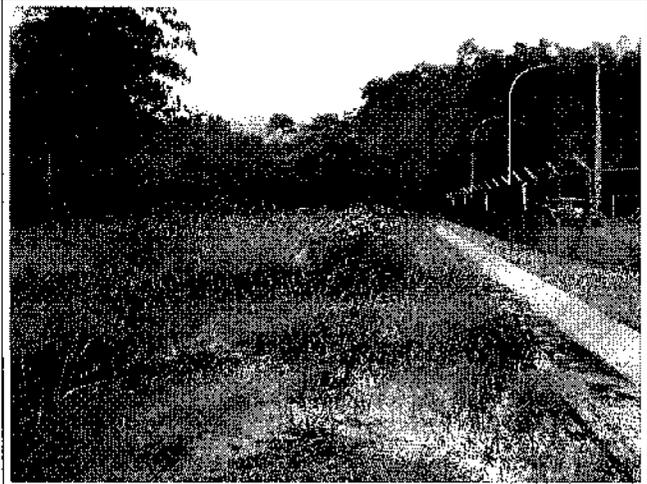
Foto 14: PE Bragança Paulista; canaleta de águas pluviais ao redor da unidade.
