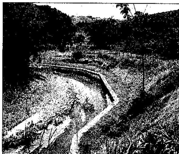
Figura 4. Vista Geral do muro gabião na lateral da faixa após a conclusão da obra.
