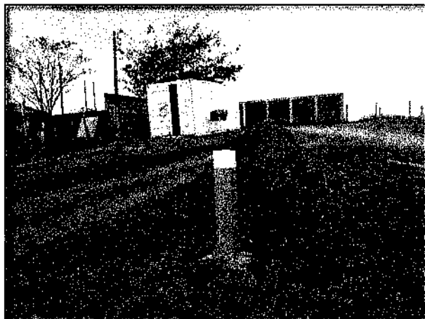
Foto 5: Container instalado dentro dos limites da faixa de dutos.
