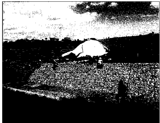
Figura 23. Montagem gabião.
