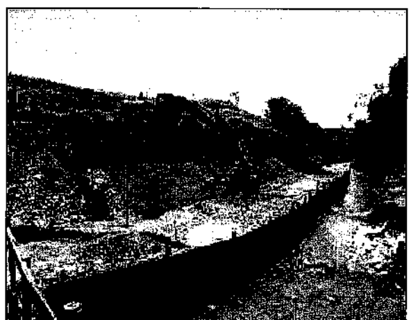
Figura 22. Cercas para evitar carreamento do solo para o Recurso
