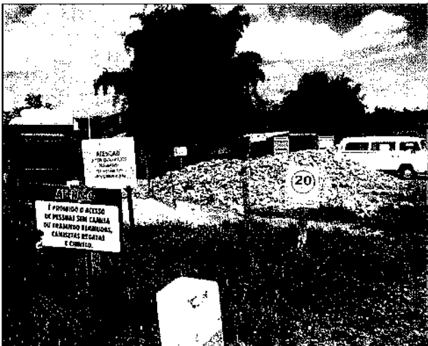
Figura 9. Armazenamento de materiais.
