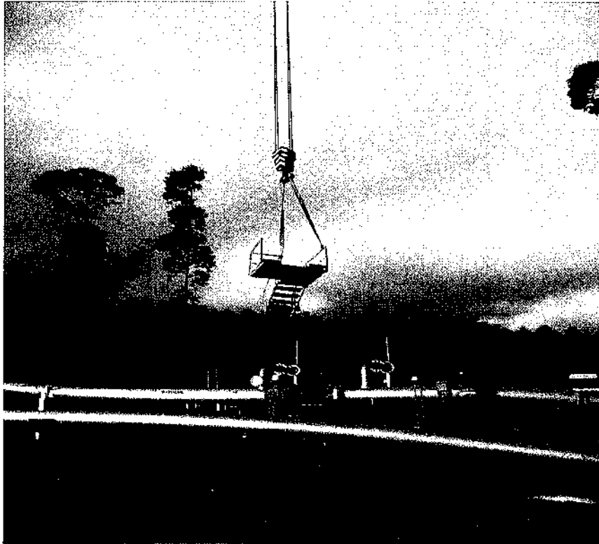
Figura 21. Retirada do acesso à plataforma.
