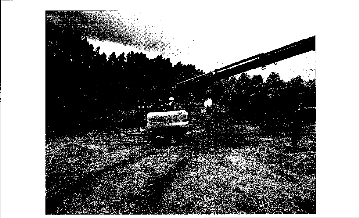
Figura 7. Início dos serviços, disposição dos equipamentos de apoio.
