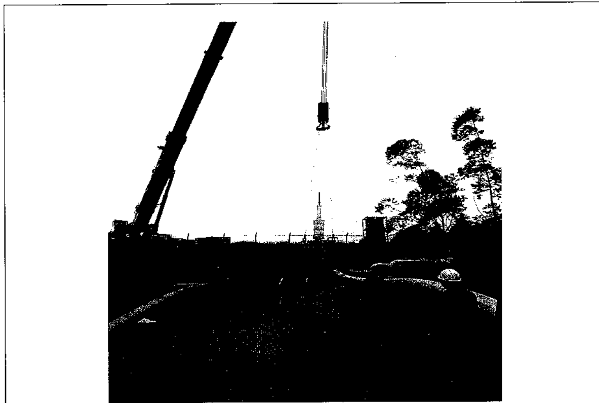
Figura 16. Movimentação da retirada da válvula SDV-16.
