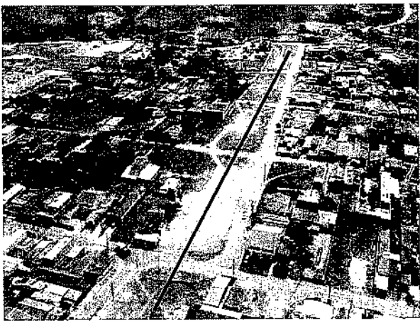
Foto 4: Km 29 – Jardim Costão, Guararema – faixa não edificante não respeitada.
