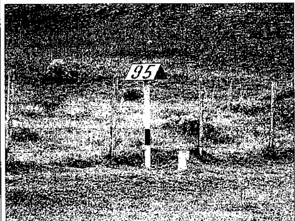
Foto 37: Km 95 – Marco de sinalização da quilometragem do duto.
