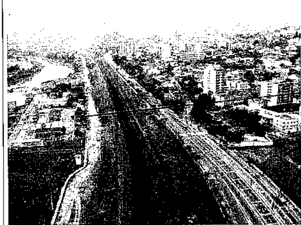
Foto 40: Derivação de Volta Redonda – travessia de rodovia e ferrovia – faixa não edificante não respeitada.
