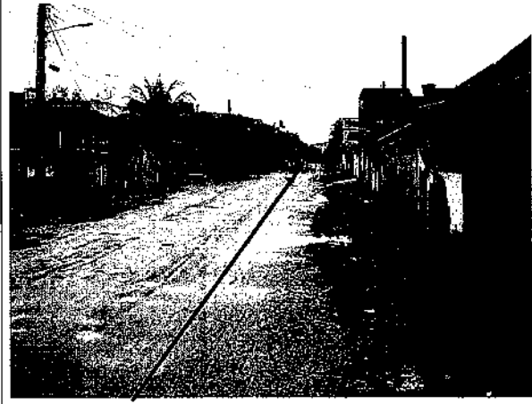
Foto 52: Km 43 a 42 – Bairro Chacrinha, Japeri - área não edificante não respeitada e faixa transformada em rua.
