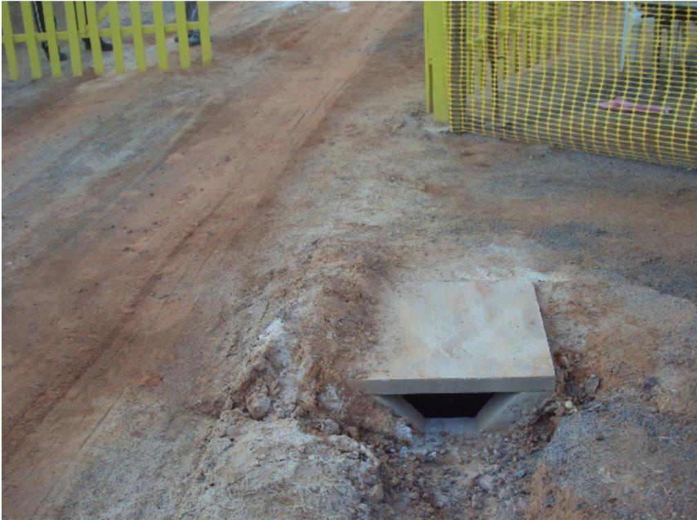
**Figura 29- Caixa de drenagem na entrada do PE.**
