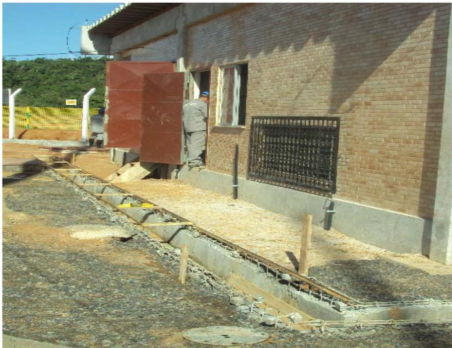
**Figura 14- Construção das canaletas ao lado do abrigo.**
