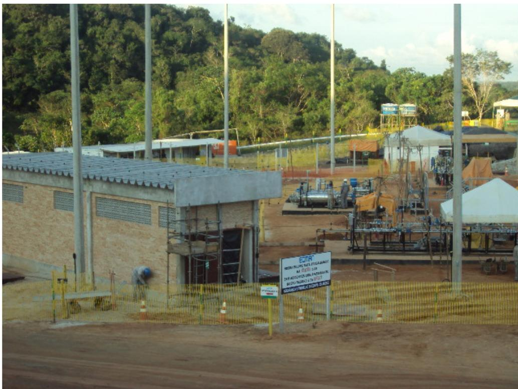
**Figura 12- Abrigo dos equipamentos em fase de acabamento e a instalação dos postes de iluminação externa – Maio/Junho 2010.**
