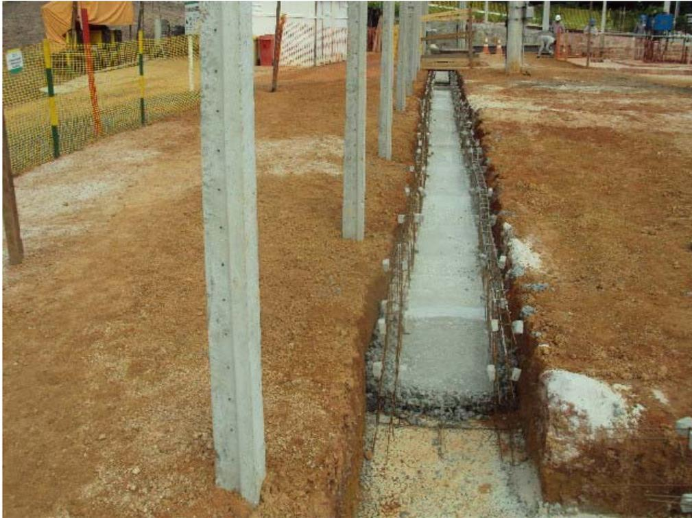
**Figura 16- Fundo de calha de drenagem concretado.**
