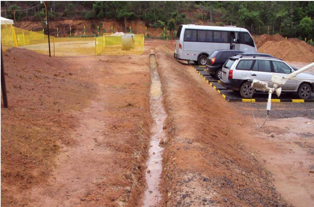
**Figura 30- Canaleta de Drenagem do PE.**
