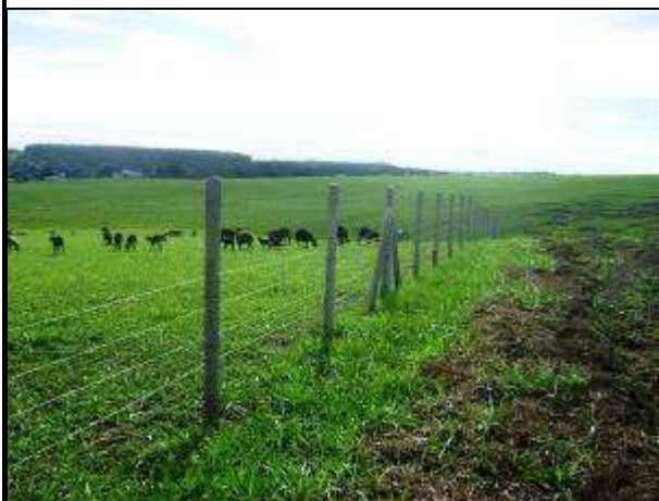
Figura 01: Imagens da cerca tipo 1 que delimita a área da ECOMP, reforçada com mais 4 fiadas de arame.
