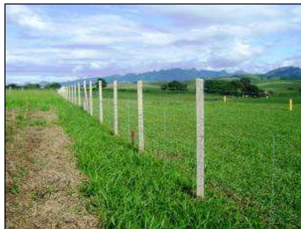
Figura 02: Imagens da cerca tipo 1 que delimita a área da ECOMP, reforçada com mais 4 fiadas de arame.
