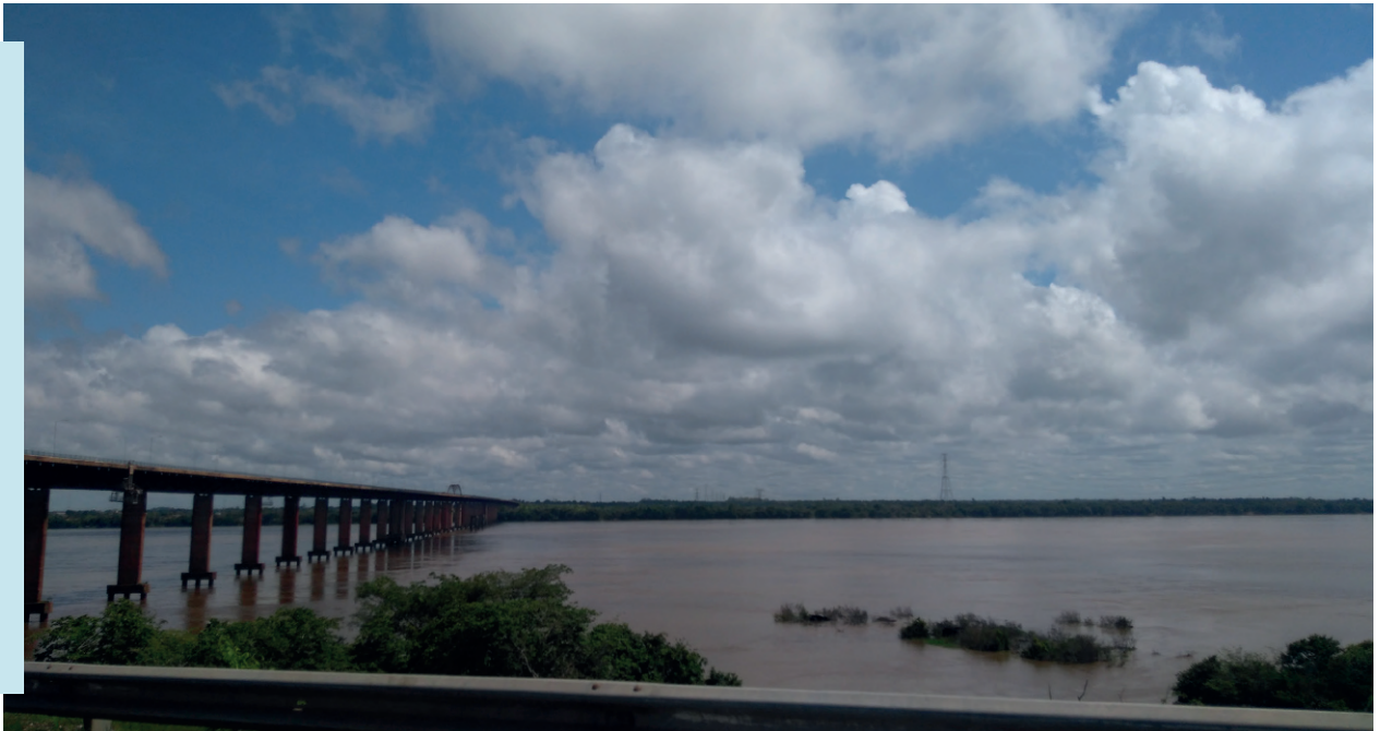
Estrada de Ferro Carajás - Ponte sobre o rio Tocantins - Marabá
