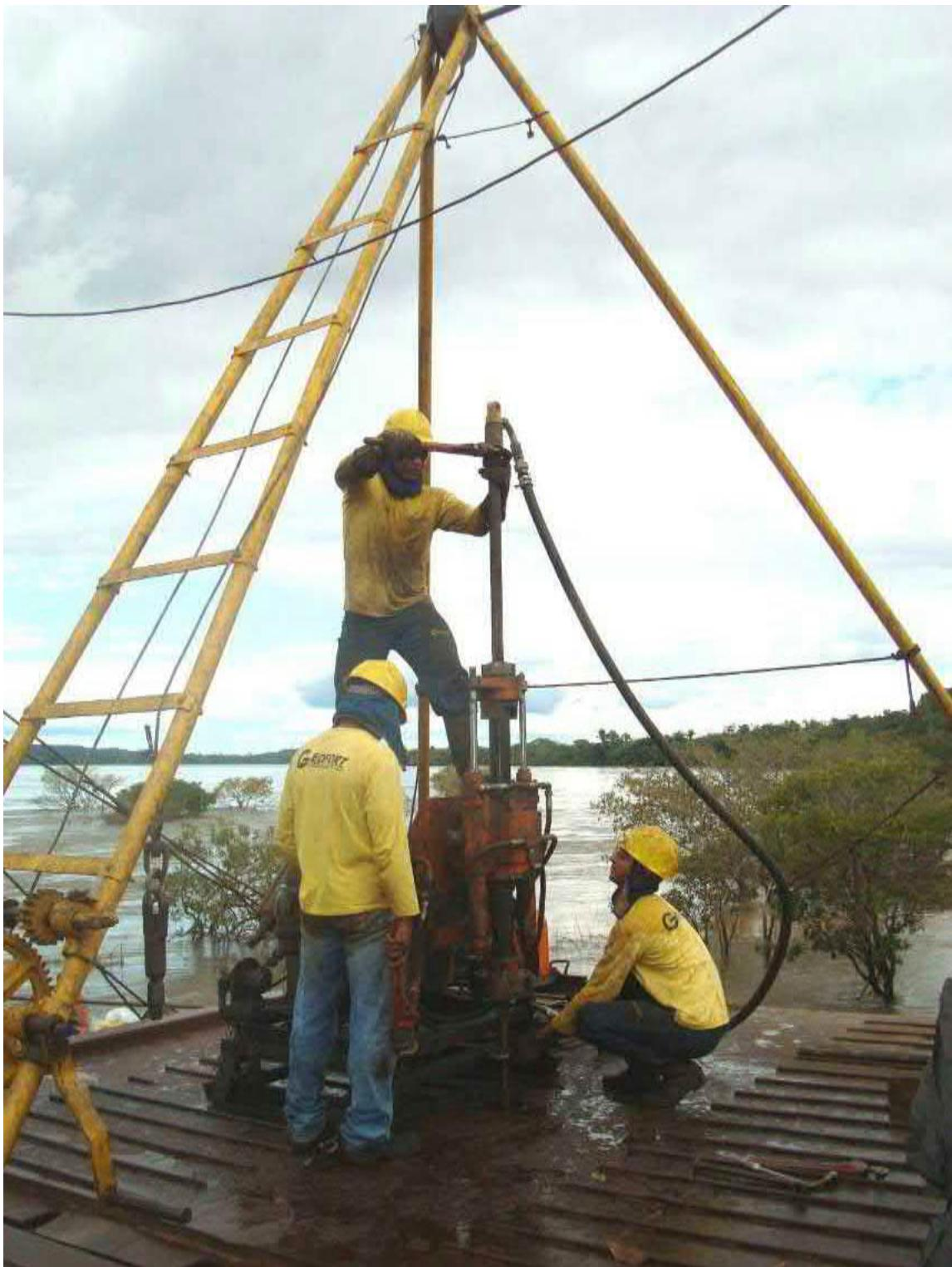
Foto 06: Execução da sondagem rotativa
