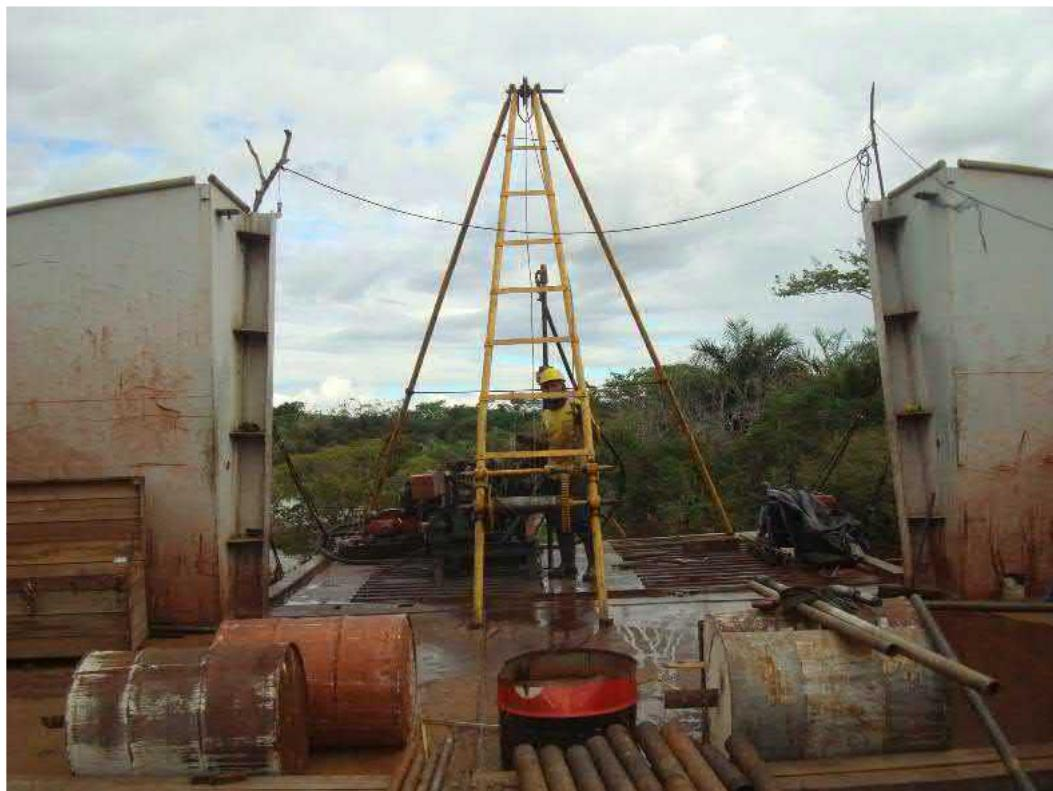
Foto 04: Execução da sondagem rotativa
