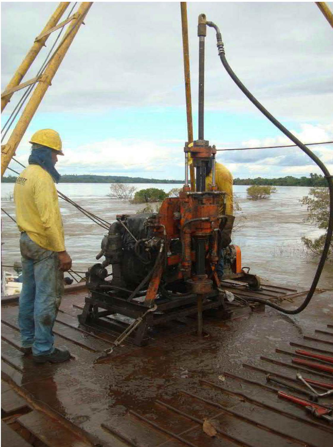
Foto 07: Execução da sondagem rotativa
