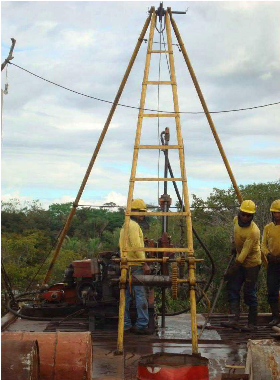
Foto 05: Execução da sondagem rotativa
