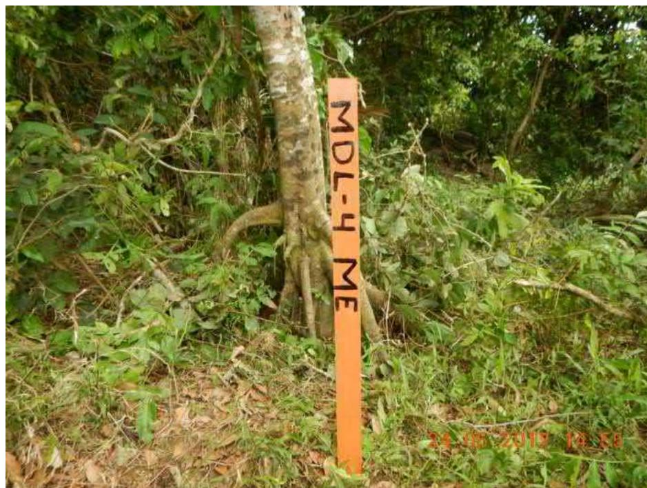
**Figura 2-10: Materialização de estacas PI e PF para alinhamento da seção MDL-4.**
