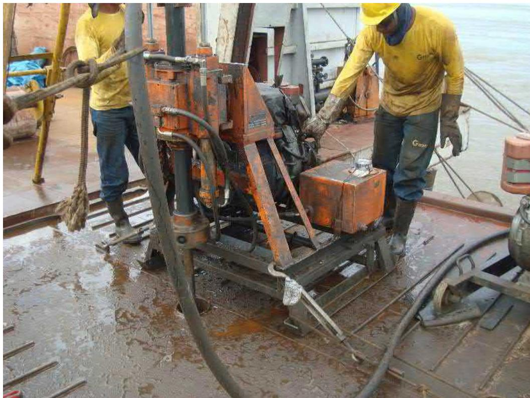
Foto 08: Execução da sondagem rotativa
