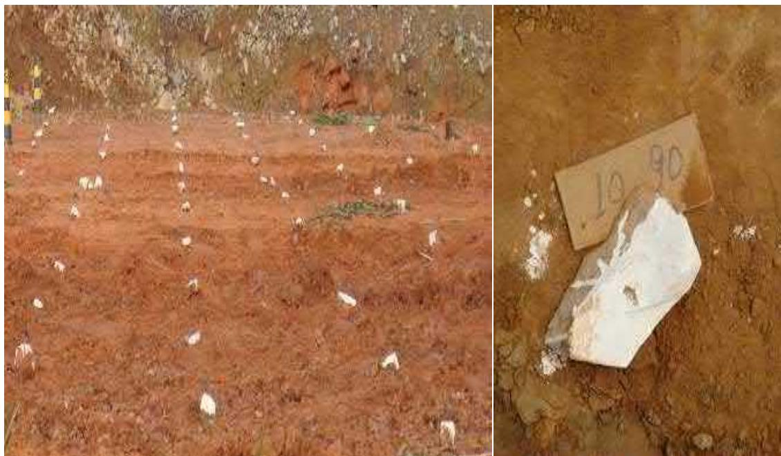
Figura 8 – À esquerda, malha de perfuração demarcada; à direita, detalhe de marcação apontando a profundidade a ser perfurada (foto ilustrativa).
