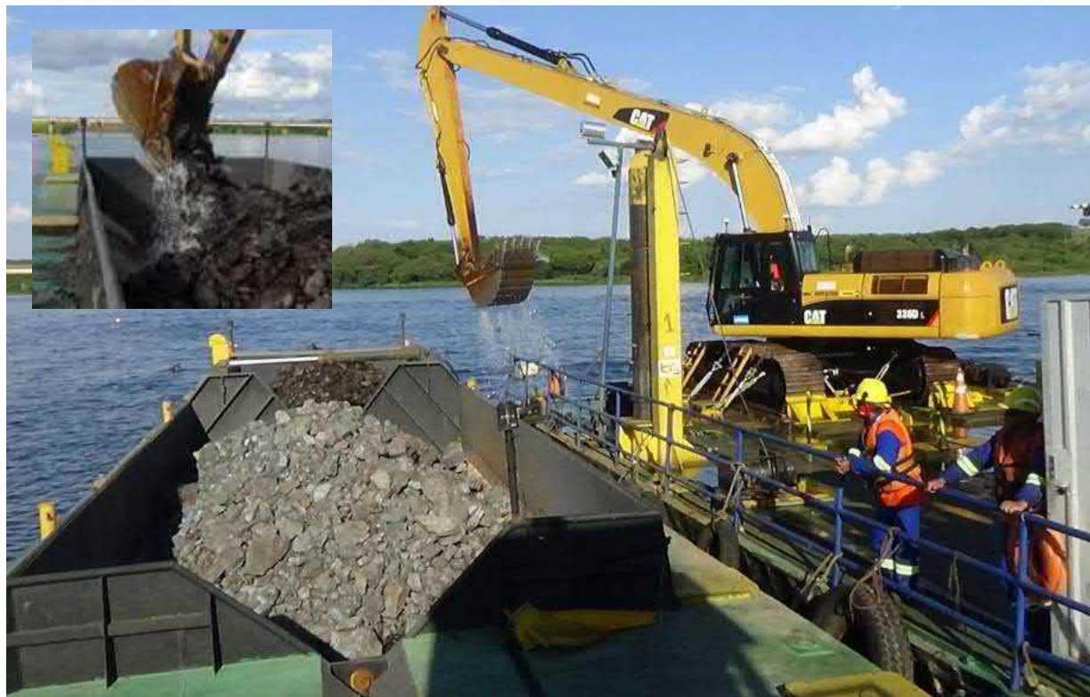
Figura 16 - Operação de carga do batelão (Foto ilustrativa).
