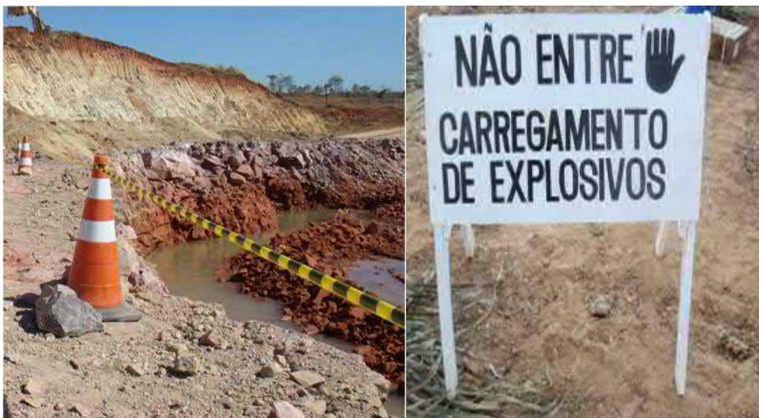
Figura 10 – Procedimentos de isolamento da área (foto ilustrativa).
