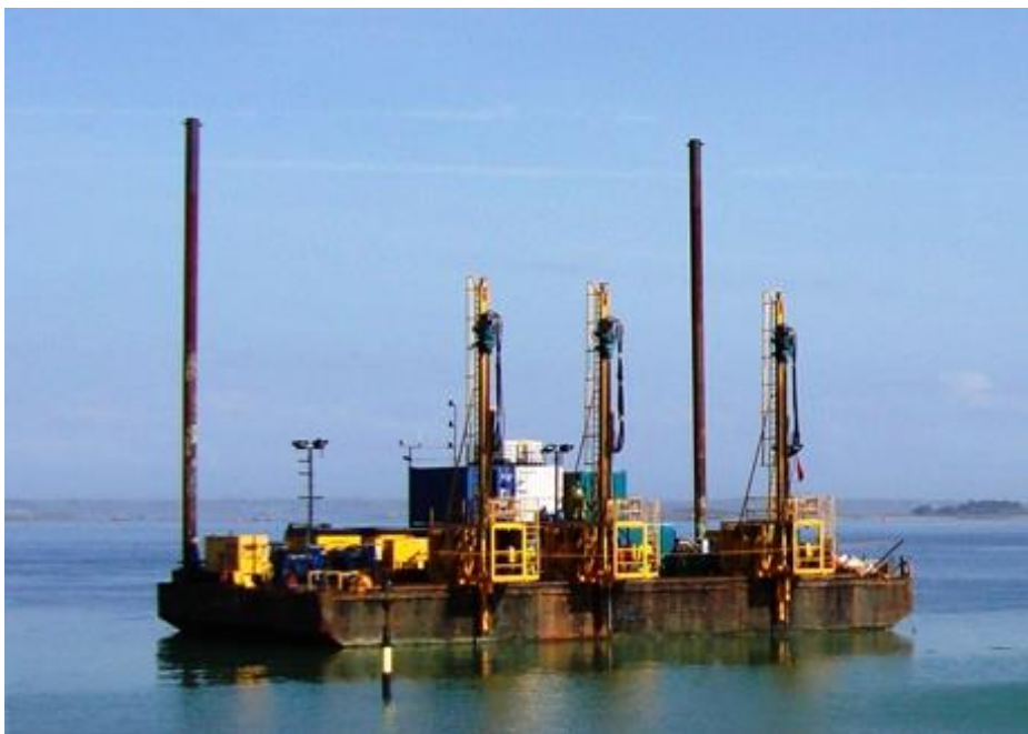
Figura 2.4.2-43 - Flutuante com 03 torres perfuratrizes acopladas.
