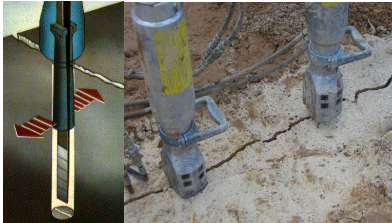
Figura 3.2.2-2 - Dardas e seu efeito expansivo na fragmentação de rocha
