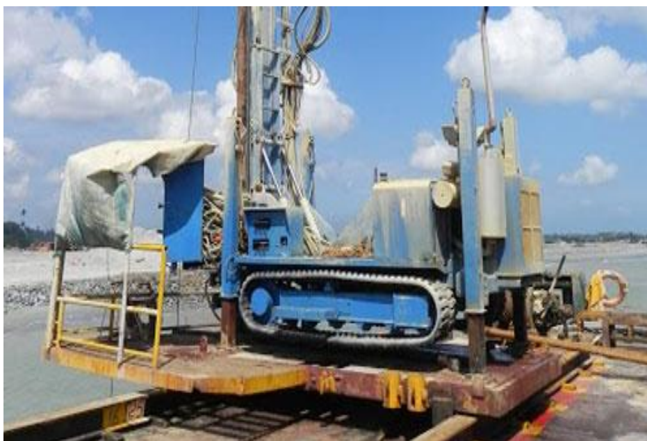
Figura 2.4.2-44 - Perfuratriz convencional acoplada em flutuante.
