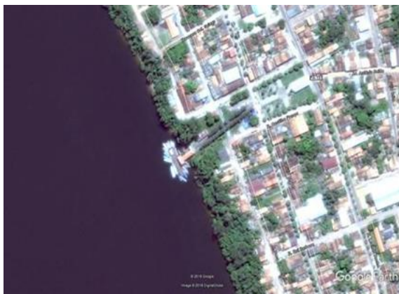
Foto 2.4.1-5 - Localização do Cais de Baião.
