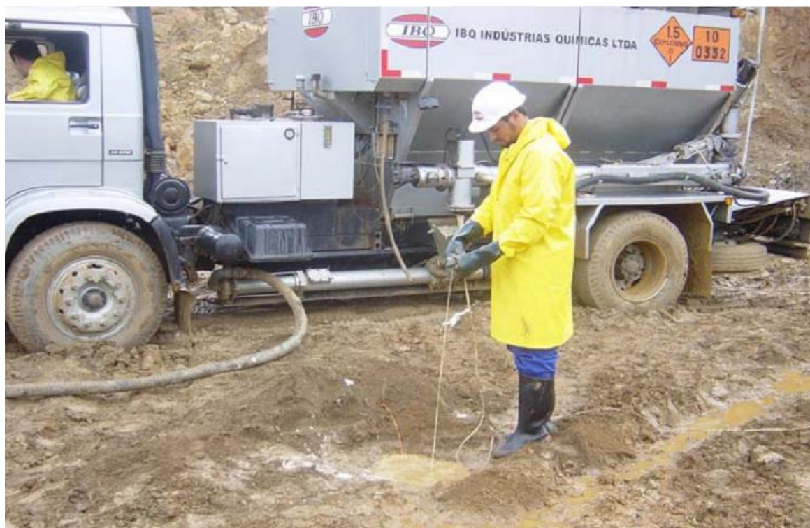
Figura 3.2.2-11 - Equipamento de emulsão bombeada sobre caminhão.
