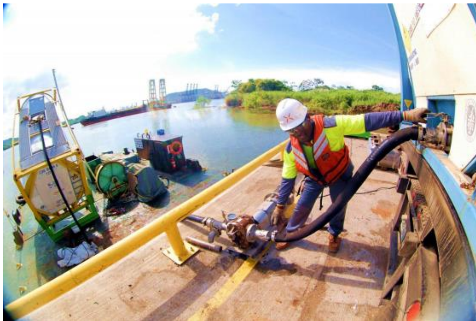
Figura 2.4.2-49 - Abastecimento do isotanque em flutuante que alimentará os cassetes nos flutuantes das perfuratrizes.
