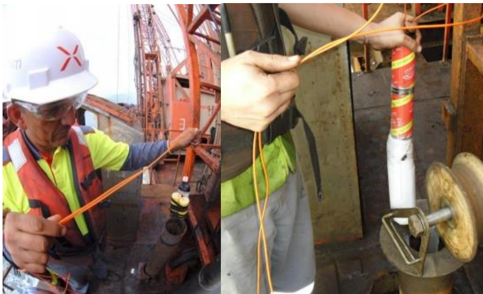
Figura 2.4.2-51 - Escorva TTOC / Booster – Preparação para carregamento dos furos com emulsão.
