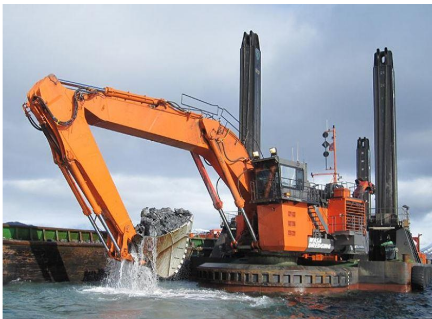
Figura 3.2.2-6 - Escavadeira hidráulica de grande porte sobre flutuante.
