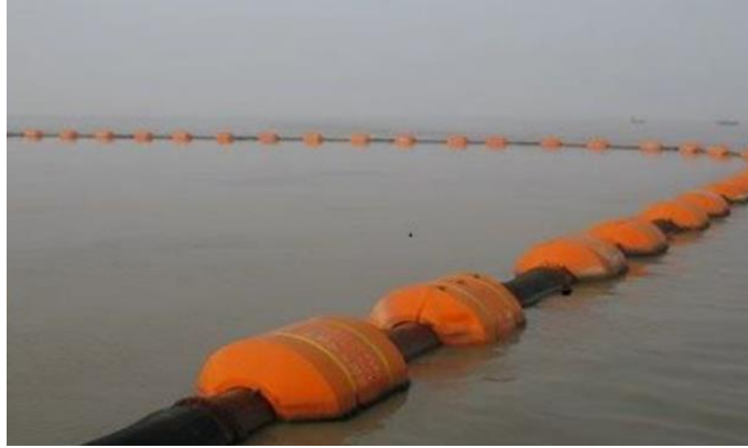
Figura 2.4.1-10 - Figura ilustrativa de Tubulação PEAD com flutuante.
