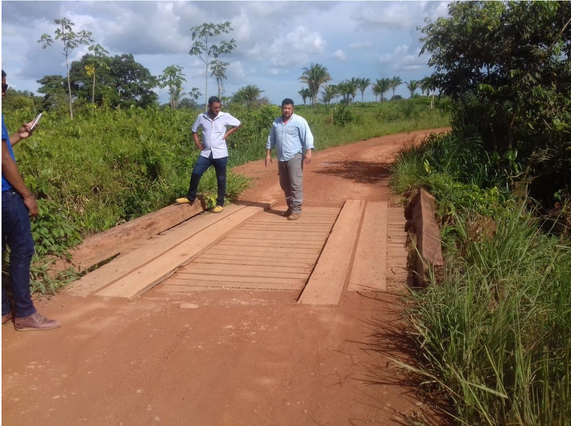
Figura 2.4.2-69 - Acesso à ponte da Cigana.
