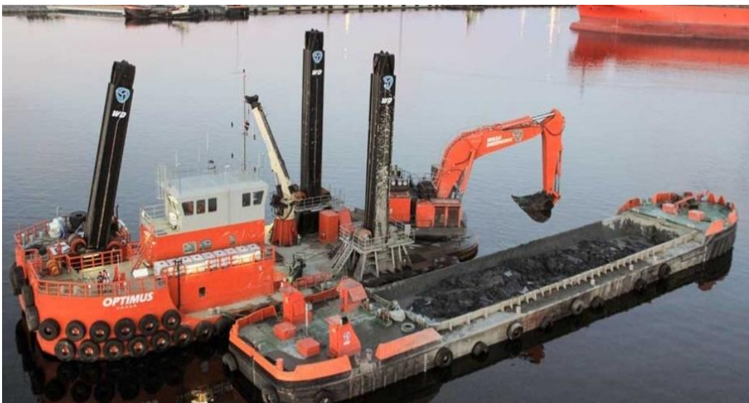
Figura 2.4.2-64 - Carregamento e transporte do material derrocado. Conjunto escavadeira / batelão.
