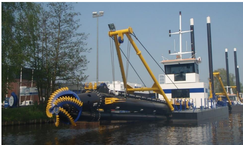
Figura 3.2.2-4 - Equipamento de ação mecânica de desagregação de rocha.
