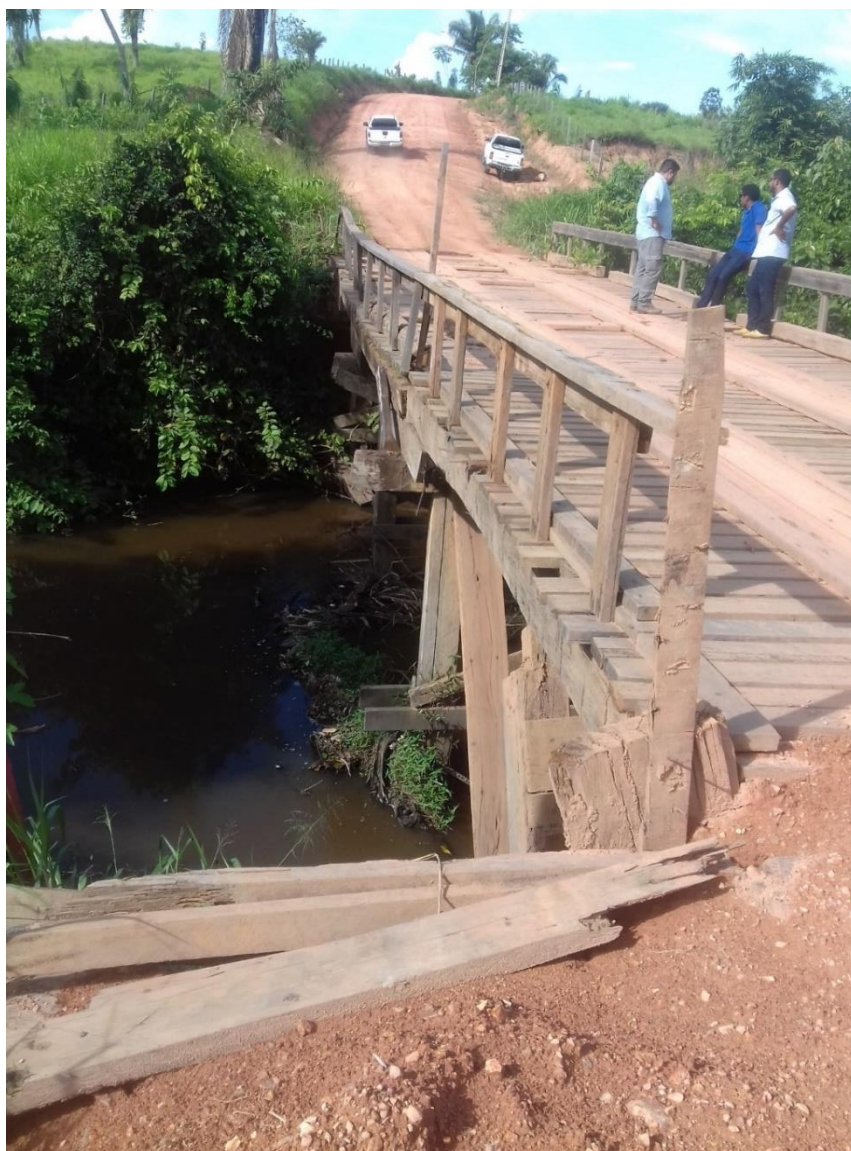
Figura 2.4.2-70 - Manutenção recente da ponte Rainha.
