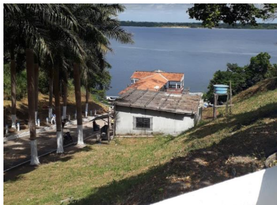
Foto 2.4.1-6 - Cais de Baião.
