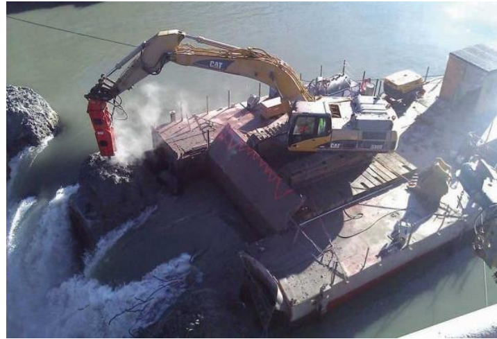
Figura 3.2.2-5 - Escavadeira com rompedor hidráulico trabalhando em flutuante.
