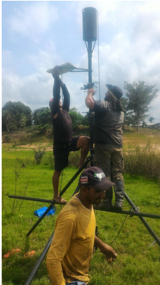
Figura 7: Fixação do Painel Solar na face externa do tubo.
