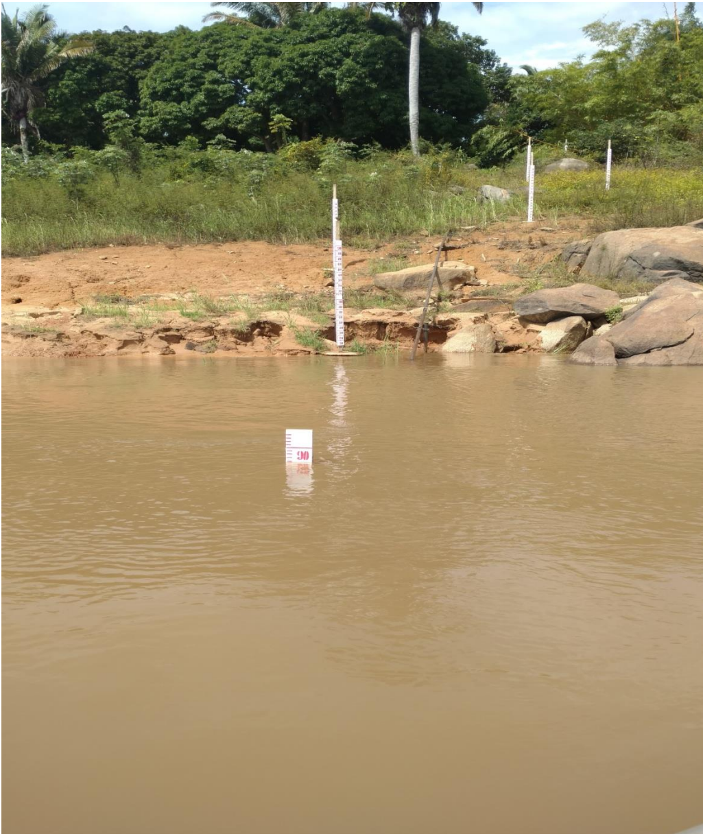
Figura 26: Linímetros instalados no RN13.
