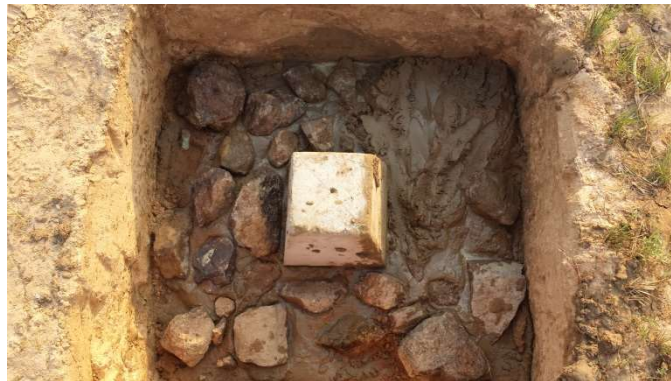
Figura 7: marco posicionado sobre a broca já concretada, recebida a primeira camada de cimento sobre os matacões.
