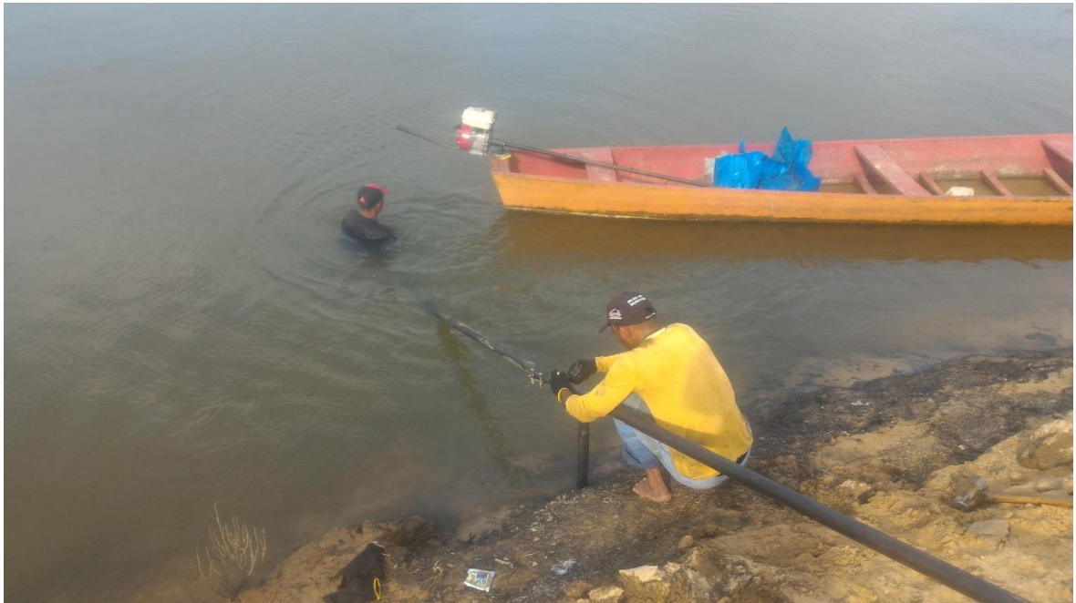
Figura 4: Submersão do tubo com sensor hidrostático.
