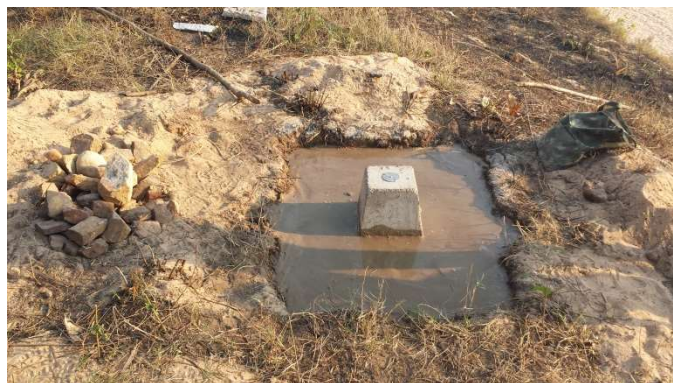
Figura 8: marco no bloco totalmente preenchido.
