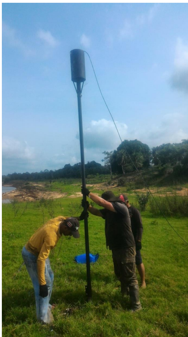
Figura 6: Tubo zincado posicionado na vertical.
