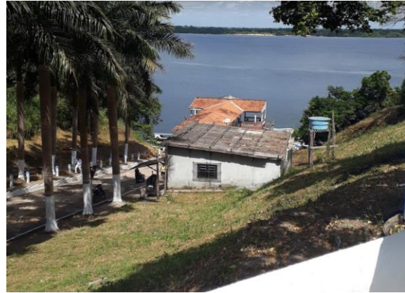
Foto 7.1.5-6 - Cais de Baião.
