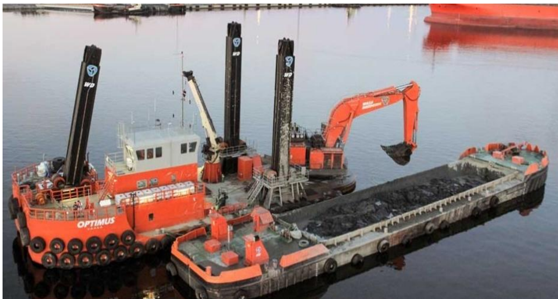
Figura 7.1.2-8 - Carregamento e transporte do material derrocado. Conjunto escavadeira / batelão.
