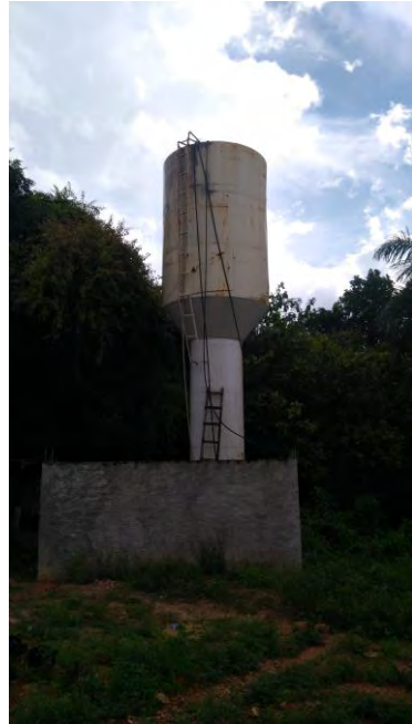
Reservatório de água Ponto 10
