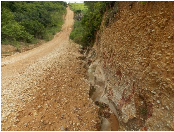
Foto 5.1.4-31 - Erosão em sulcos em drenagem da estrada ocasional de média intensidade (0685856x9549856).
