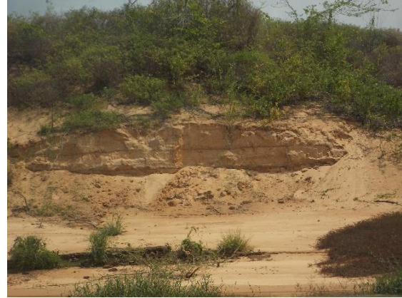
Foto 5.1.4-96 - Processo de desmoronamento localizados e de baixa intensidade nas margens de barras arenosas (0655889 x 9611050).
