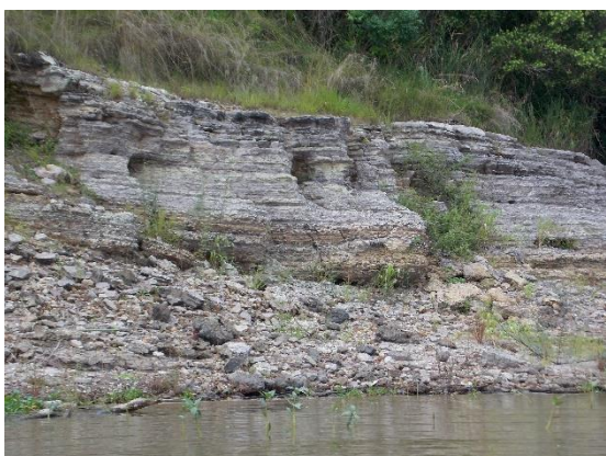
Foto 5.1.4-51 - Margem erosiva sustentada por arenitos arcoseanos estratificados, grossos a conglomeráticos e níveis de pelitos do Grupo Itapecuru, que quando alterados e erodidos evidenciam o leito maior do rio (0703398 x9407879).
