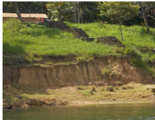
Foto 5.1.4-90 - Processos de erosão laminar e em sulcos ocasionais e de baixa intensidade podendo ocorrer pequenos desmoronamentos de baixa intensidade (0648095x9590983).
