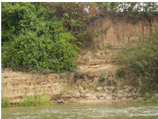
Foto 5.1.4-63 Processos de solapamento e pequenos escorregamentos que ocorrem na Planície de inundação da margem direita do rio (0687181 x 9431038).
