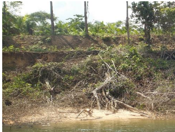
Foto 5.1.4-94 - Desmoronamentos de margem de Planície de inundação, expondo o dique marginal elevado sobre a planície que foi limpo para plantio de roça. (0648405x9596535).
