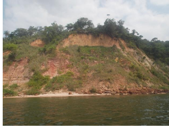
Foto 5.1.4-98 - Processos de escorregamentos frequentes associados ao solapamento do sopé da escarpa pelas correntes e pelo embate de ondas durante as cheias que ocorrem entre Baião e São Joaquim do Itaquara (0650460x9663436).
