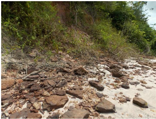
Foto 5.1.4-109 - Blocos de arenitos e conglomerados da Formação Ipixuna laterizados e tombados do alto da escarpa (0647336x9687579).
