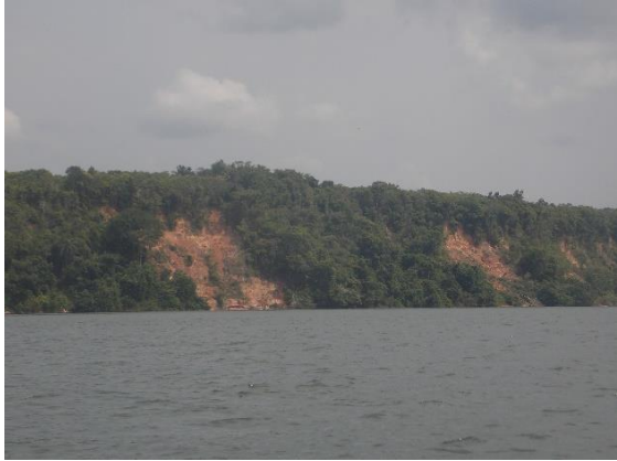
Foto 5.1.4-97 - Encostas escarpadas e íngremes com inclinações acentuadas (15 a 45%) na margem direita do Rio Tocantins, que apresentam processos de escorregamentos frequentes associados ao solapamento do sopé da escarpa pelas correntes e pelo embate de ondas durante as cheias que ocorrem entre Baião e São Joaquim do Itaquara (0650460x9663436).
