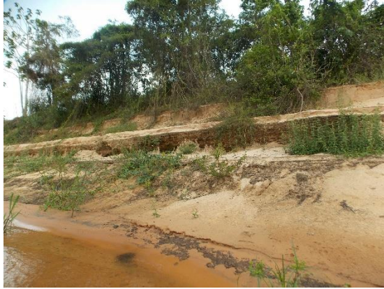
Foto 5.1.4-55 - Planície de inundação da margem esquerda, com altura de 4 a 6 m, constituída por areia fina intercalada com camadas de argila cinza com matéria orgânica (0694642 x 9416304).
