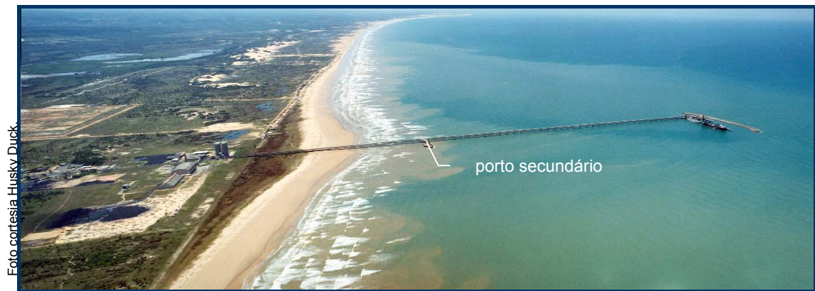
FIGURA 6.1.5-7: FOTOGRAFIAS AÉREAS DO TERMINAL E LINHA DE COSTA
