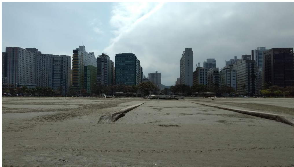
Figura 2-84. Canal 1 entre os perfis STOS05 e STOS06 completamente assoreado.
