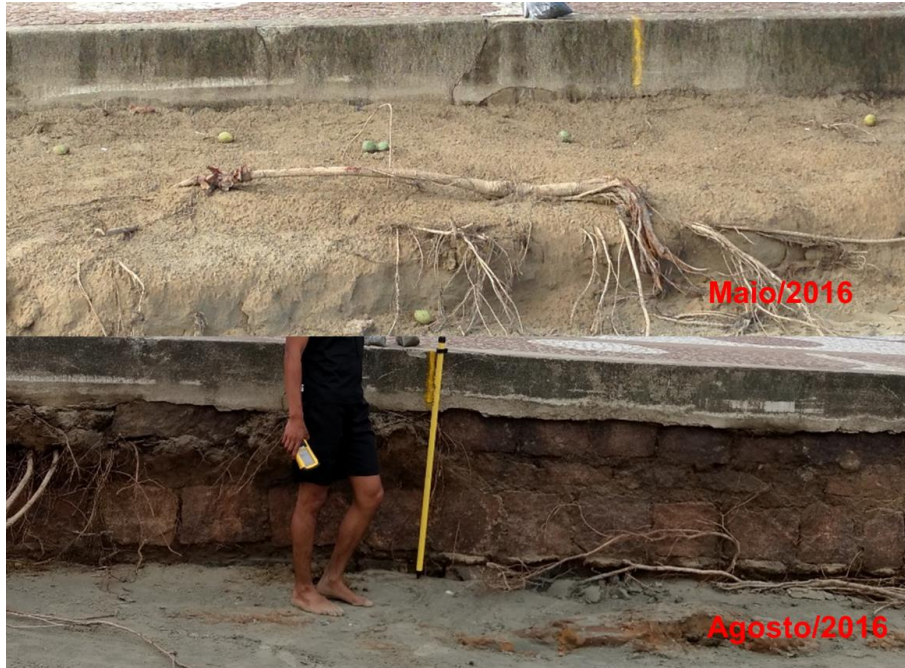
Figura 2-80. Forte processo erosivo junto ao perfil STOS22. Na foto estão apresentadas as condições em Maio de 2016 e Agosto de 2016.
