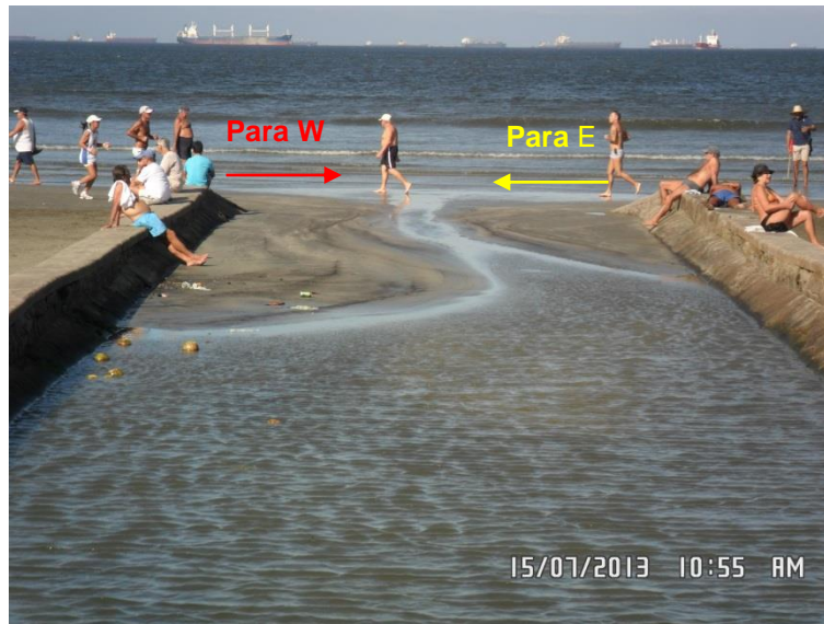
Figura 8.3.2.4-2. Migração lateral da barra de desembocadura do Canal 3, entre os perfis Stos-11 e Stos-12. Notam-se dois sentidos opostos de transporte: um anterior e para E (ocorreu durante a ressaca do dia anterior) e o atual para W (no dia do monitoramento).
