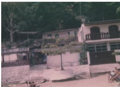
jul/1992 (Góes-05: início da erosão)
