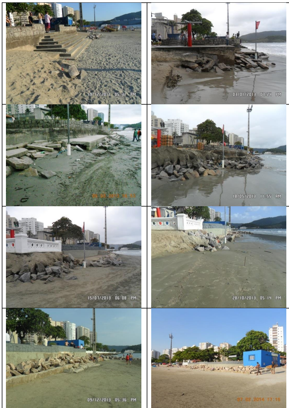
Figura 8.3.2.5-1. Erosão acelerada nas estruturas urbanas em frente ao Aquário Municipal (garagem náutica, área de lazer e chuveirinho), no período de dezembro de 2011 a fevereiro de 2014. Essas estruturas foram originalmente construídas sobre a praia no trecho entre os perfis Stos-22 e Stos-23. Notar: em dezembro de 2011 - embora já houvesse erosão, era constante o aterramento artificial, com areia de praia, na base das estruturas; no início de 2013 (janeiro e março) - observa-se forte erosão das estruturas urbanas após a atuação de ressacas sucessivas; em maio de 2013 - obras de recuperação das estruturas (e construção da balaustrada), implantação de um anteparo de pedras na base das mesmas e novo aterramento com areia, que são novamente atacados por ressacas; no decorrer de 2013 até fevereiro de 2014 - remoção da escadaria, reconstrução do muro de arrimo e do anteparo de pedras e algum aterramento apenas no trecho de Stos-22.
