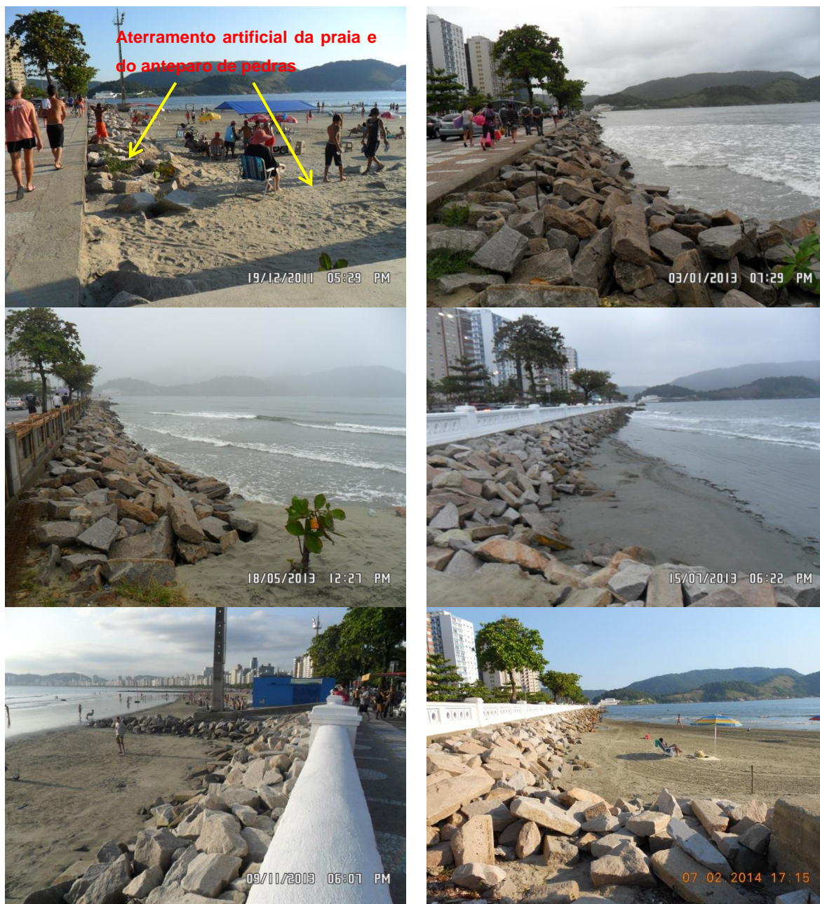
Figura 8.3.2.5-2. Erosão acelerada no perfil Stos-23, entre dezembro de 2011 e fevereiro de 2014. Notar o aterramento artificial do anteparo de pedras, com areia praiar em dezembro de 2011, e a aparente não manutenção dessa atividade em 2013/2014.
