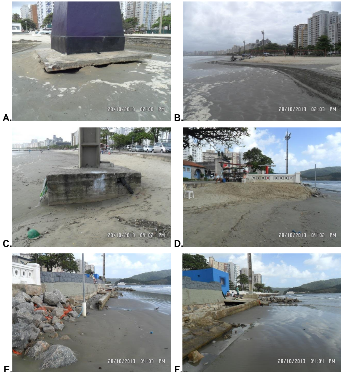
Figura 8.3.2-16. Imagens dos locais dos perfis Stos-20 (Canal 6) e Stos-23 obtidos durante a 32ª campanha (outubro de 2013). (A): descalçamento na base do farol do Canal 6 (notar as marcas do trator de limpeza pública ao redor do farol e um dos montículos de areia juntada para posterior remoção). (B): quadras de vôlei com evidências de colocação/remobilização de areia. (C) e (D): descalçamento do poste de iluminação e rebaixamento da areia próximo ao perfil Stos-22. (E) e (F): Erosão acelerada junto às estruturas urbanas em frente ao Aquário. (G): Erosão acelerada no perfil Stos-23 (notar o espigão de pedras - transversal à linha de costa - que se estende desde a base do último poste de iluminação próximo a Stos-23 e que mantém uma pequena faixa de areia neste perfil, em função da atuação de forte deriva litorânea para W nesse trecho).
