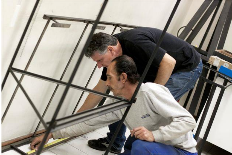
Figura 21.3.1-15. Montagem da estrutura de uma das peças que compõe a exposição. Autor: Beth Romano.
