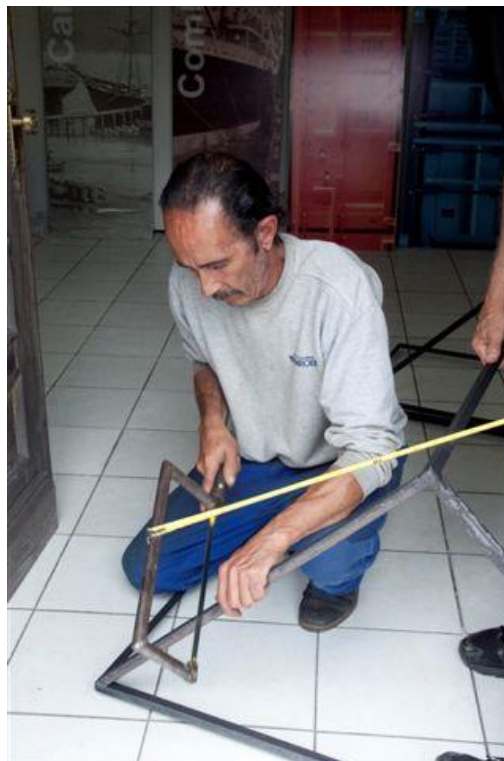
Figura 21.3.1-14. Montagem da estrutura de uma das peças que compõe a exposição. Autor: Beth Romano.
