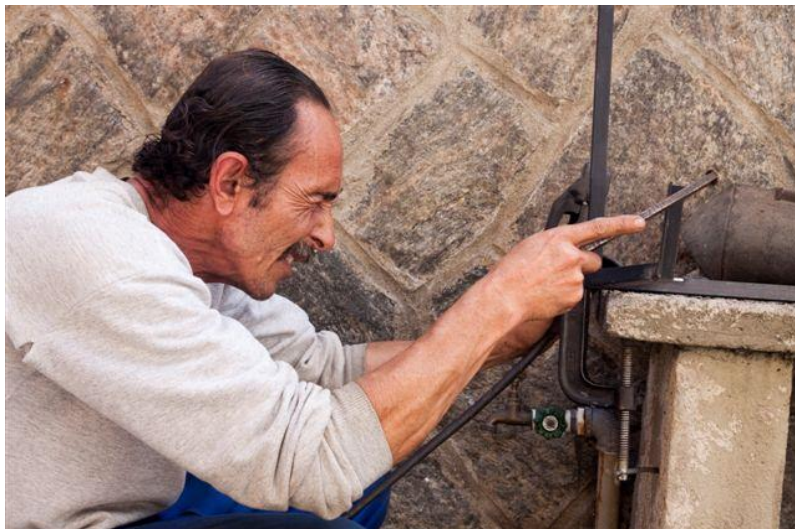
Figura 21.3.1-12. Montagem da estrutura de uma das peças que compõe a exposição. Autor: Beth Romano.
