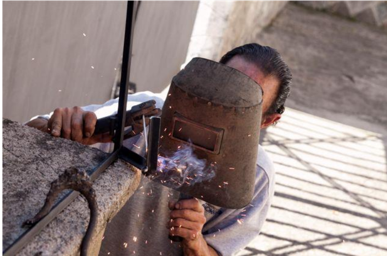
Figura 21.3.1-11. Procedimento de solda durante a montagem das peças que compõe a exposição. Autor: Beth Romano.
