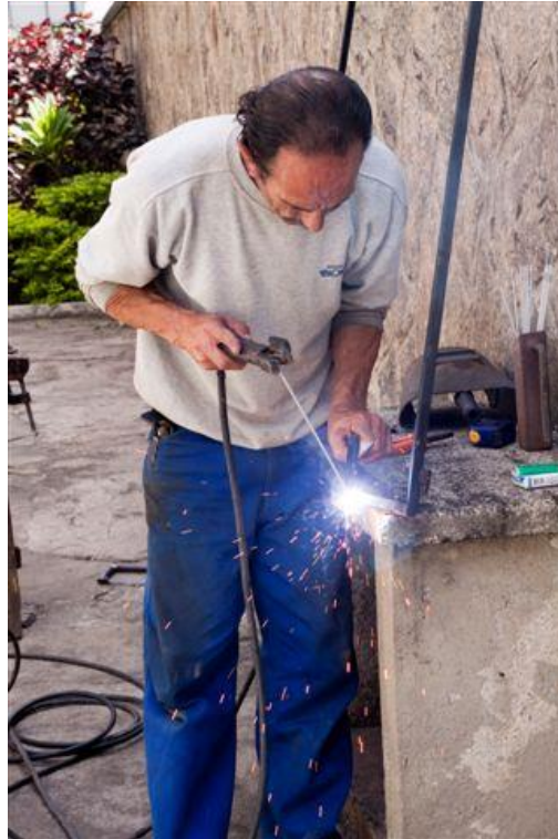
Figura 21.3.1-13. Procedimento de solda durante a montagem das peças que compõe a exposição. Autor: Beth Romano.
