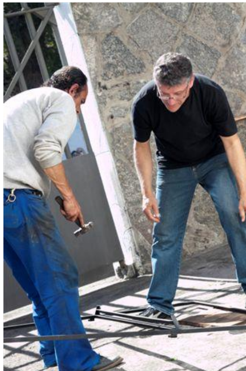
Figura 21.3.1-10. Montagem da estrutura de uma das peças que compõe a exposição. Autor: Beth Romano.
