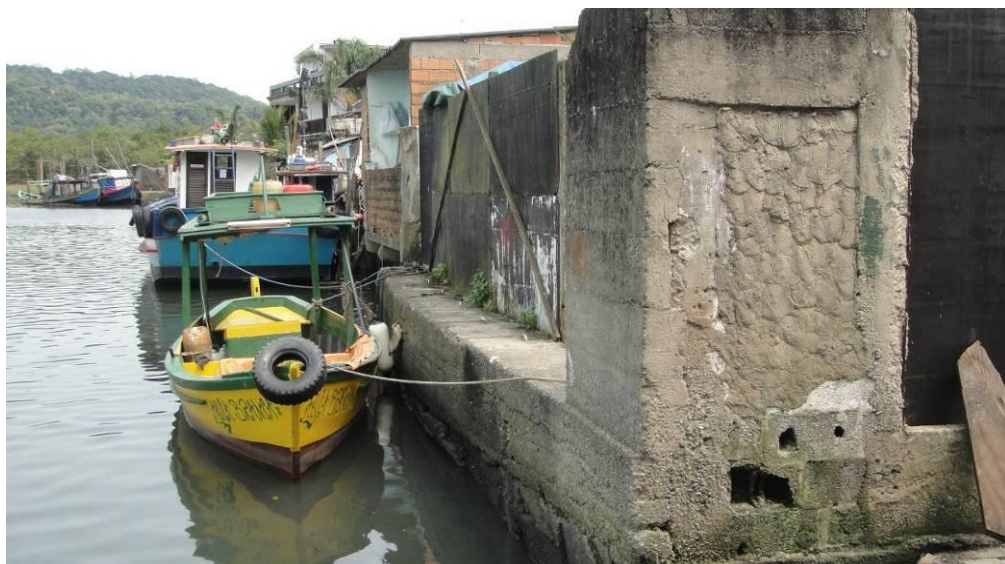
Figura 22.3.2.2.2.1-4. Atracadouro particular da Rua E.
