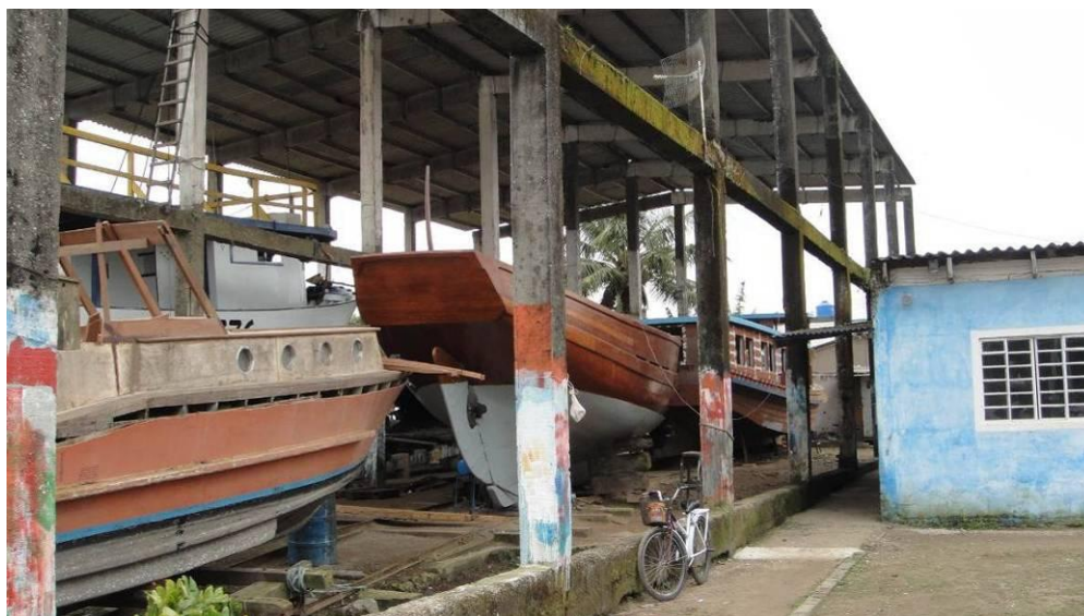
Figura 22.3.2.2.2.1-6. Área interna do Estaleiro Procyon
