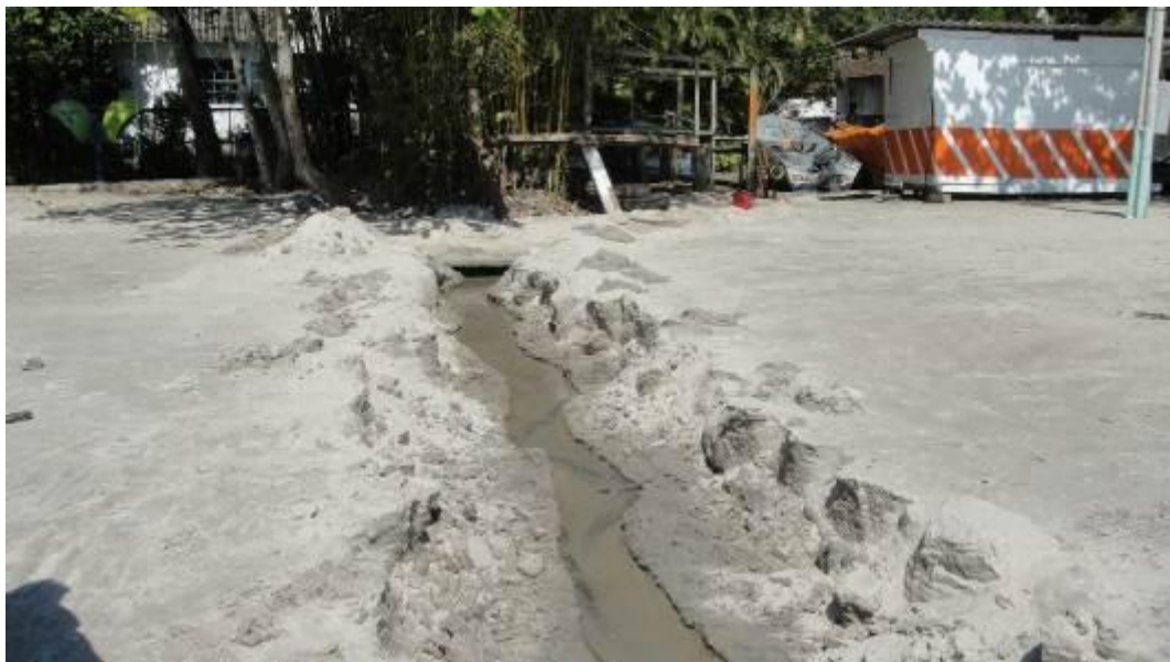
Figura 21.3.2.2-20. Drenagem de águas pluviais que precisou ser desobstruída pelos moradores devido ao assoreamento ocorrido na Praia do Góes. Autor: Fernando R. Nastasi.
