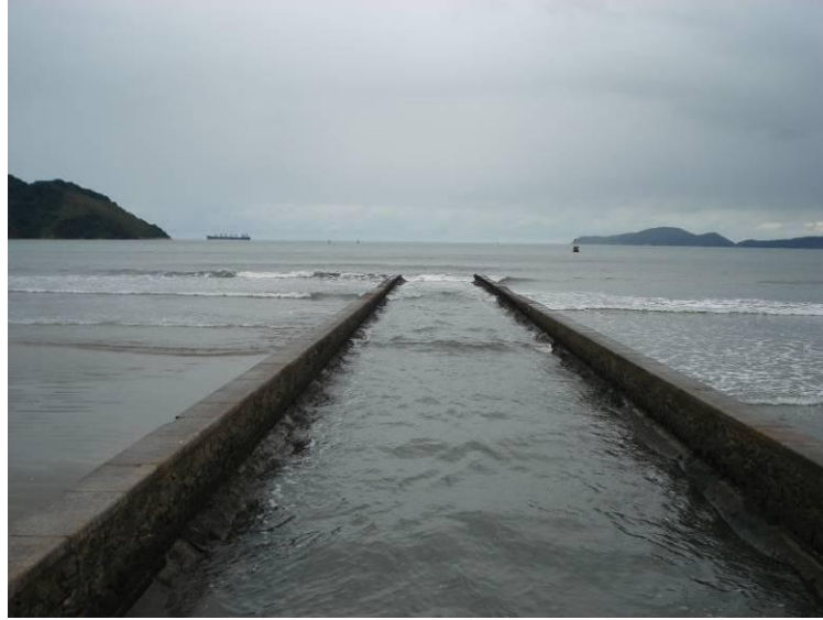
Figura 8.3.2.3-8. Assimetria da largura praias no Canal 6, mostrando maior largura no lado esquerdo (leste) do canal e, portanto, transporte longitudinal para W (em 13 de novembro de 2010).
