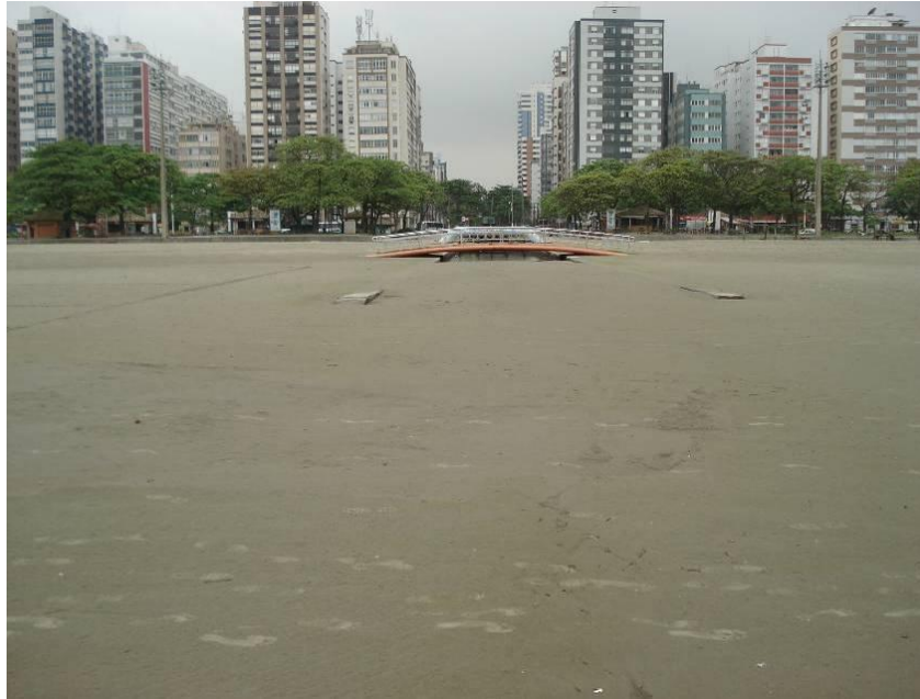
Figura 8.3.2.3-2. Assoreamento completo do Canal 2 (15/10/2010).
