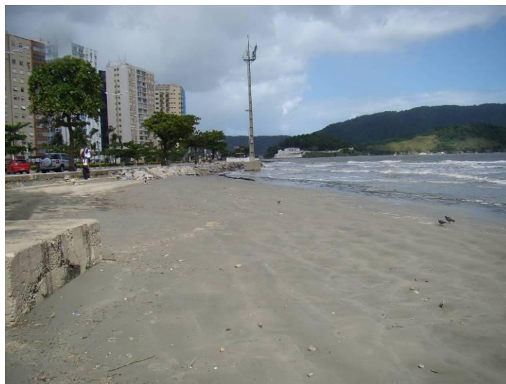
Figura 4.8.3.4-8. Indicadores de erosão I (inexistência de pós-praia), II (retrogradação da linha de costa), VII (exposição de aterros/pedras), VIII (erosão/destruição de estruturas artificiais construídas na praia e redução do estoque de areia), X (concentração de minerais pesados), XI (embaçamento devido à atuação de corrente de retorno). Local do perfil Stos-23 (Ponta da Praia) (data: 08/04/2010).
