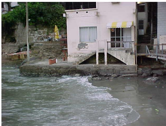
Figura 4.8.3.4-10. Indicadores de erosão I (pós-praia quase inexistente na maré de quadratura e inexistente na maré de sizígia) e II (retrogradação ou recuo da linha de costa e migração vertical do perfil praial) e VIII (destruição de estruturas artificiais construídas na praia). Local do perfil Góes-05 (data: 20/02/2010).
