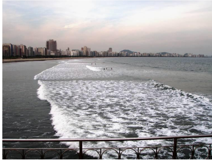
Figura 4.8.3.6-9. Atuação de corrente de retorno na área próxima ao Emissário (05/05/2010).
