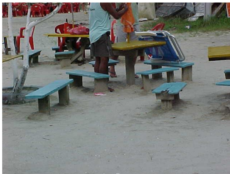
Figura 4.8.3.4-13. Indicador de erosão II (retrogradação ou recuo da linha de costa e migração vertical do perfil praiar). Notar o entulhamento na pós-praia, com soterramento dos bancos e mesas de madeira. Local do perfil Góes-01 (data: 20/02/2010).
