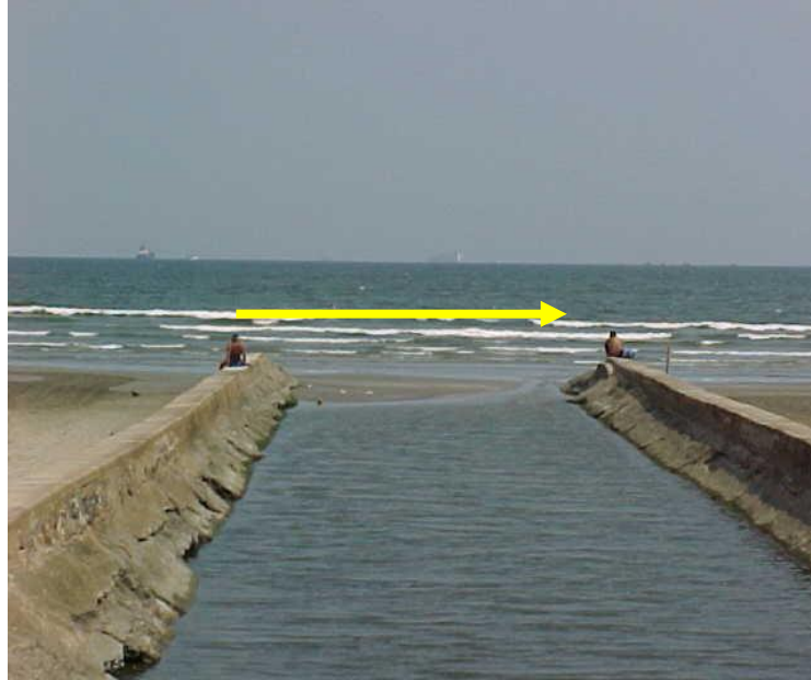
Figura 4.8.3.5-2. Indicador de deriva litorânea forte para W (seta) observado na desembocadura do Canal 2 (data: 22/02-2010): dado pelo sentido de crescimento da barra de desembocadura do canal e também pela assimetria praial, sendo a praia mais larga do lado esquerdo (a E) do canal e mais estreita do lado direito (a W).
