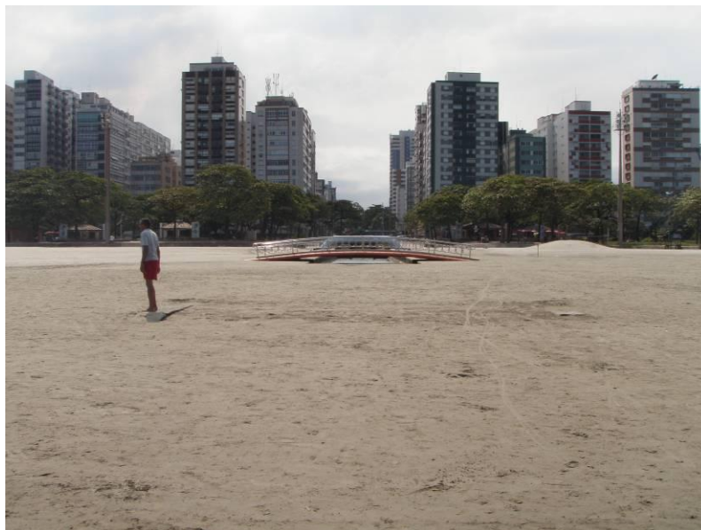
Figura 4.8.3.5-3. Vista da desembocadura do Canal 2 mostrando forte assoreamento e restabelecimento da faixa de praia contínua entre os dois lados do mesmo (05/05/2010).
