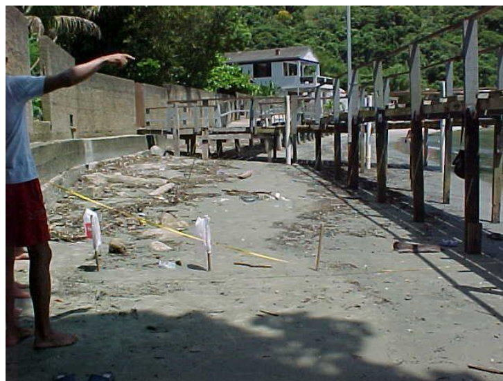
Figura 4.8.3.4-11. Indicadores de erosão I (pós-praia quase inexistente na maré de quadratura e inexistente na maré de sizígia) e II (retrogradação ou recuo da linha de costa e migração vertical do perfil praial) e VIII (destruição de estruturas artificiais construídas na praia). Local do perfil Góes-04 (data: 07/03/2010).
