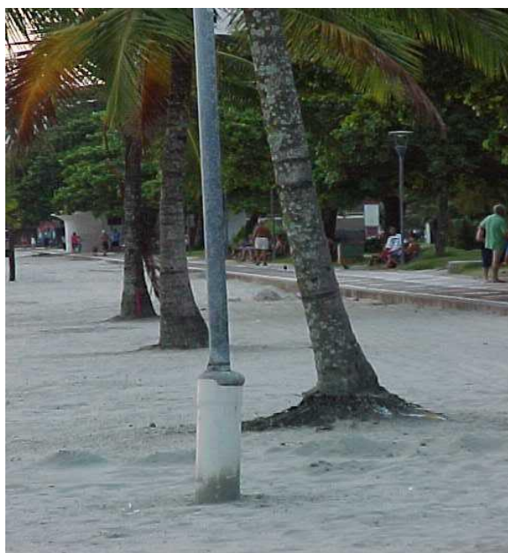
Figura 4.8.3.4-6. Indicadores de erosão V (erosão de faixas frontais de vegetação – coqueiros) e VIII (erosão/destruição de estruturas artificiais construídas na praia e redução do estoque de areia – base da bandeira da Cetesb e raízes dos coqueiros expostas). Local do perfil Stos-19 (Boqueirão) (data: 23/02/2010).
