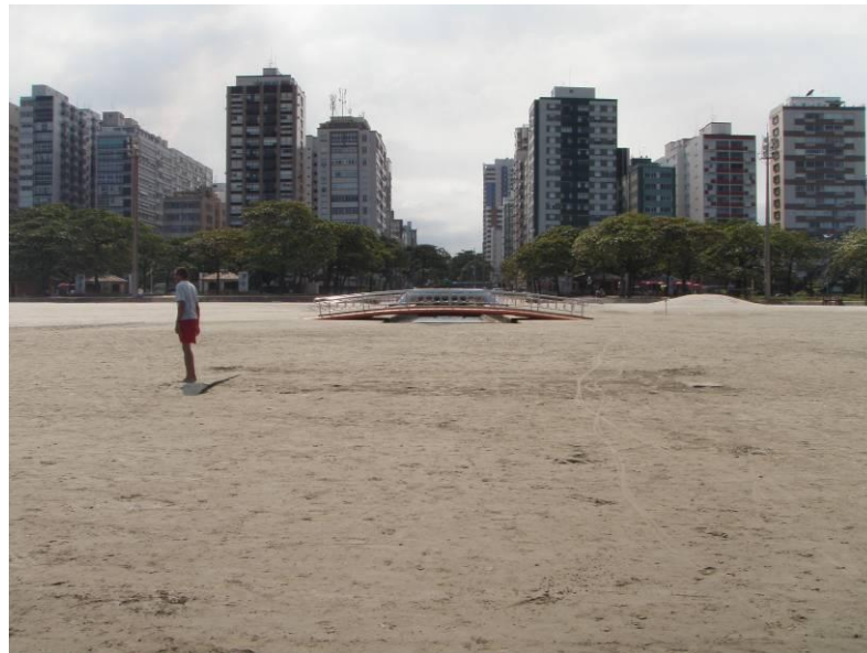
Figura 4.8.3.6-4. Assoreamento de Canal 2 por transporte longitudinal (perfis Stos-08 e Stos-09 em 05/05/2010).
