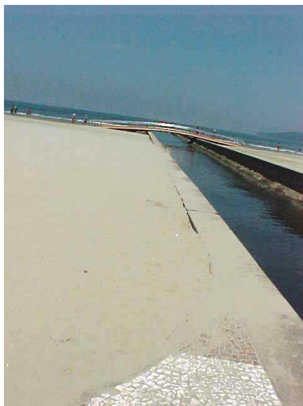
Figura 4.8.3.6-8. Empilhamento sedimentar na pós-praia e soterramento de estruturas urbanas devido à migração do perfil praiar rumo ao continente (Canal 2 – Stos-08/2ª).
