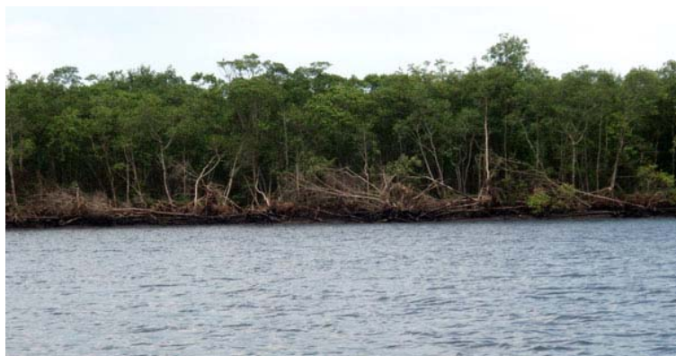
Figura 9.6-2: Margem desbarrancada pelas ondas das embarcações.
