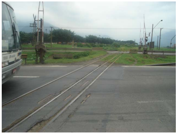
Foto 6: SP055 – a cerca de 300 m da Saída 262 – Cruzamento em nível da rodovia com a via férrea.
