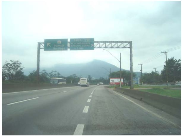
Foto 4: SP055 – km263 pista leste – sinalização indicativa de presença a 1 km da Saída 262 para Av. Plínio de Queiroz e Marginal COSIPA.
