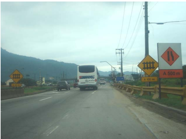
Foto 5: SP055 – proximidades da Saída 262 – Sinalização de advertência de cruzamento em nível da rodovia com linha férrea.
