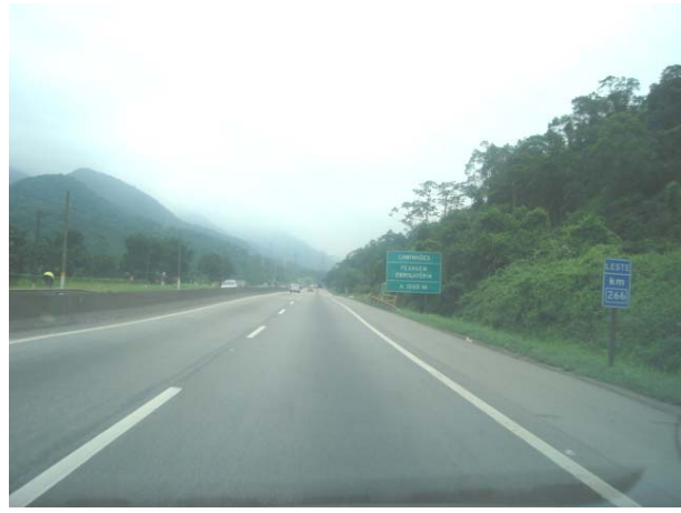
Foto 2: Rodovia SP055 – faixas de rolamento com 3,6m de largura e acostamento com 3,0m de largura.
