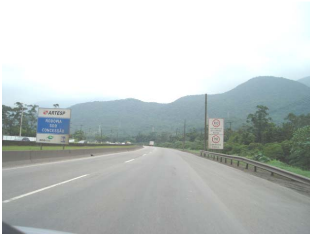
Foto 1: Rodovia SP055 – rodovia de pista dupla com duas faixas de rolamento por sentido. Velocidade regulamentada de 110 km/h para veículos de passeio e de 90km/h para caminhões e ônibus.
