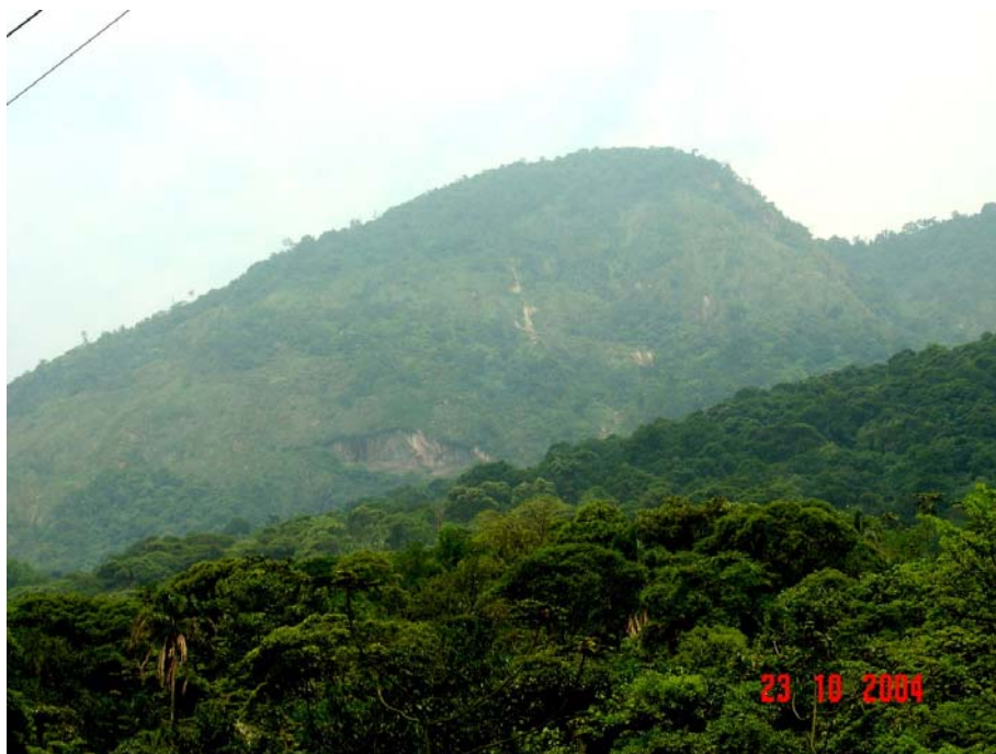
Foto 8.1.3.1 - 3: Ocorrência de instabilizações nas encostas da face norte da Serra do Morrao, sobre rochas granitóides (unidade 22) que sustentam as Escarpas em espigões da Serra do Mar.
