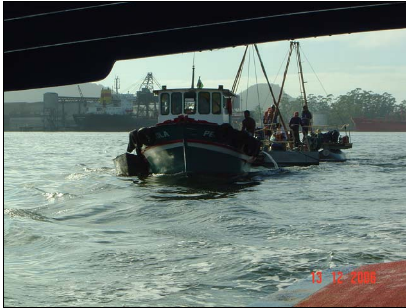
Figura 50: Flutuantes de sondagem a percussão, em operação de reboque para a área dos trabalhos.
