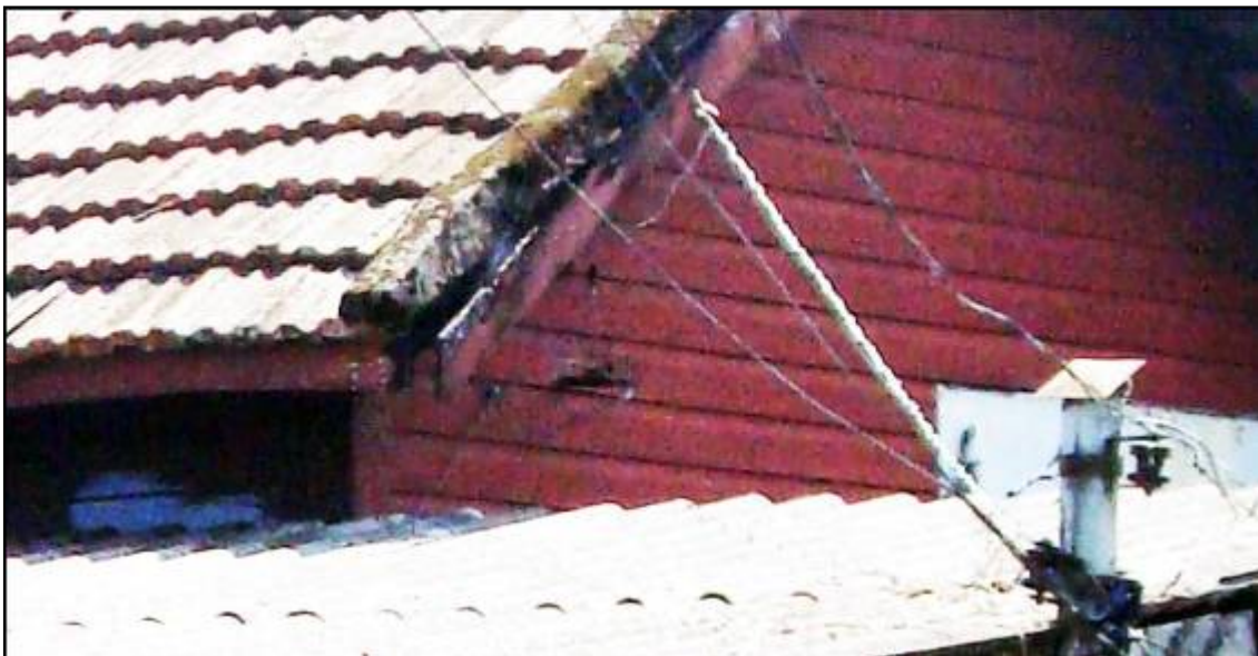
Detalhe do madeiramento de vedação do tipo macho x fêmea.
