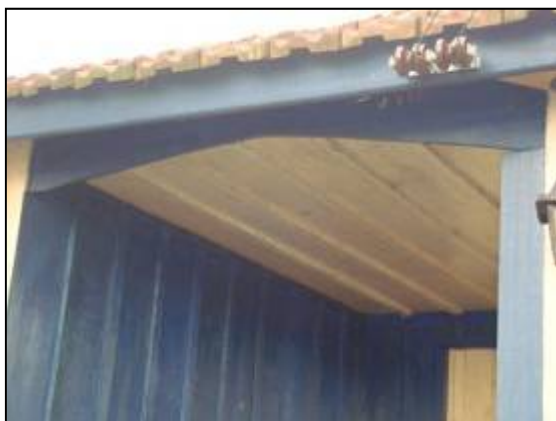
Detalhe do forro de madeira da varanda de chegada.
