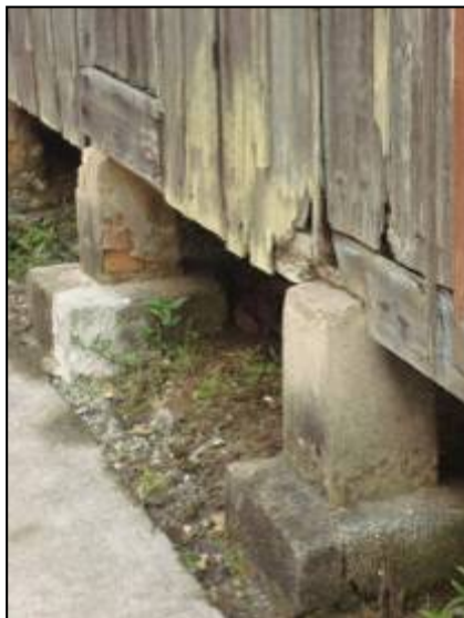
Detalhe da base de concreto.
