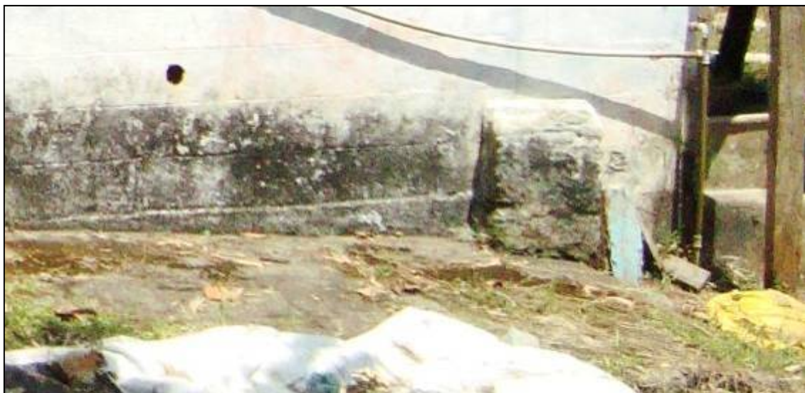
Detalhe: Piso de Pedra, vedação em Bloco de Concreto aparente com caiação, antiga base de sustentação, feita de tijolo de barro.
