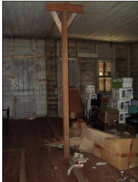
Detalhe da escora do forro de madeira onde antes existia a separação entre as moradias
