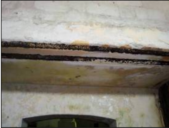
Detalhe da viga metálica (Trilho de trem)
