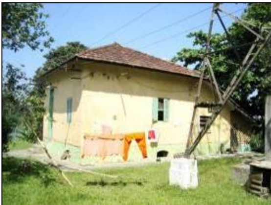
Vista Geral (frontal / lateral direita, detalhe arcabouço).
