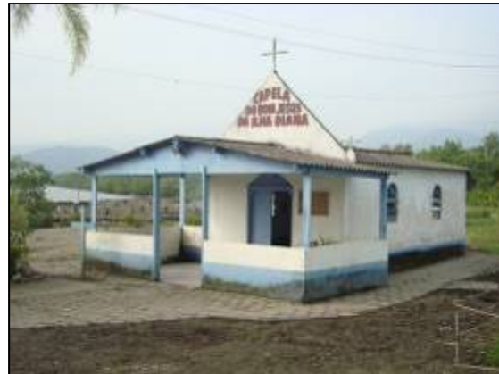
Vista da fachada lateral direita.
