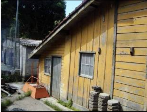
Detalhe do trecho de ampliação, com vedação tipo macho x fêmea e mata junta.
