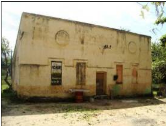
Vista frontal da casa de energia. Detalhe do fechamento dos óculos, meia parede em pedra e meia parede em tijolos e entablamento nas janelas.
