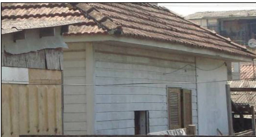
Detalhe do madeiramento de vedação do tipo macho x fêmea.
