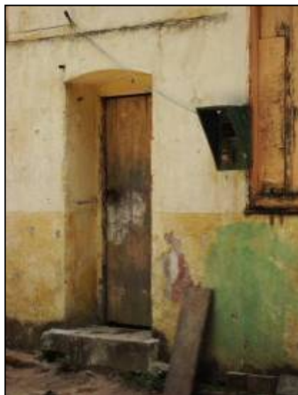
Detalhe da porta de entrada.
