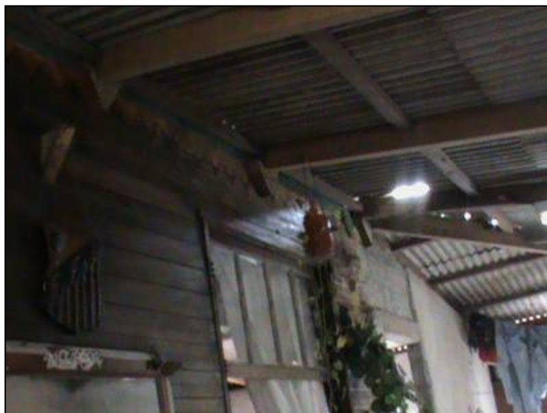
Detalhe da parede de vedação original ( mata junta).
