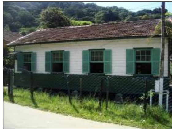
Vista lateral da UBS Monte Cabrão.
