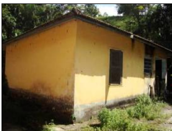
Vista Posterior, detalhe da janela do quarto com entablamento / moldura de argamassa.
