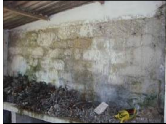
Detalhe parede de pedra.
