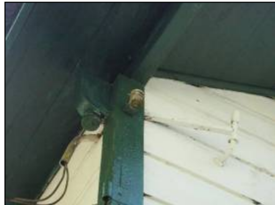
Detalhe do antigo passador externo de fiação.
