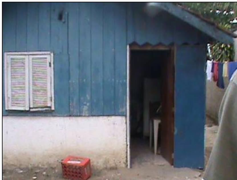
Detalhe entrada, base de concreto.
