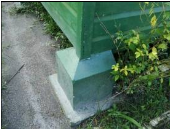
Detalhe da sapata de concreto e base da semi-palafita revestida de concreto.
