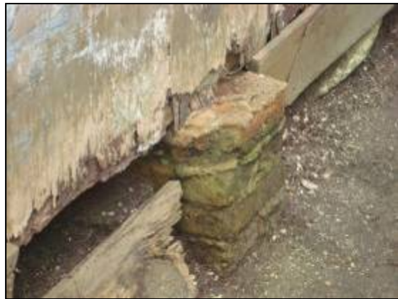
Detalhe da base original de tijolo de barro.
