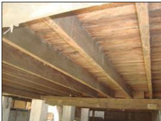
Detalhe do assoalho de madeira.
