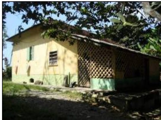
Vista Lateral direita, detalhe do xarabi no trecho de ampliação.
