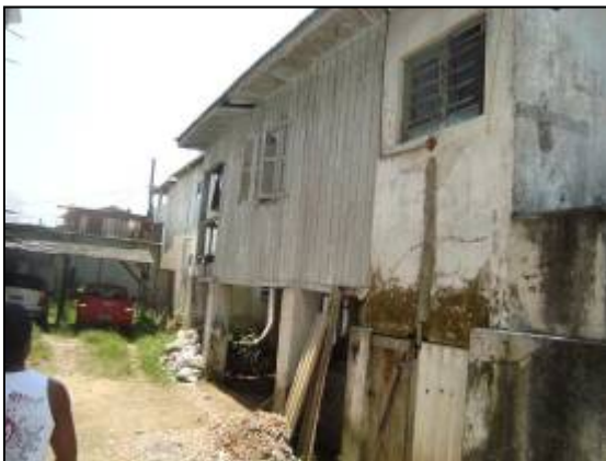
Vista lateral esquerda, detalhe da mudança no tipo de vedação.
