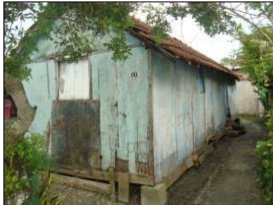
Vista da frente e lateral.
