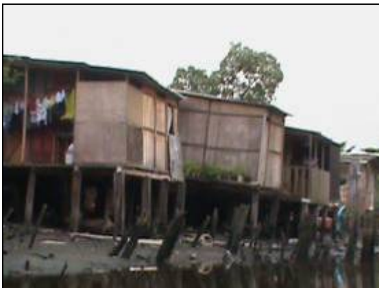
Vista do conjunto de palafitas. Unidades soltas.
