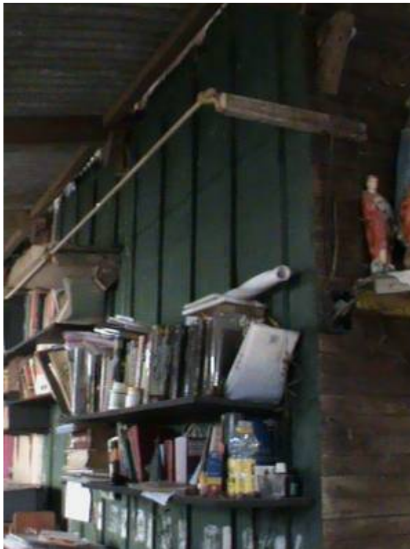
Detalhe da parede de vedação original ( mata junta).
