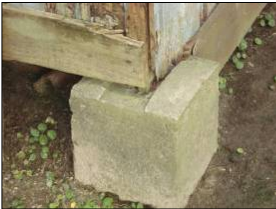
Detalhe da base de concreto.
