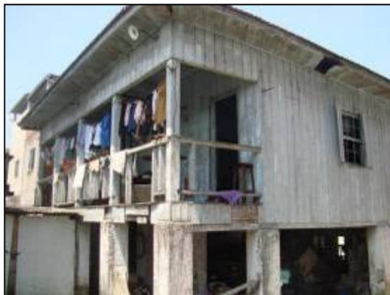
Vista posterior com varanda, madeiramento tipo macho x fêmea.
