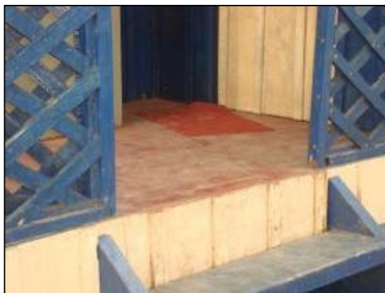
Detalhe do piso de madeira da varanda de chegada
