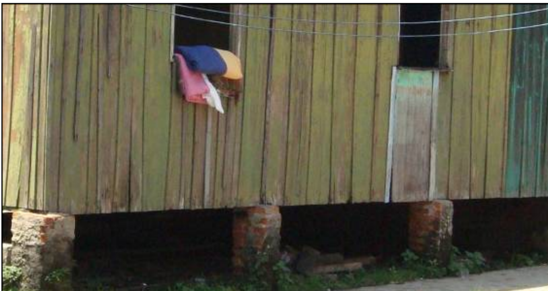
Detalhes: Base em tijolo de barro, porta mexicana, vedação com mata junta.
