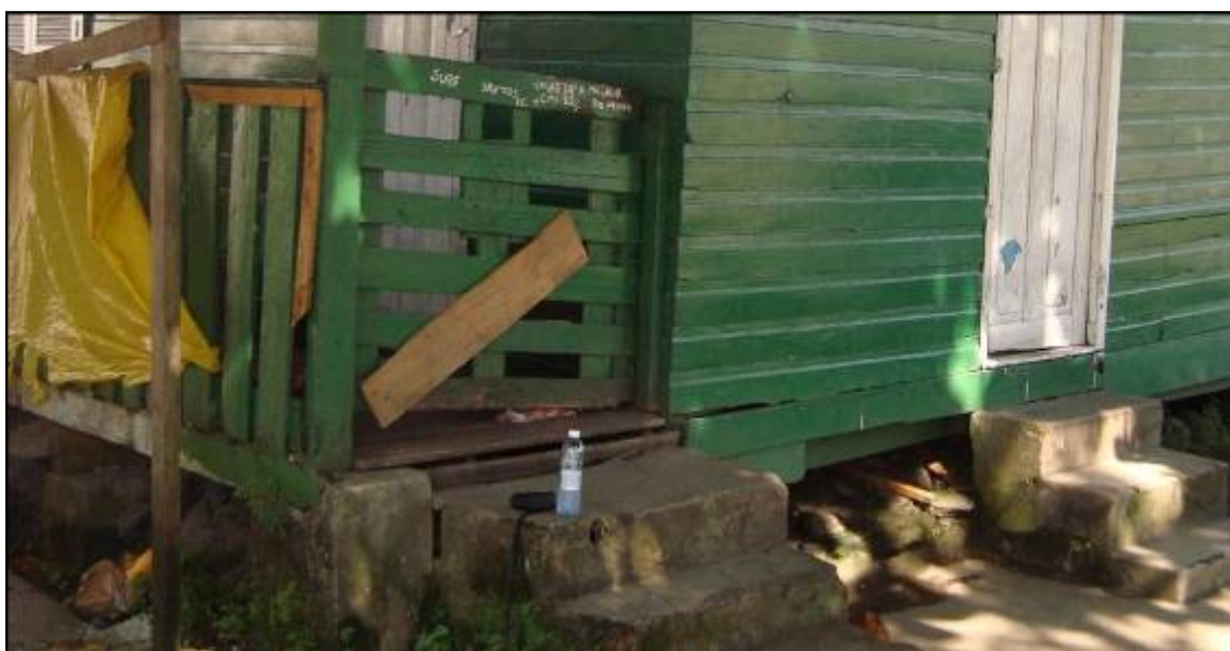
Detalhe da base de pedra e vedação do tipo mata junta.
