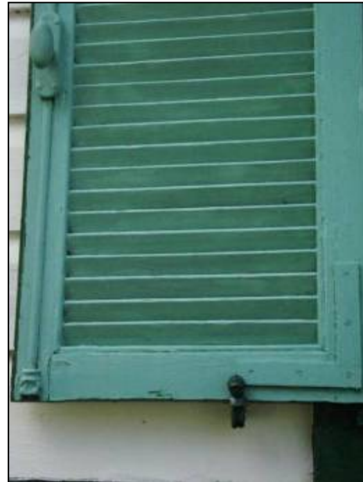
Detalhe do travamento de folha tipo cabeça.
