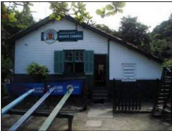
Vista Frontal UBS Monte Cabrão, à direita ampliação em alvenaria.
