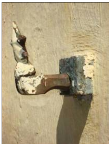
Detalhe do travamento de folha tipo estrela.
