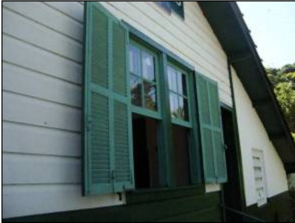
Detalhe da caixilharia original da edificação.
