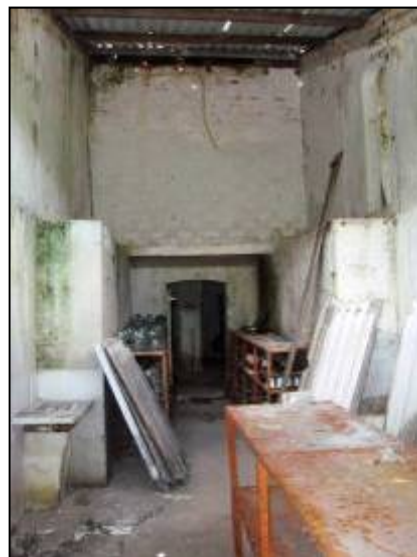
Vista interna, detalhe das paredes onde se apoiava o mezanino.
