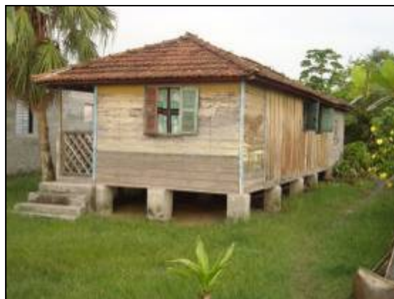
Vista geral, ao fundo anexo em alvenaria de tijolo de barro.
