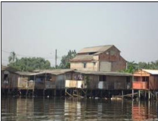
Vista das Palafitas do canal, unidades parcialmente geminadas.
