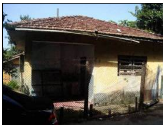
Vista Lateral, detalhe da caixilharia metálica da cozinha e varanda da área de serviço.
