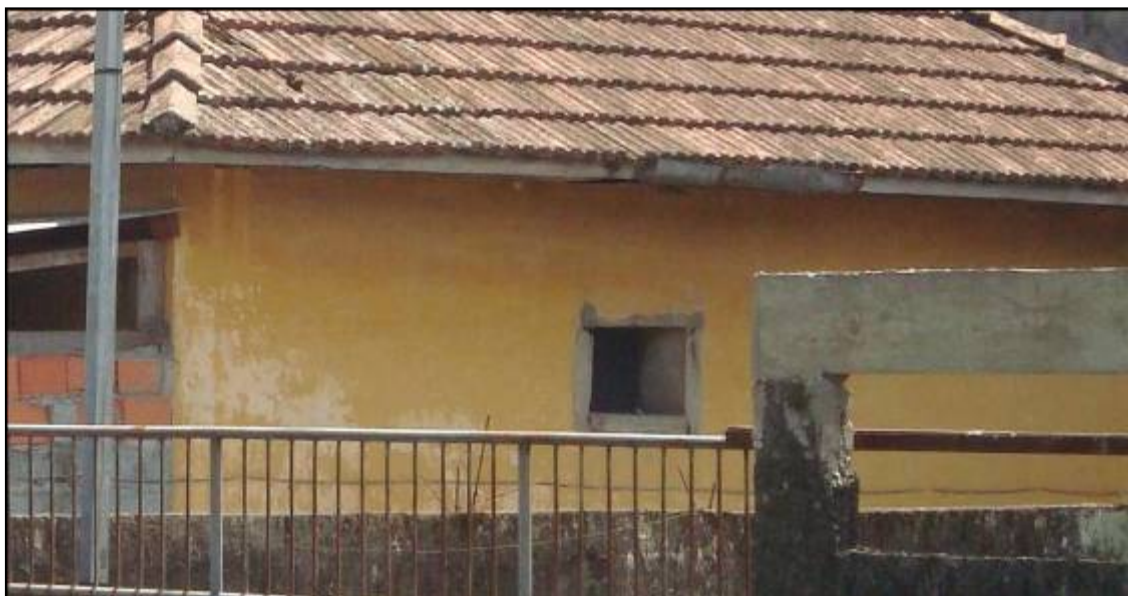
Detalhe da espessura da parede, vão da janela do banheiro.
