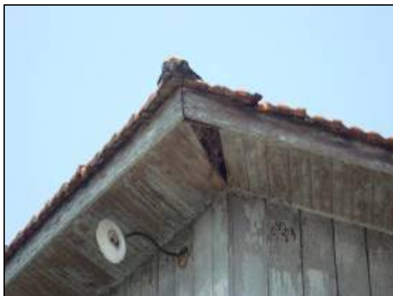
Detalhe do forro com vedação de madeira.
