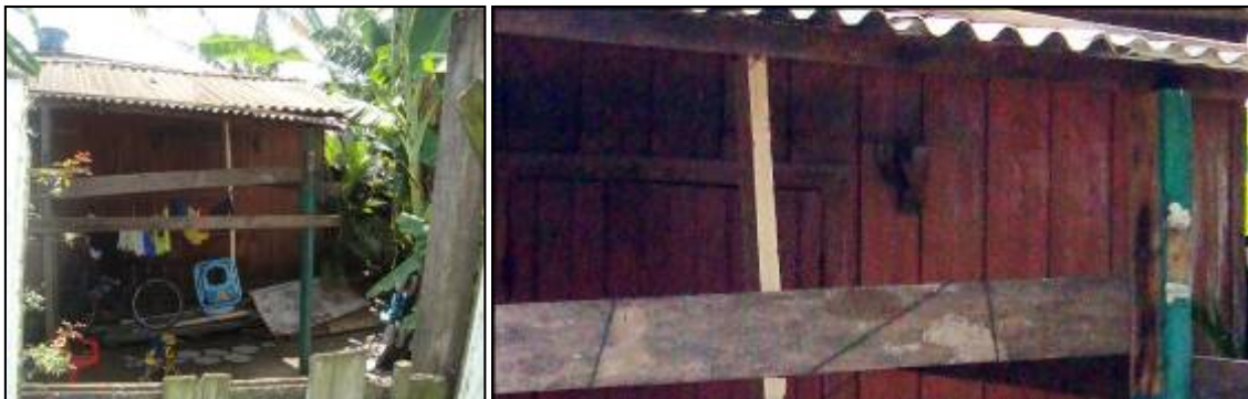
Detalhe do madeiramento de vedação do tipo mata junta.
