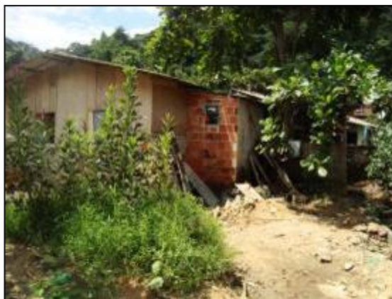
Detalhe da mescla entre materiais: Tijolo Baiano e madeira com mata junta.
