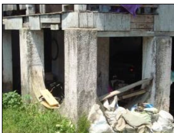
Detalhe da base de sustentação de tijolo de barro.
