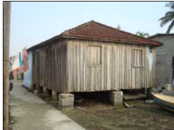
Vista geral, entrada lateral, bloco dos fundos em alvenaria de tijolos.
