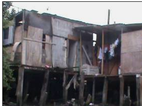
Vista de entrada lateral. Unidades parcialmente geminadas.
