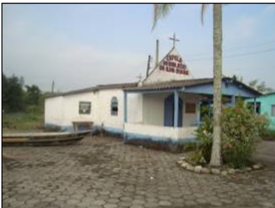
Vista da fachada lateral esquerda.
