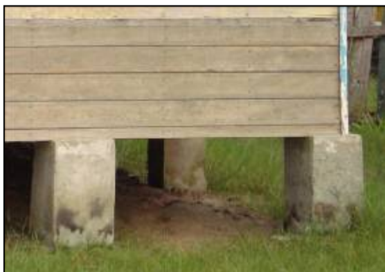
Detalhe da base de tijolo de barro revestida com concreto.
