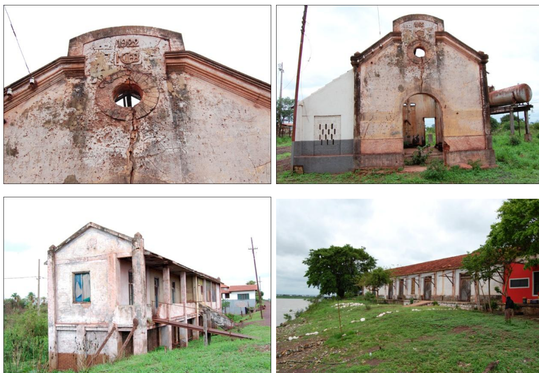
FIGURA 5.3.196 – ANTIGAS EDIFICAÇÕES DA EMPRESA DE TRENS NOROESTE BRASIL FONTE: Os Autores (2010)
