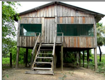
Casa sob palafita
