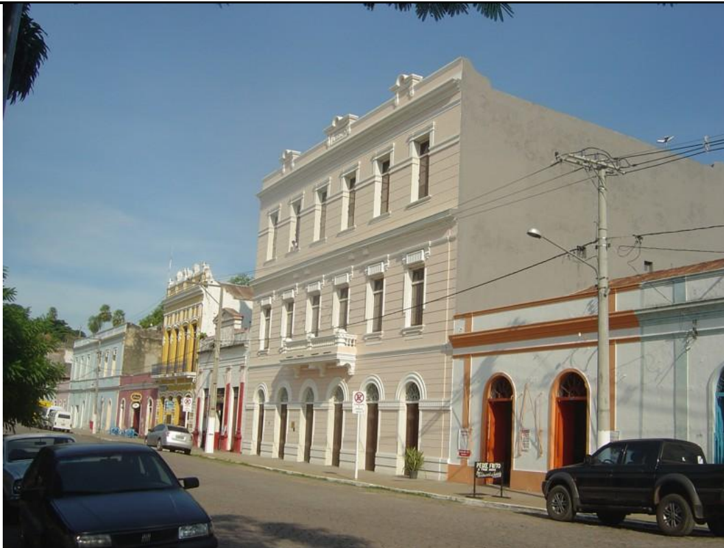
FIGURA 5.3.155 – RESTAURAÇÃO DO PRÉDIO WANDERLEY BAÍS FONTE: Ministério da Cultura (2011)
