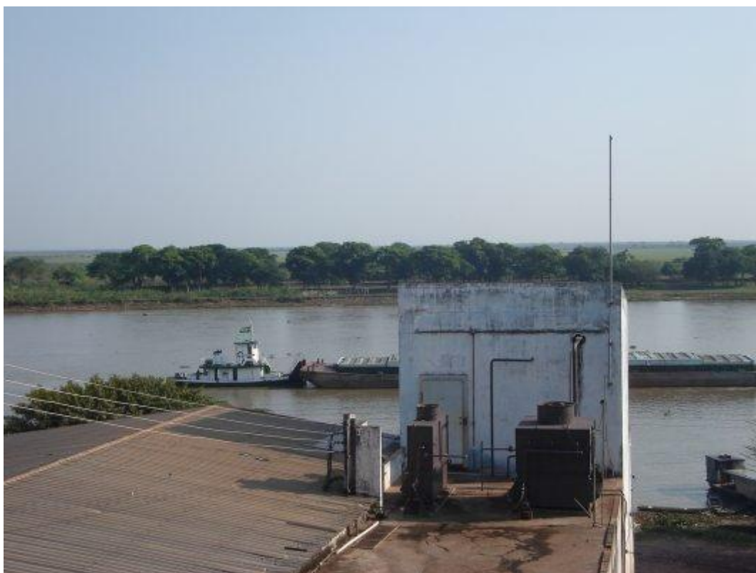
FIGURA 5.3.103 – FOTOGRAFIA DAS MARGENS DO RIO PARAGUAI (LADÁRIO – MS) FONTE: CITYBRAZIL
