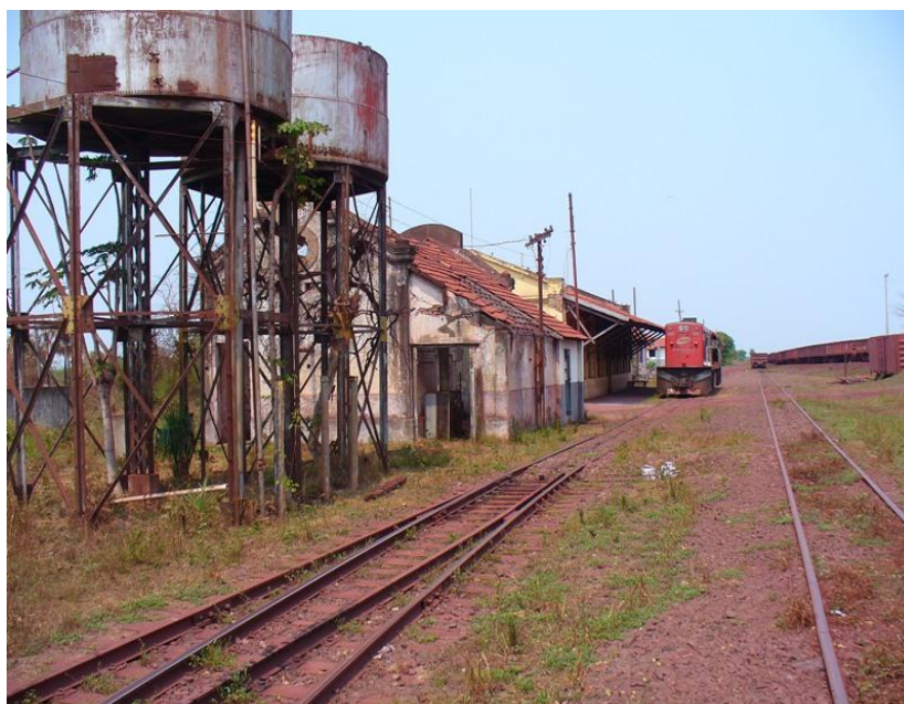
FIGURA 5.3.110 – FOTOGRAFIA DA ESTAÇÃO FERROVIÁRIA DE PORTO ESPERANÇA FONTE: Os Autores (2010)
