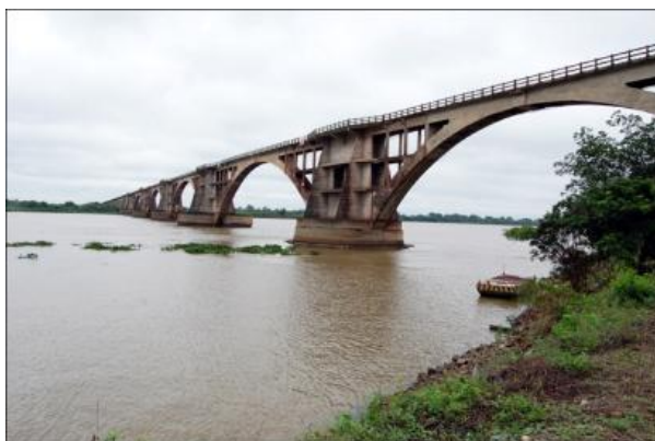
FIGURA 5.3.191 – PONTE PRES. DUTRA FONTE: Os Autores (2010)
