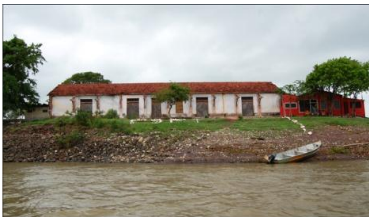
FIGURA 5.3.190 – ANTIGA ESTAÇÃO FERROVIÁRIA PT. ESPERANÇA FONTE: Os Autores (2010)
