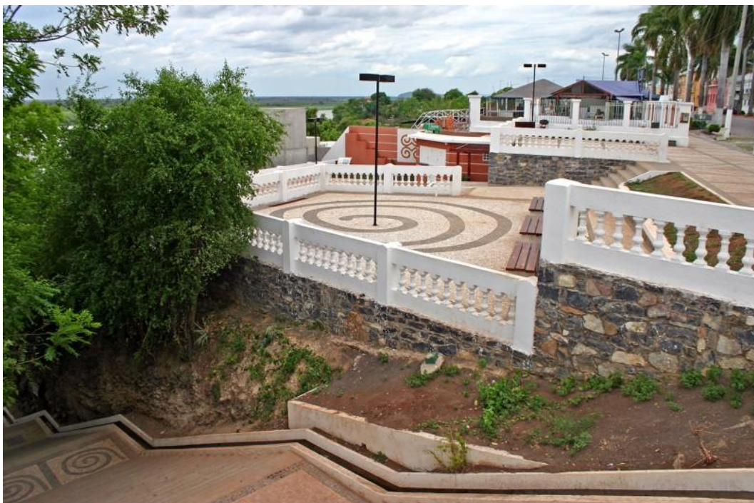
FIGURA 5.3.156 – REVITALIZAÇÃO DA ESCADARIA E PRAÇA GENERAL RONDON FONTE: Ministério da Cultura (2011)
