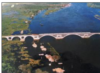
Construção da ponte
