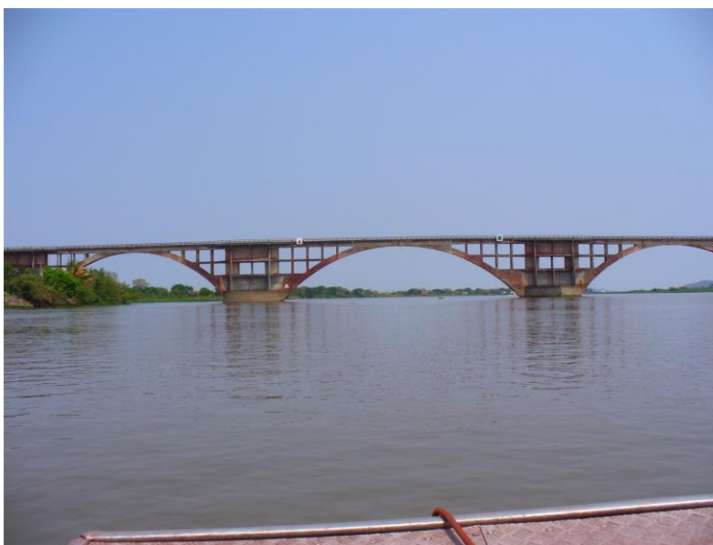
FIGURA 5.3.114 – FOTOGRAFIA DA PONTE FERROVIÁRIA BARÃO DO RIO BRANCO FONTE: Os Autores (2010)
