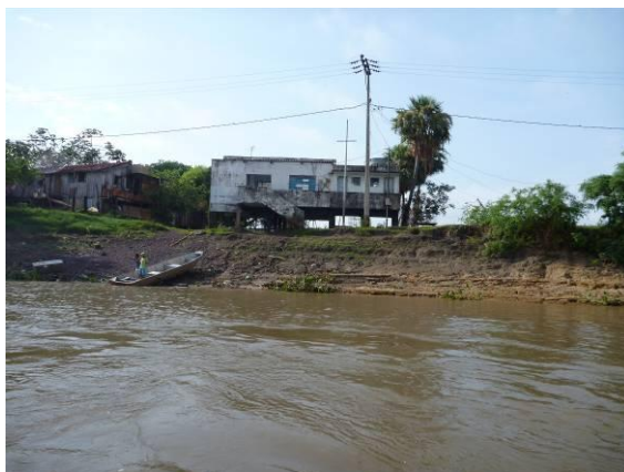
FIGURA 5.2.32 - REGIÃO SEM COBERTURA VEGETAL, NA MARGEM DO RIO PARAGUAI, PARA OCUPAÇÃO URBANA FONTE: Os Autores (2010)
