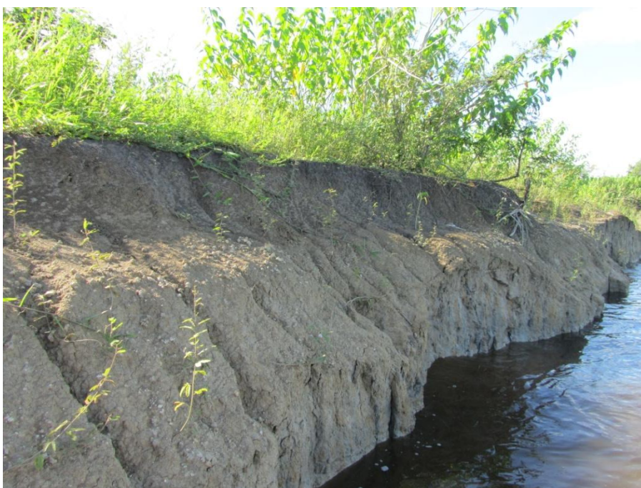
FIGURA 5.1.25 – CURVA DA FIGUEIRINHA MARGEM ESQUERDA, EROSÃO ATUAL EM SEDIMENTOS QUATERNÁRIOS ARGILOSOS FONTE: Os Autores (2010)
