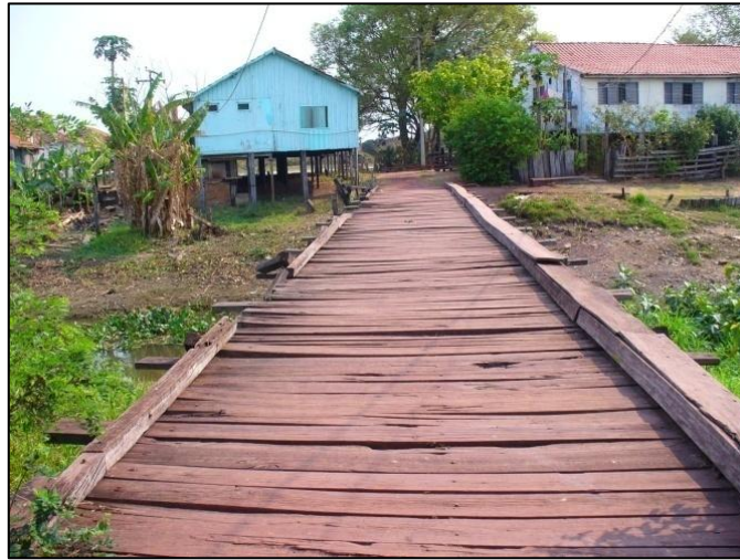
FIGURA 5.1.3 - NÚCLEO POPULACIONAL DE PORTO ESPERANÇA – AS MARGENS DO CORIXO DEZESSETE - PONTILHÃO SOBRE O CORIXO DEZESSETE FONTE: Os Autores (2010)
