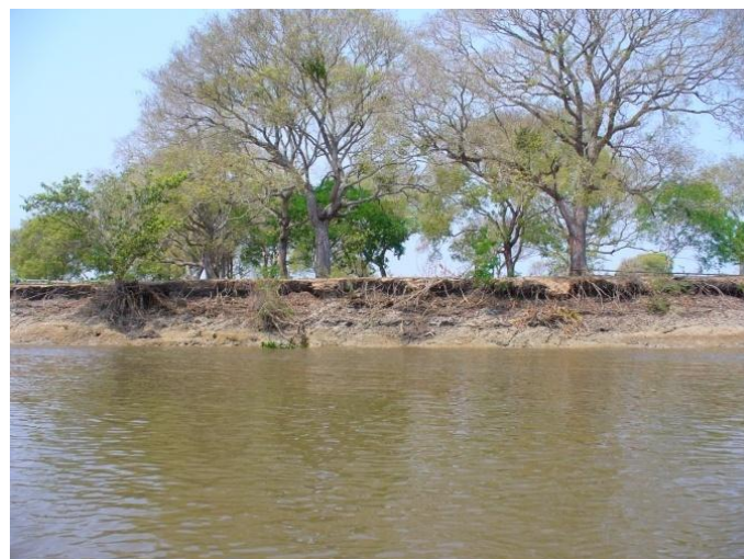
FIGURA 5.1.21 – EROSÃO ACELERADA DA MARGEM DO CANAL FLUVIAL NA MARGEM ESQUERDA DO RIO NA ILHA DA FIGUEIRINHA. LOCAL COM PORTO IMPROVISADO PARA O DESMEMBRAMENTO DE COMBOIOS, NECESSÁRIO A PASSAGEM SOB A PONTE FERROVIÁRIA (A MONTANTE DE PORTO ESPERANÇA)
