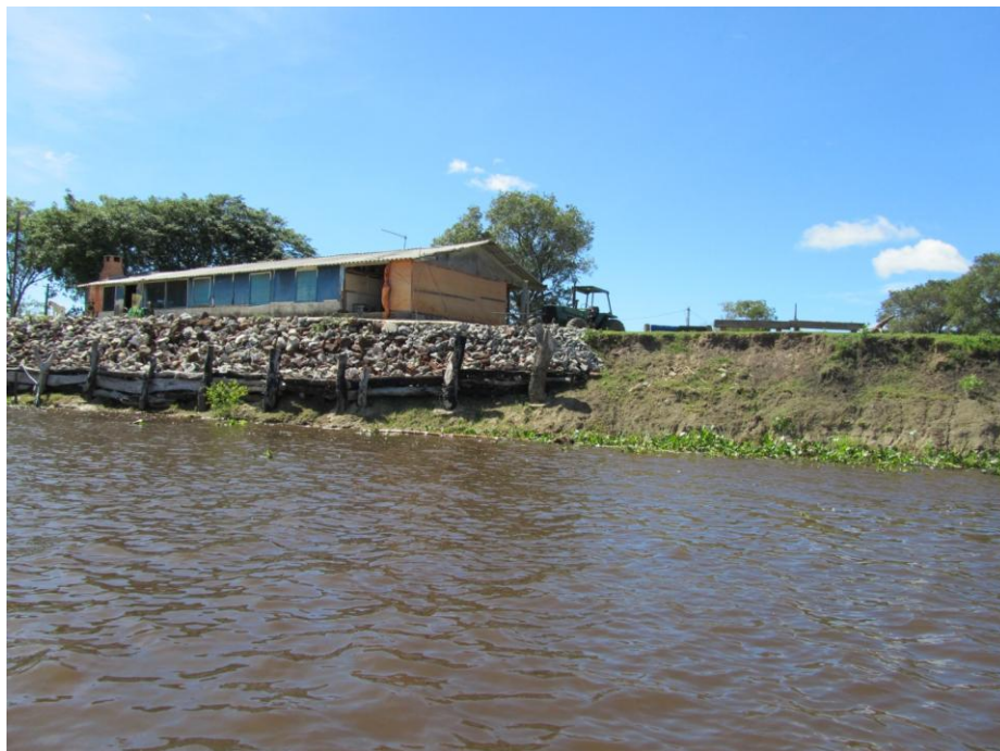
FIGURA 5.1.29 – EROSÃO FLUVIAL MARGEM ESQUERDA EM APP (MATA CILIAR) NO CANAL DA ILHA DA FIGUEIRINHA. FATO RECORRENTE AO LONGO DO TRECHO NA MARGEM ESQUERDA DO RIO, ONDE HÁ SIGNIFICATIVA DEGRADAÇÃO AMBIENTAL, A EXEMPLO DESTA LOCAL UTILIZADO PARA PASTAGEM DE UMA FAZENDA QUE TEM AS INSTALAÇÕES COMPROMETIDAS PELO PROCESSO DE EROSÃO DO RIO
