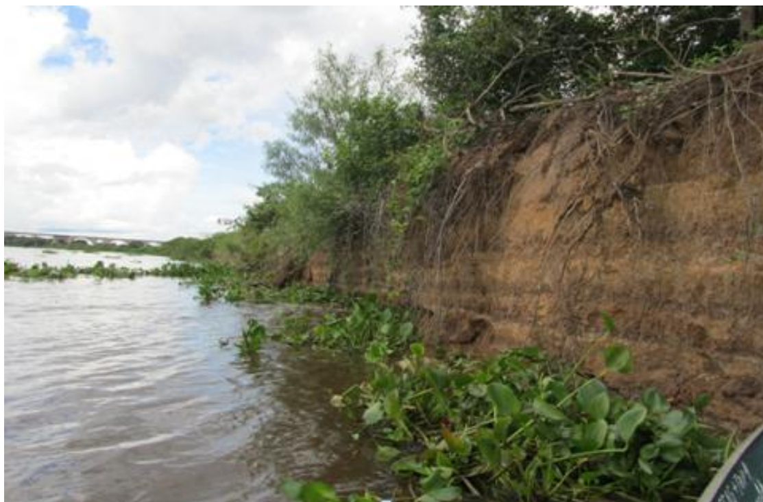
FIGURA 5.1.30 – ILHA DO BAIRRO ALTO (MELANCIA) ORIGINADA PELA REMOBILIZAÇÃO DO MATERIAL DE FUNDO APÓS A CONSTRUÇÃO DA PONTE FERROVIÁRIA CONFORME MORADOR ANTIGO (VIVE NO LOCAL A MAIS DE 50 ANOS), A EROÇÃO ATUAL DESTES SEDIMENTOS ARENO-ARGILOSOS EXPÕEM A ESTRUTURA EM CAMADAS ALTERNADAS COM ESPESSURAS VARIÁVEIS, POSSIVELMENTE RELACIONADAS PELAS MUDANÇAS DE COMPETÊNCIA DE TRANSPORTE DE SEDIMENTOS ATRIBUÍDAS AOS PERÍODOS DE VAZANTES (CAMADAS ESCURAS) E DE CHEIAS (CAMADAS ARENOSAS), BEM COMO, QUANTO AO VOLUME (ESPESSURA DAS CAMADAS) AS FASES DE CHEIAS MAIORES (MAIS PROLONGADAS) OU MENORES E A PERÍODOS DE ESTIAGENS (QUANDO O TEMPO DE ENCHENTES E A EXTENSÃO SÃO MAIS LIMITADOS (CICLOS DE APROXIMADAMENTE 10 ANOS)
