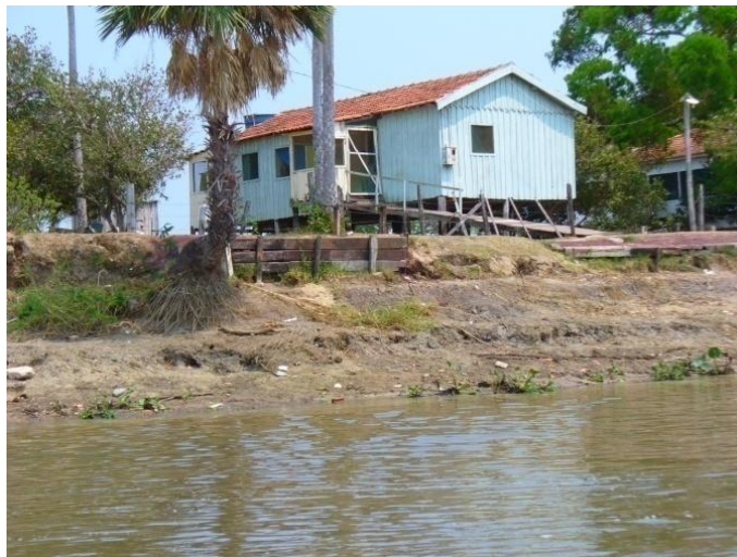
FIGURA 5.1.18 – EROÇÃO DAS MARGENS PRODUZIDA PELA CIRCULAÇÃO DE EMBARCAÇÕES E PELA DINÂMICA DO CANAL FLUVIAL FONTE: Os Autores (2010)
