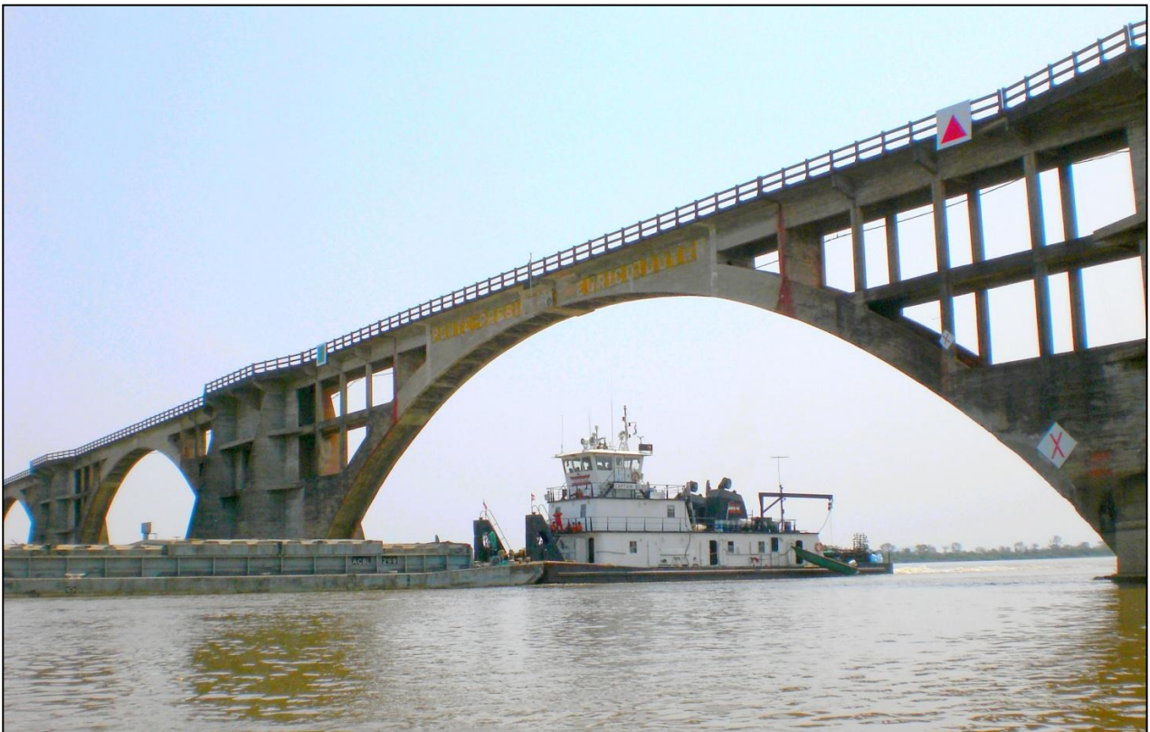
FIGURA 2.1.18 - COMBOIO 2X2 TRANSPONDO A PONTE FERROVIÁRIA FONTE: Os Autores (2010)
