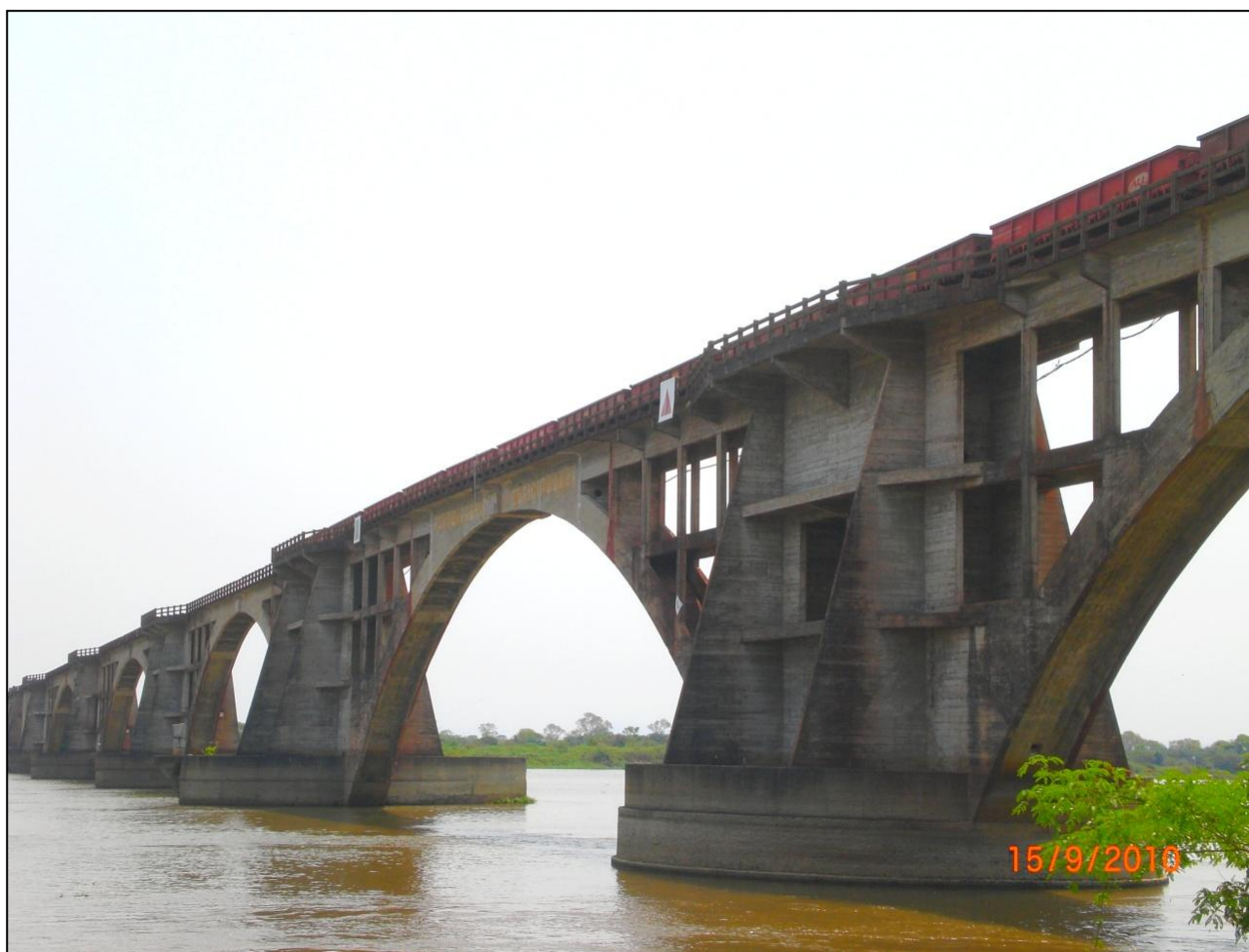
FIGURA 2.1.10 - PONTE FERROVIÁRIA EURICO GASPAR DUTRA FONTE: Os Autores (2010)
