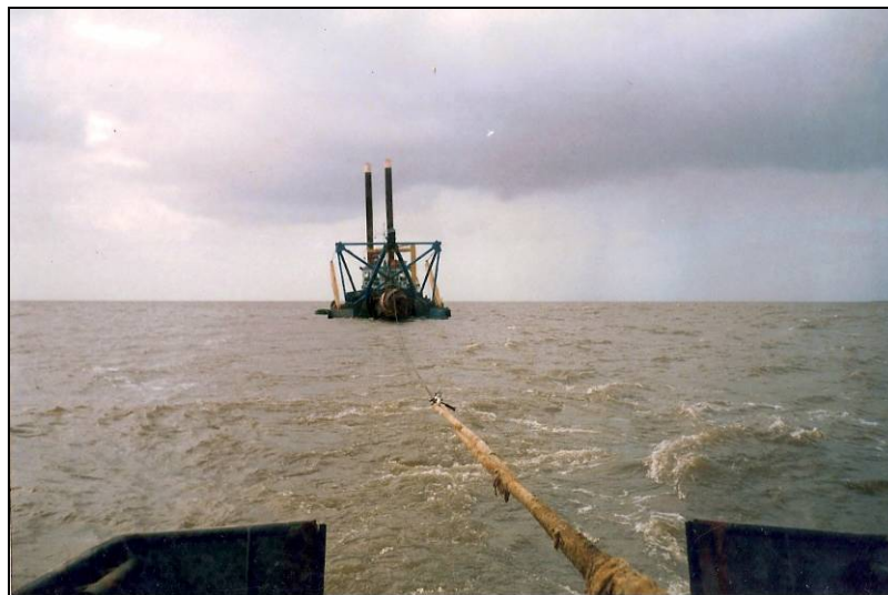
Figura 4 - Vista Da Draga Sendo Rebocada Após Operação Da Mesma. Fonte: CODOMAR (2012).
