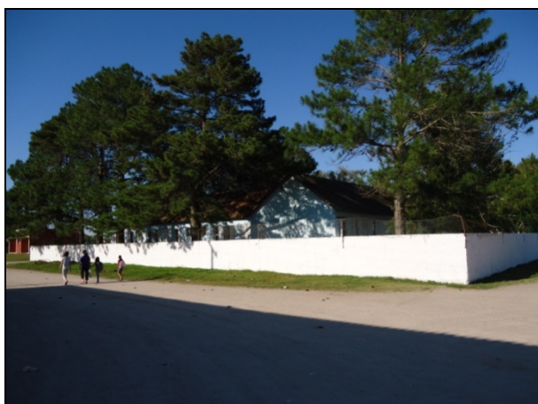
Figura 143 - Escola Estadual de Ensino Fundamental Santa Isabel – Arroio Grande/RS. Fonte: Autores (19/11/2012)
