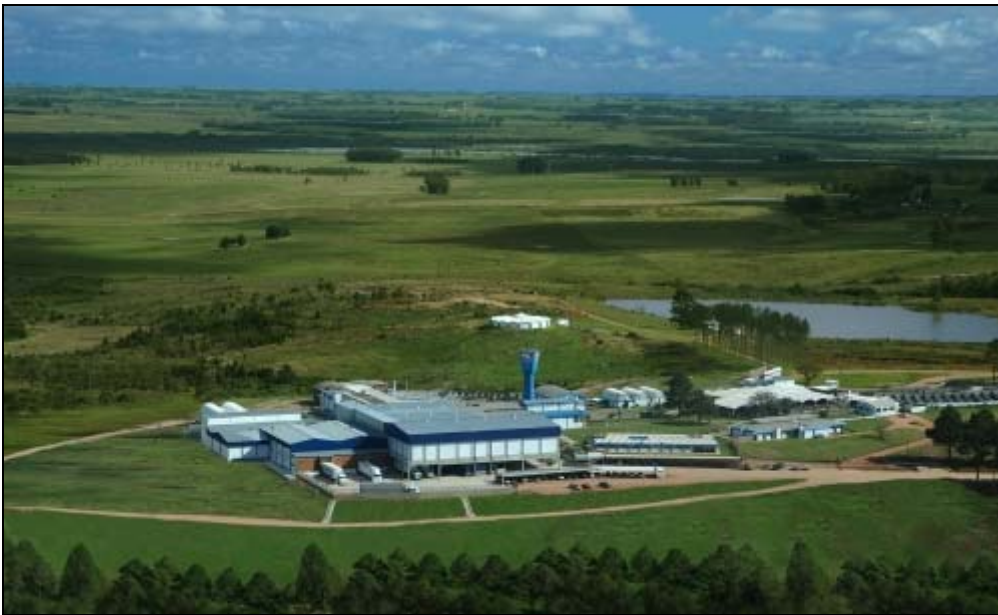
Figura 224 – Unidade Industrial do frigorífico PUL, Melo - Cerro Largo. Fonte: PUL (20/06/2013).
