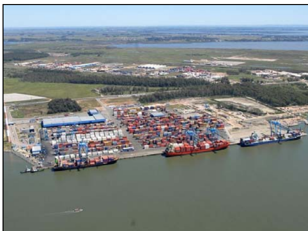
Figura 214 - Vista área do Porto de Rio Grande - Rio Grande.
