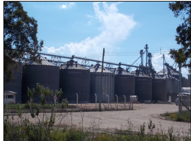
Figura 194 - Silos de armazenamento de grãos - Arroio Grande.
