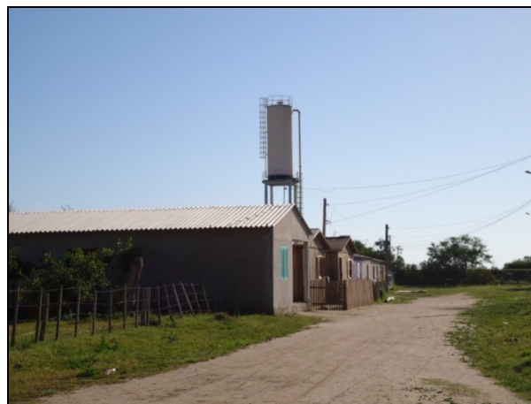
Figura 152 - Ponto de distribuição de água potável para a comunidade de Santa Isabel do Sul. Fonte: Autores (19/11/2012)
